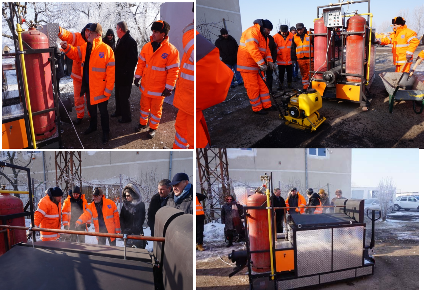
Imagini de la exercițiul practic executat cu utilajul de reparații pe timp friguros
