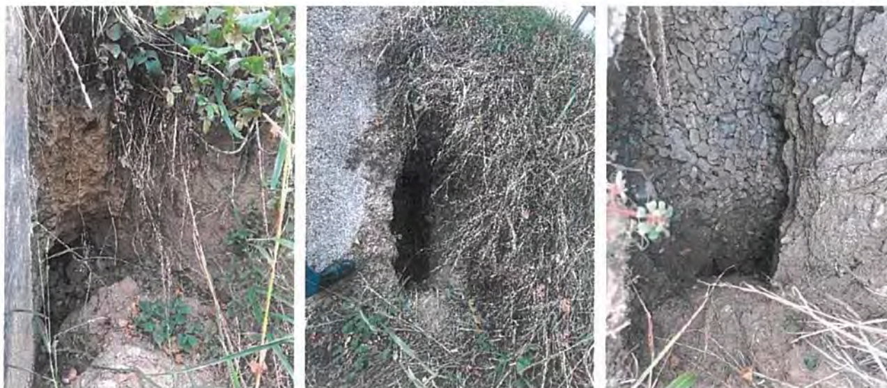
Foto 23 – Ruperea și erodarea taluzului aval
