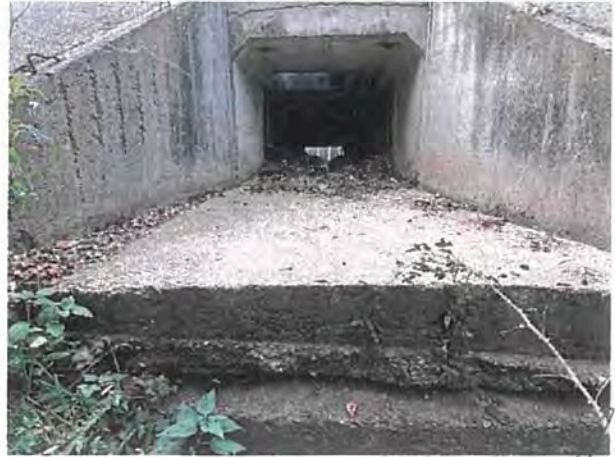
Foto 16 – Pereu din beton monolit pe zona elementelor prefabricate
