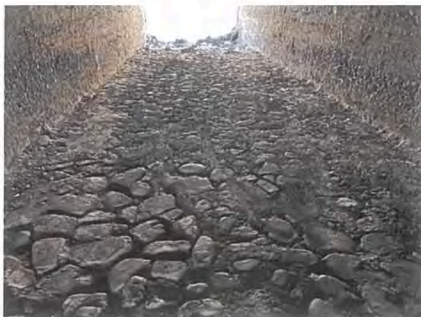
Foto 15 – Pereu din piatră brută în mortar de ciment pe zona podețului monolit
