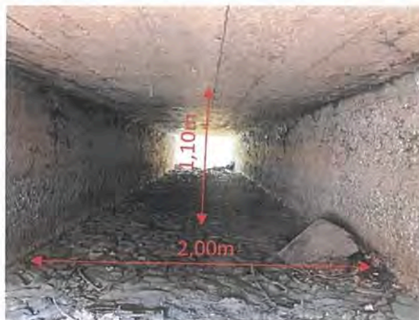
Foto 15 – Pereu din piatră brută în mortar de ciment pe zona podețului monolit
