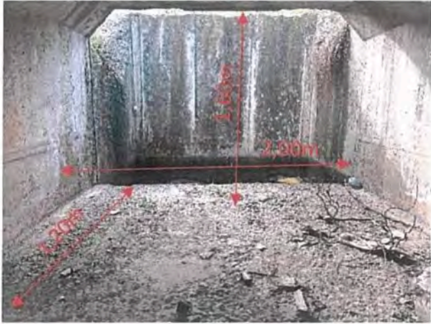
Foto 16 – Pereu din beton monolit pe zona elementelor prefabricate
