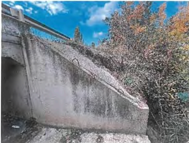
Foto 17 – Aripi prefabricate de tip A0
