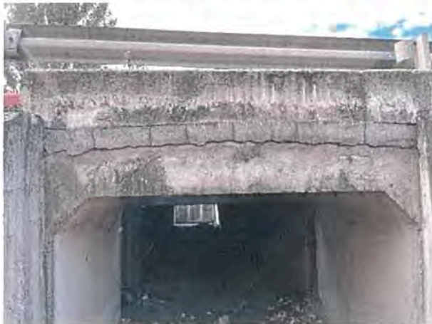
Foto 19 – Timpane prefabricate din beton de tip T2
