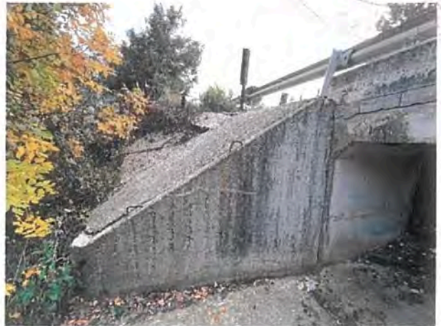
Foto 17 – Aripi prefabricate de tip A0
