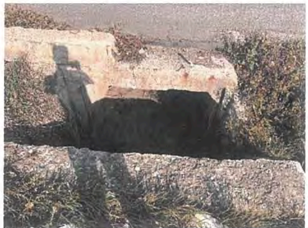
Foto 18 – Cameră de cădere din beton monolit
