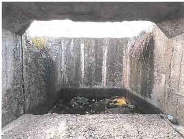
Foto 18 – Cameră de cădere din beton monolit
