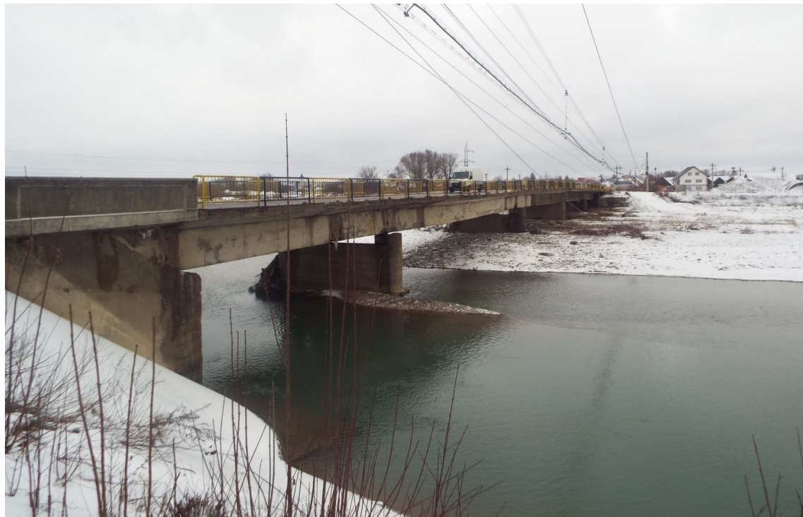
Foto 1. Vedere elevatie pod
