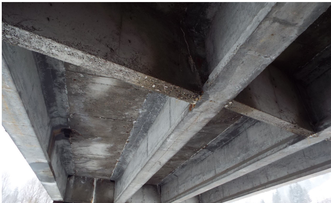
Foto 11. Vedere intrados suprastructura – infiltratii la intrados, infiltratii in antretoazele centrale, lipsa tub prelungitor gura de scurgere, beton de slaba calitate in antretoaze
