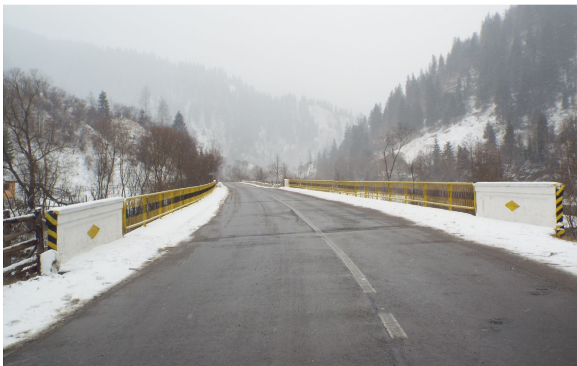
Foto 2. Vedere cale pod
