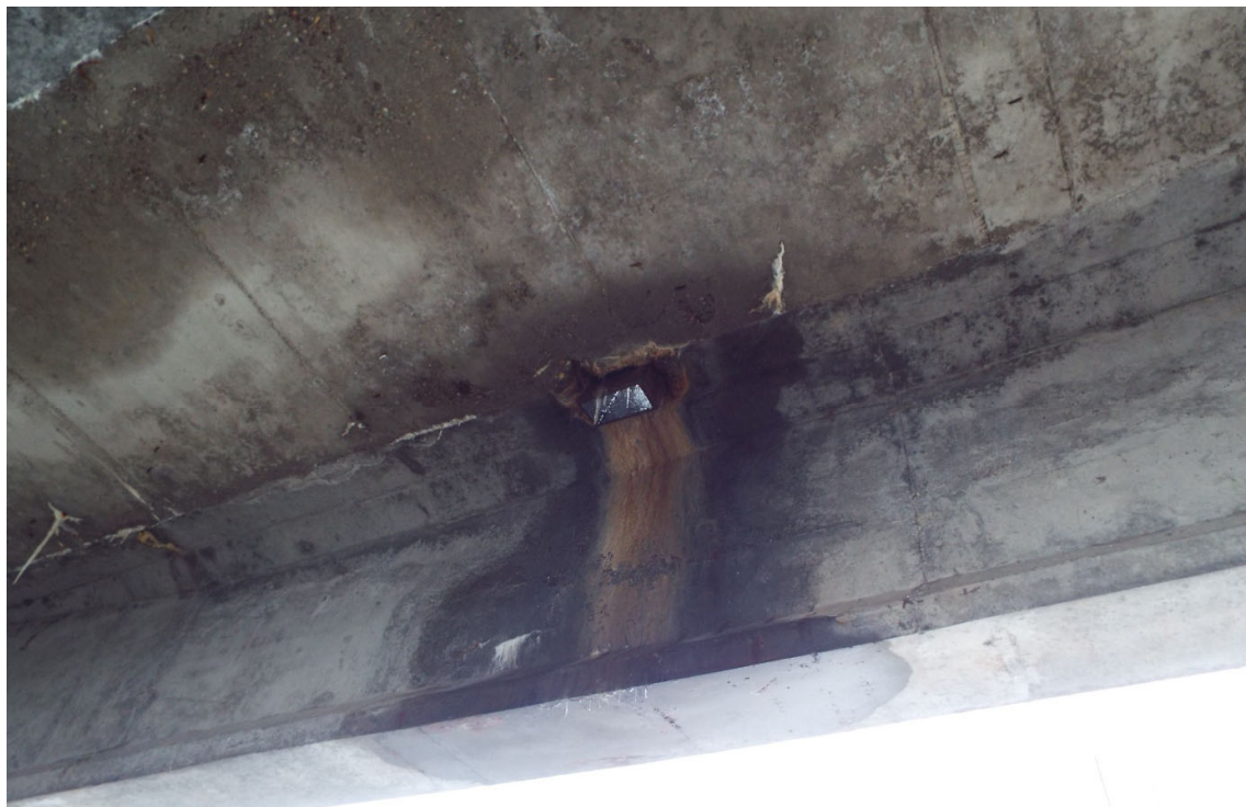
Foto 11. Vedere gura de scurgere – lipsa tub prelungitor, infiltratii in grinda marginala, pete de rugina
