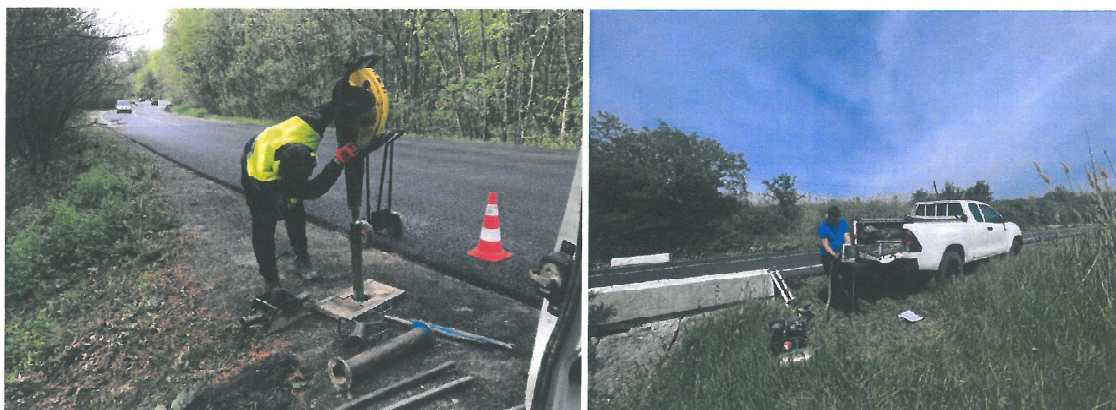
Figura 21. Aparatura folosită la realizarea studiului geotehnic
