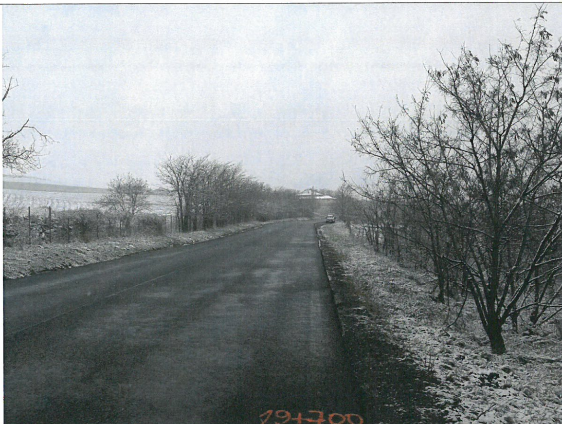
Foto 1: Drumul National DN 28, km 19+700 – 2 benzi de circulatie; lucrari recente de asternere a mixturii asfaltice
