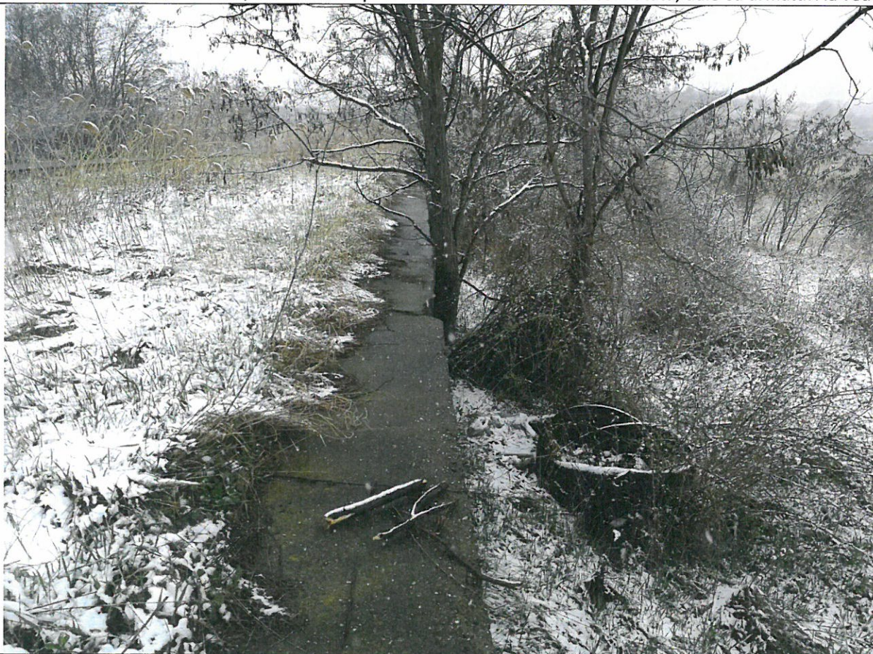
Foto 14: Drumul National DN 28, km 20+070 – zid de sprijin de rambleu din beton.
