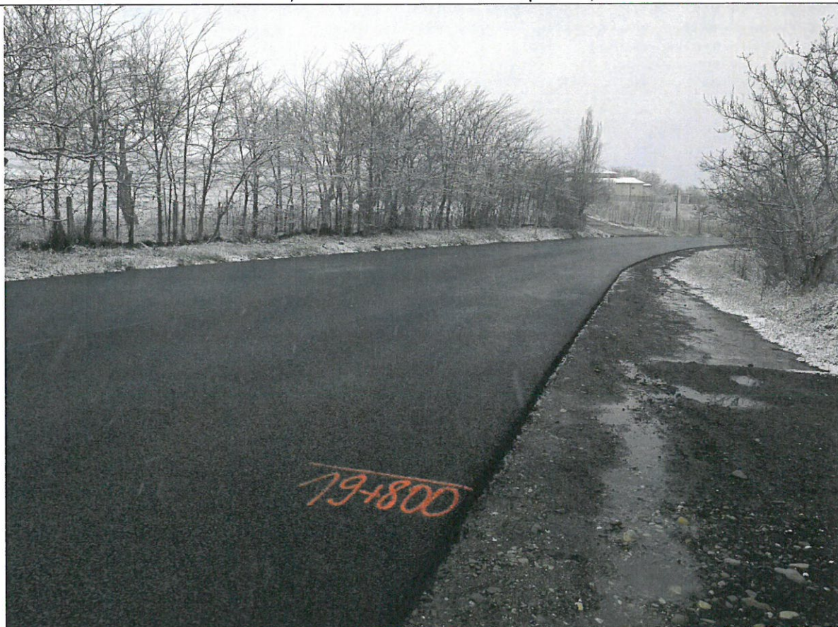
Foto 4: Drumul National DN 28, km 19+800 – lucrari recente de asternere a mixturii asfaltice
