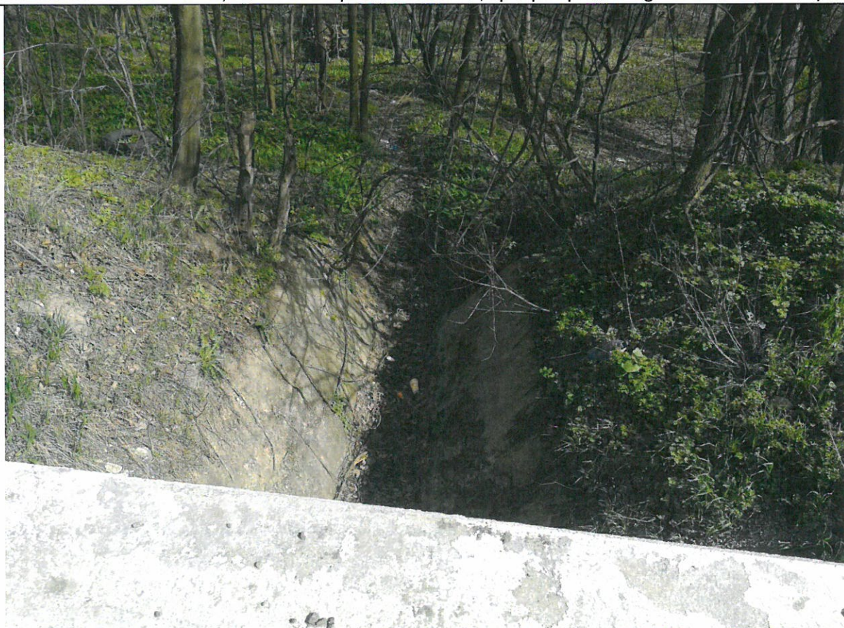
Foto 4: Drumul National DN 28, km 18+240 – podet transversal; vedere aval; - sectiune de evacuare a apelor partial amenajata cu percu din beton.
