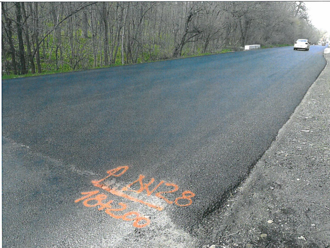
Foto 1: Drumul National DN 28, km 18+200 – 2 benzi de circulatie; lucrari recente de asternere a mixturii asfaltice
