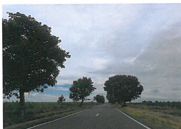
Foto 72: Drumul National DN 24C, km 78+000 – 79+000; 2 benzi de circulatie; imbracaminte asfaltica in stare foarte buna.
