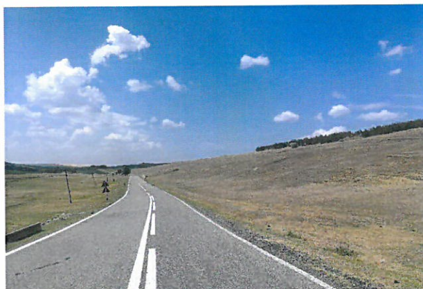
Foto 24: Drumul National DN 24C, km 54+000 – 55+000; 2 benzi de circulatie; imbracaminte asfaltica in stare buna.
