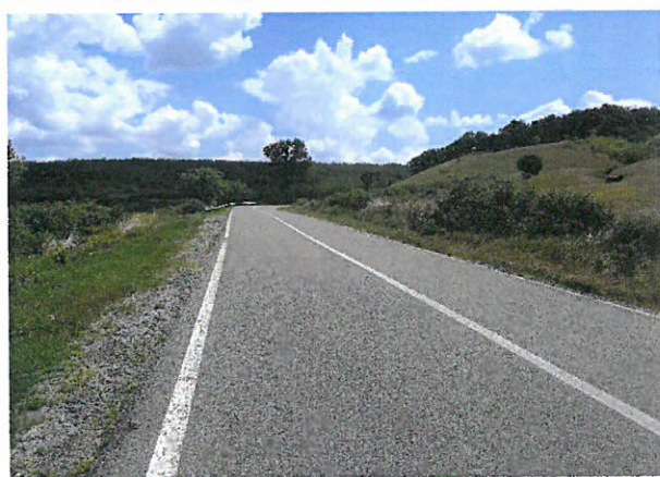
Foto 21: Drumul National DN 24C, km 53+000 – 54+000; 2 benzi de circulatie; imbracaminte asfaltica in stare foarte buna.
