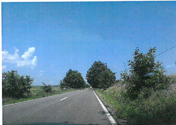
Foto 16: Drumul National DN 24C, km 50+000 – 51+000; 2 benzi de circulatie; imbracaminte asfaltica in stare buna.
