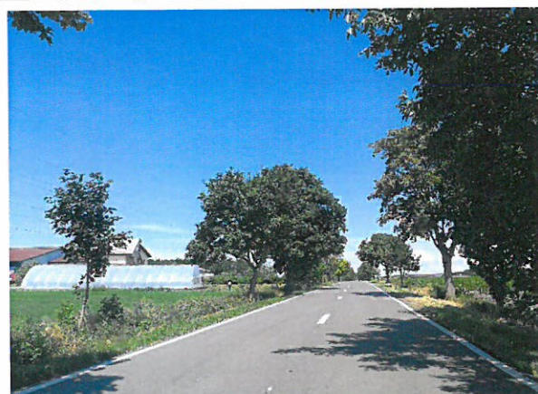
Foto 84: Drumul National DN 24C, km 84+000 – 85+000; 2 benzi de circulatie; imbracaminte asfaltica in stare buna.
