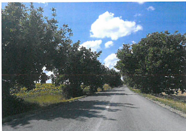
Foto 109: Drumul National DN 24C, km 97+000 – 98+000; 2 benzi de circulatie; imbracaminte asfaltica in stare buna.
