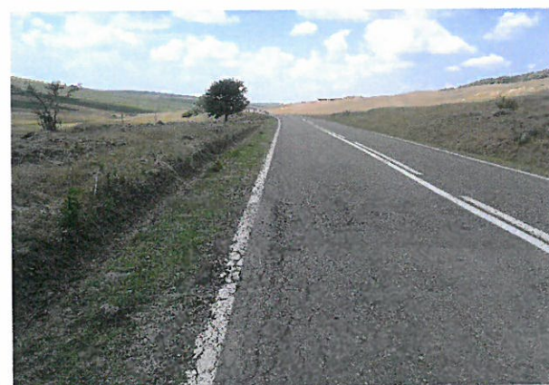
Foto 23: Drumul National DN 24C, km 54+000 – 55+000; 2 benzi de circulatie; imbracaminte asfaltica in stare buna.
