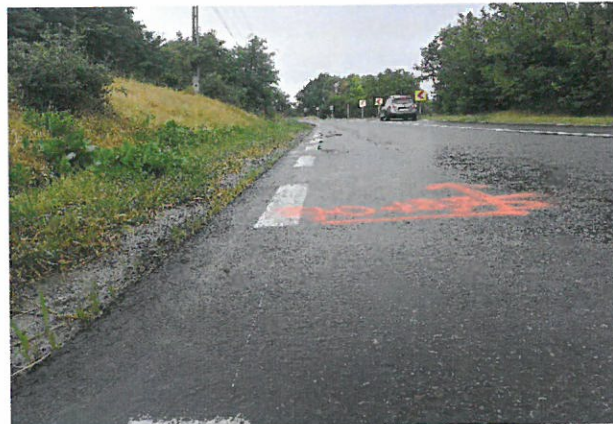
Foto 56: Drumul National DN 24C, km 70+000 – 71+000; 2 benzi de circulatie; imbracaminte asfaltica in stare buna.
