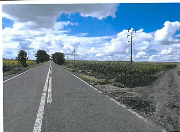
Foto 101: Drumul National DN 24C, km 93+000 – 94+000; 2 benzi de circulatie; imbracaminte asfaltica in stare buna.
