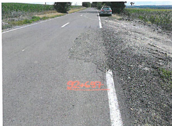
Foto 100: Drumul National DN 24C, km 92+000 – 93+000; 2 benzi de circulatie; imbracaminte asfaltica in stare buna.
