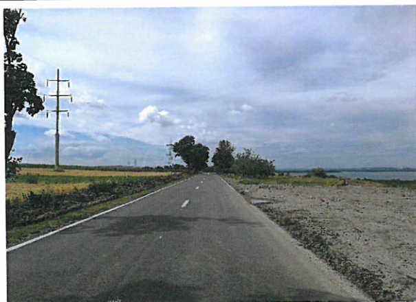
Foto 77: Drumul National DN 24C, km 81+000 – 82+000; 2 benzi de circulatie; imbracaminte asfaltica in stare buna.
