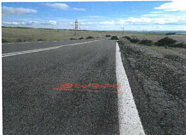
Foto 97: Drumul National DN 24C, km 91+000 – 92+000; 2 benzi de circulatie; imbracaminte asfaltica in stare buna.
