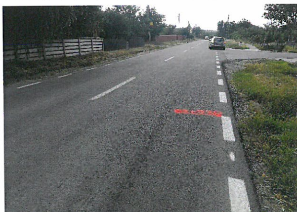
Foto 54: Drumul National DN 24C, km 69+000 – 70+000; 2 benzi de circulatie; imbracaminte asfaltica in stare buna.
