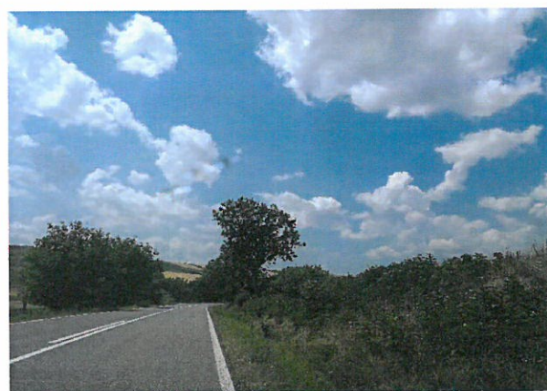
Foto 22: Drumul National DN 24C, km 53+000 – 54+000; 2 benzi de circulatie; imbracaminte asfaltica in stare foarte buna.
