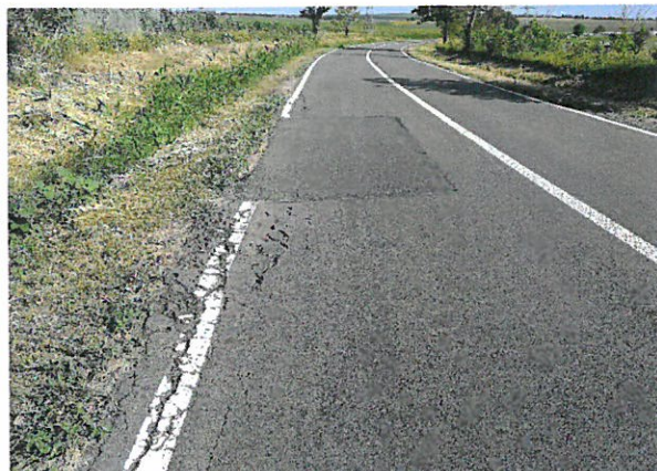
Foto 79: Drumul National DN 24C, km 82+000 – 83+000; 2 benzi de circulatie; imbracaminte asfaltica in stare buna.
