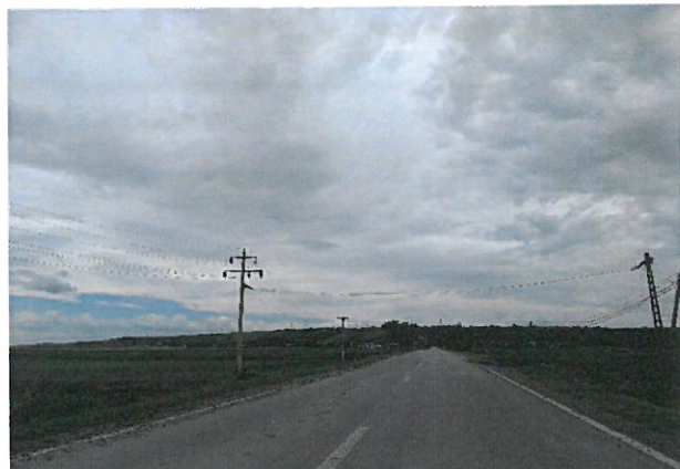
Foto 68: Drumul National DN 24C, km 76+000 – 77+000; 2 benzi de circulatie; imbracaminte asfaltica in stare buna.
