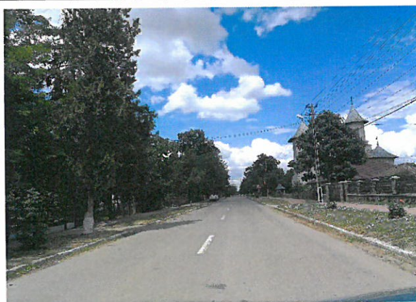
Foto 105: Drumul National DN 24C, km 95+000 – 96+000; 2 benzi de circulatie; imbracaminte asfaltica in stare buna.
