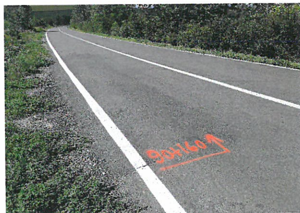
Foto 95: Drumul National DN 24C, km 90+000 – 91+000; 2 benzi de circulatie; imbracaminte asfaltica in stare buna.
