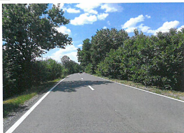
Foto 93: Drumul National DN 24C, km 89+000 – 90+000; 2 benzi de circulatie; imbracaminte asfaltica in stare buna.
