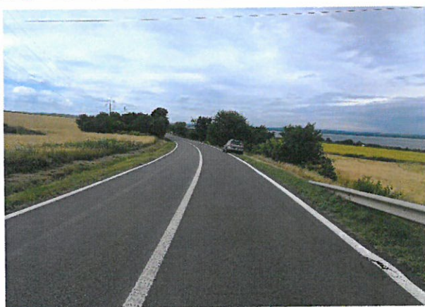
Foto 75: Drumul National DN 24C, km 80+000 – 81+000; 2 benzi de circulatie; imbracaminte asfaltica in stare foarte buna .
