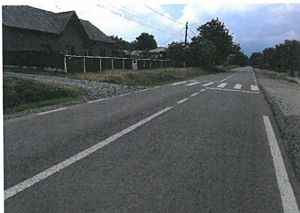
Foto 53: Drumul National DN 24C, km 69+000 – 70+000; 2 benzi de circulatie; imbracaminte asfaltica in stare buna.
