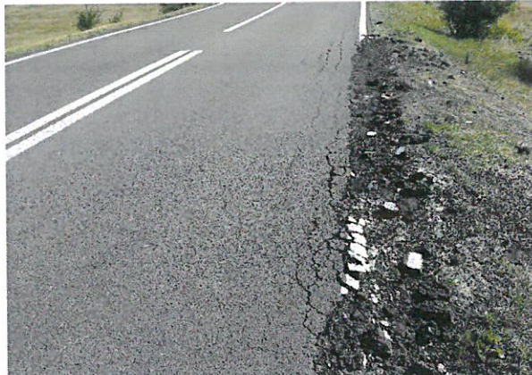
Foto 98: Drumul National DN 24C, km 91+000 – 92+000; 2 benzi de circulatie; imbracaminte asfaltica in stare buna.
