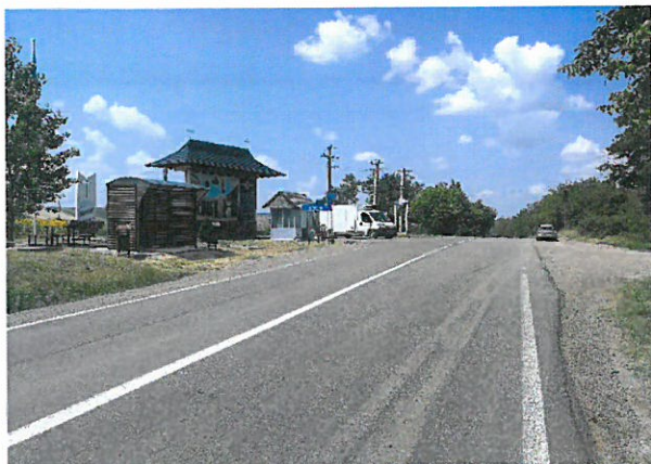
Foto 19: Drumul National DN 24C, km 52+000 – 53+000; 2 benzi de circulatie; imbracaminte asfaltica in stare mediocra.
