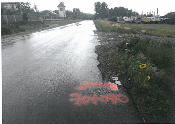
Foto 55: Drumul National DN 24C, km 70+000 – 71+000; 2 benzi de circulatie; imbracaminte asfaltica in stare buna.
