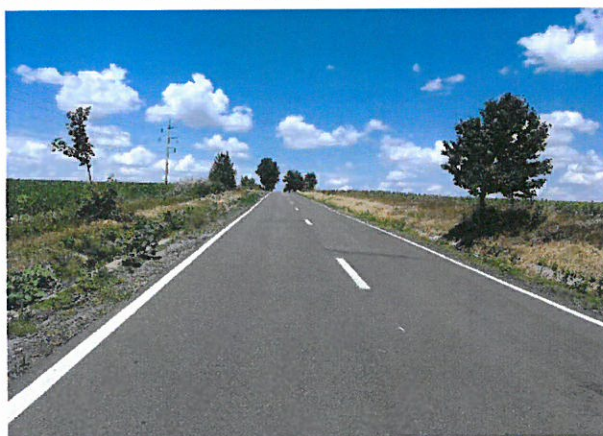
Foto 87: Drumul National DN 24C, km 86+000 – 87+000; 2 benzi de circulatie; imbracaminte asfaltica in stare buna.
