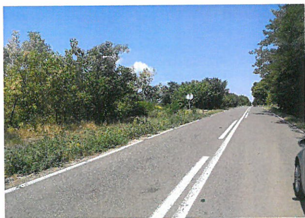
Foto 15: Drumul National DN 24C, km 50+000 – 51+000; 2 benzi de circulatie; imbracaminte asfaltica in stare buna.
