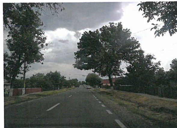
Foto 48: Drumul National DN 24C, km 66+000 – 67+000; 2 benzi de circulatie; imbracaminte asfaltica in stare mediocra.
