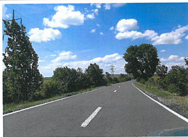
Foto 94: Drumul National DN 24C, km 89+000 – 90+000; 2 benzi de circulatie; imbracaminte asfaltica in stare buna.
