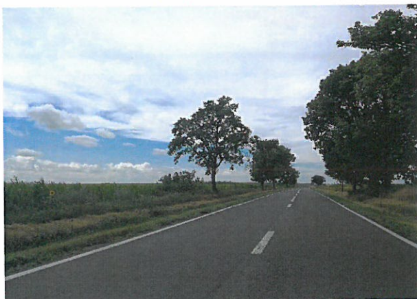
Foto 73: Drumul National DN 24C, km 79+000 – 80+000; 2 benzi de circulatie; imbracaminte asfaltica in stare foarte buna.
