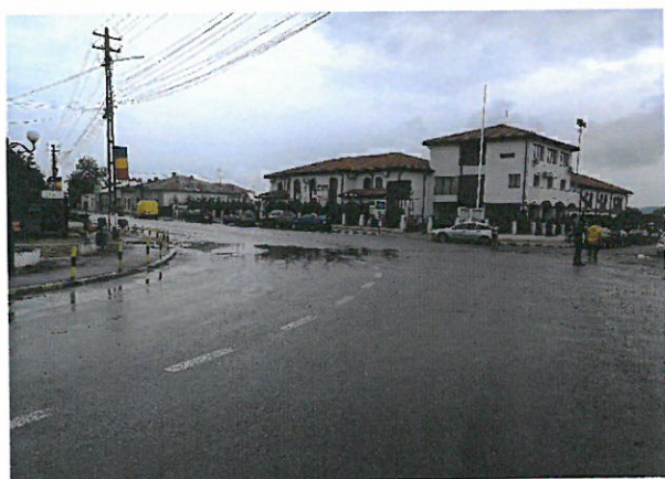
Foto 63: Drumul National DN 24C, km 74+000 – 75+000; 2 benzi de circulatie; imbracaminte asfaltica in stare mediocra/rea.
