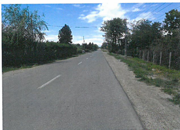
Foto 106: Drumul National DN 24C, km 95+000 – 96+000; 2 benzi de circulatie; imbracaminte asfaltica in stare buna.
