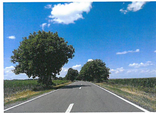
Foto 88: Drumul National DN 24C, km 86+000 – 87+000; 2 benzi de circulatie; imbracaminte asfaltica in stare buna.
