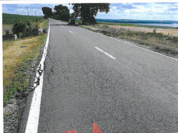
Foto 99: Drumul National DN 24C, km 92+000 – 93+000; 2 benzi de circulatie; imbracaminte asfaltica in stare buna.
