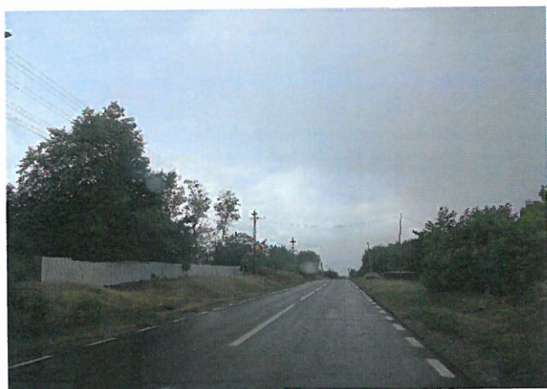
Foto 57: Drumul National DN 24C, km 71+000 – 72+000; 2 benzi de circulatie; imbracaminte asfaltica in stare foarte buna.
