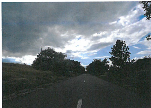
Foto 112: Drumul National DN 24C, km 98+000 – 99+000; 2 benzi de circulatie; imbracaminte asfaltica in stare buna.
