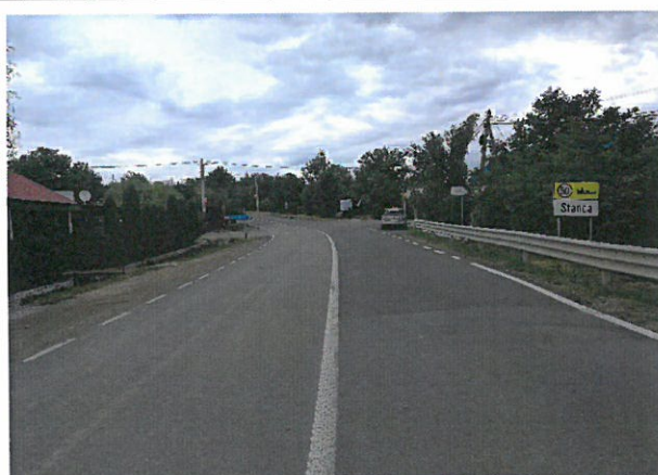
Foto 69: Drumul National DN 24C, km 77+000 – 78+000; 2 benzi de circulatie; imbracaminte asfaltica in stare foarte buna.
