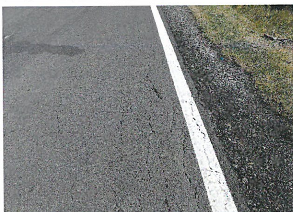
Foto 81: Drumul National DN 24C, km 83+000 – 84+000; 2 benzi de circulatie; imbracaminte asfaltica in stare buna.
