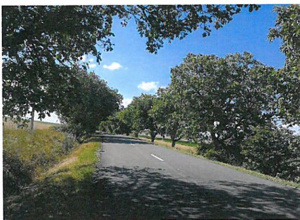
Foto 111: Drumul National DN 24C, km 98+000 – 99+000; 2 benzi de circulatie; imbracaminte asfaltica in stare buna.
