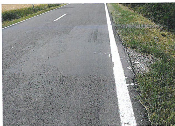
Foto 76: Drumul National DN 24C, km 80+000 – 81+000; 2 benzi de circulatie; imbracaminte asfaltica in stare foarte buna .
