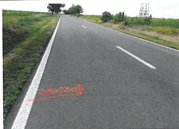
Foto 71: Drumul National DN 24C, km 78+000 – 79+000; 2 benzi de circulatie; imbracaminte asfaltica in stare foarte buna .
