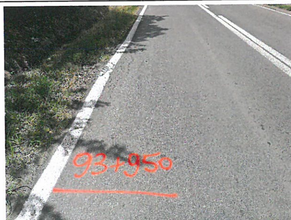
Foto 102: Drumul National DN 24C, km 93+000 – 94+000; 2 benzi de circulatie; imbracaminte asfaltica in stare buna.
