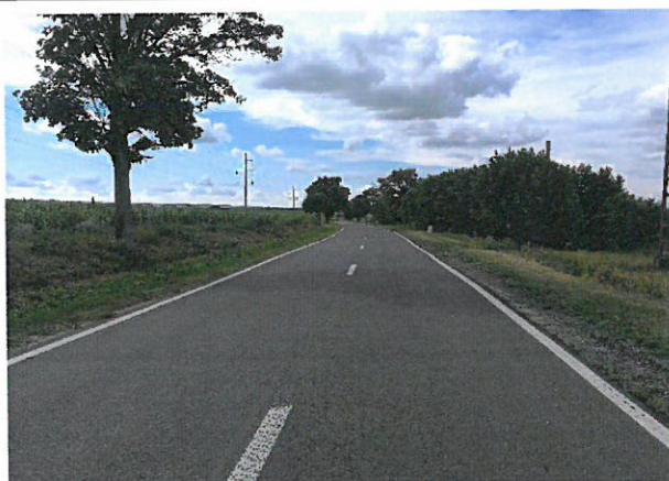
Foto 78: Drumul National DN 24C, km 81+000 – 82+000; 2 benzi de circulatie; imbracaminte asfaltica in stare buna.
