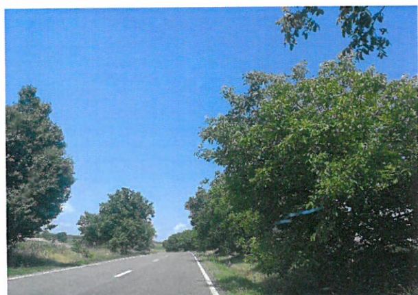
Foto 17: Drumul National DN 24C, km 51+000 – 52+000; 2 benzi de circulatie; imbracaminte asfaltica in stare foarte buna.
