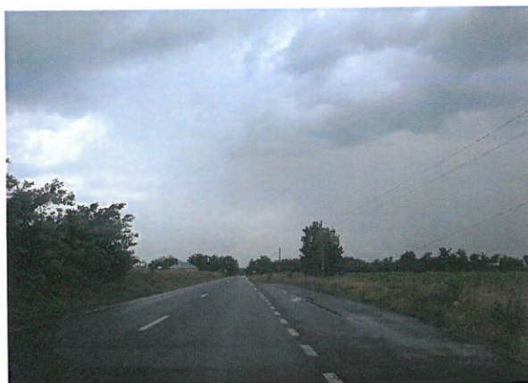
Foto 58: Drumul National DN 24C, km 71+000 – 72+000; 2 benzi de circulatie; imbracaminte asfaltica in stare foarte buna.
