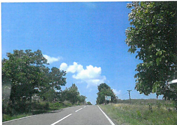
Foto 18: Drumul National DN 24C, km 51+000 – 52+000; 2 benzi de circulatie; imbracaminte asfaltica in stare foarte buna .
