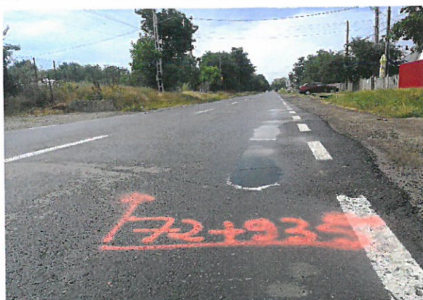
Foto 60: Drumul National DN 24C, km 72+000 – 73+000; 2 benzi de circulatie; imbracaminte asfaltica in stare buna.
