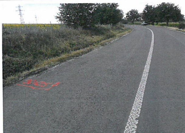
Foto 108: Drumul National DN 24C, km 96+000 – 97+000; 2 benzi de circulatie; imbracaminte asfaltica in stare buna.
