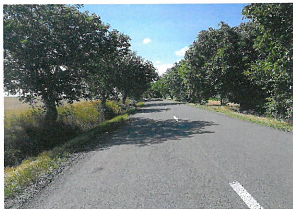
Foto 110: Drumul National DN 24C, km 97+000 – 98+000; 2 benzi de circulatie; imbracaminte asfaltica in stare buna.
