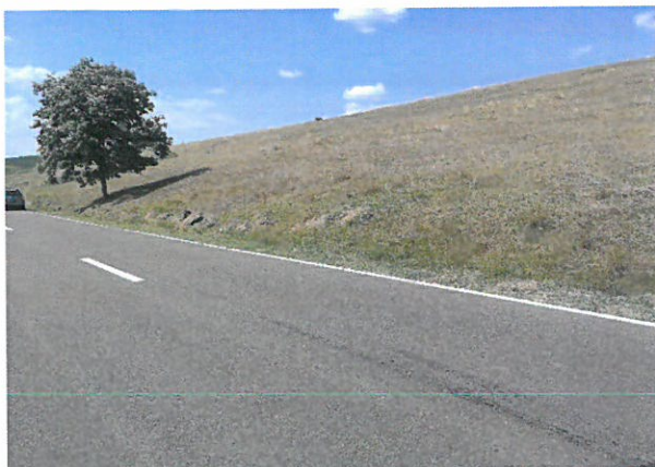
Foto 25: Drumul National DN 24C, km 55+000 – 56+000; 2 benzi de circulatie; imbracaminte asfaltica in stare foarte buna.
