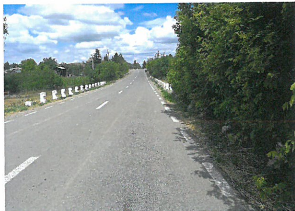
Foto 104: Drumul National DN 24C, km 94+000 – 95+000; 2 benzi de circulatie; imbracaminte asfaltica in stare buna.
