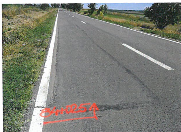
Foto 83: Drumul National DN 24C, km 84+000 – 85+000; 2 benzi de circulatie; imbracaminte asfaltica in stare buna.
