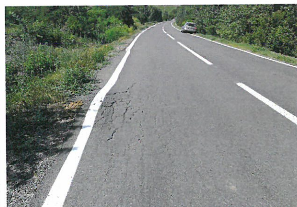
Foto 96: Drumul National DN 24C, km 90+000 – 91+000; 2 benzi de circulatie; imbracaminte asfaltica in stare buna.
