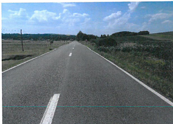
Foto 26: Drumul National DN 24C, km 55+000 – 56+000; 2 benzi de circulatie; imbracaminte asfaltica in stare foarte buna.
