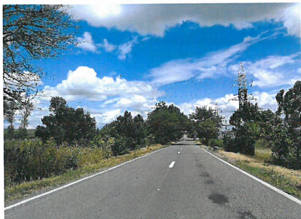
Foto 103: Drumul National DN 24C, km 94+000 – 95+000; 2 benzi de circulatie; imbracaminte asfaltica in stare buna.
