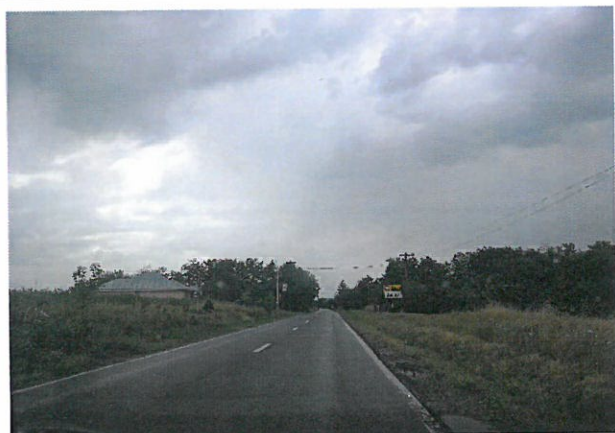
Foto 59: Drumul National DN 24C, km 72+000 – 73+000; 2 benzi de circulatie; imbracaminte asfaltica in stare buna.
