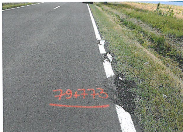
Foto 74: Drumul National DN 24C, km 79+000 – 80+000; 2 benzi de circulatie; imbracaminte asfaltica in stare foarte buna .
