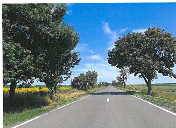
Foto 82: Drumul National DN 24C, km 83+000 – 84+000; 2 benzi de circulatie; imbracaminte asfaltica in stare buna.
