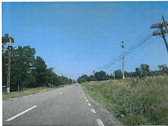
Foto 12: Drumul National DN 24C, km 48+000 – 49+000; 2 benzi de circulatie; imbracaminte asfaltica in stare mediocra.
