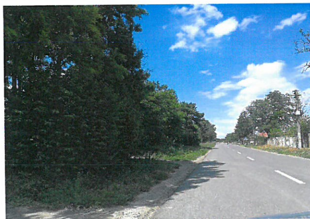
Foto 107: Drumul National DN 24C, km 96+000 – 97+000; 2 benzi de circulatie; imbracaminte asfaltica in stare buna.
