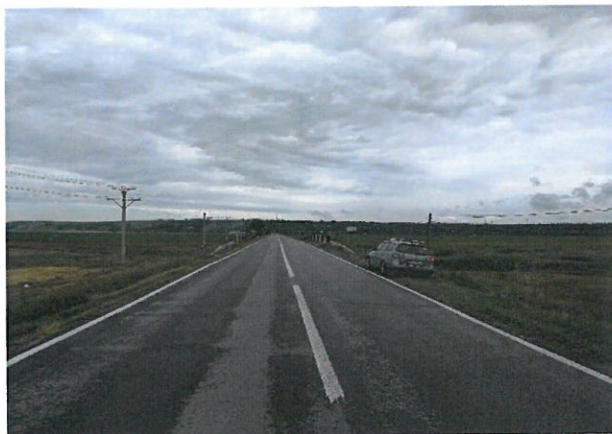
Foto 67: Drumul National DN 24C, km 76+000 – 77+000; 2 benzi de circulatie; imbracaminte asfaltica in stare buna.
