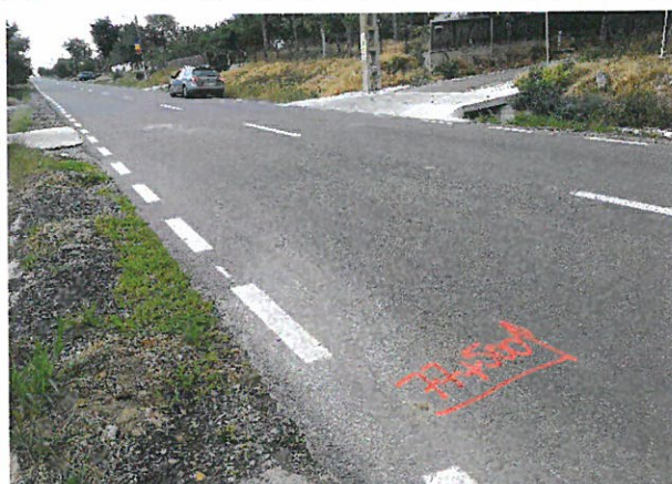
Foto 70: Drumul National DN 24C, km 77+000 – 78+000; 2 benzi de circulatie; imbracaminte asfaltica in stare foarte buna.
