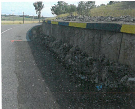
Suprafata degradata – carbonatata, exfoliata
