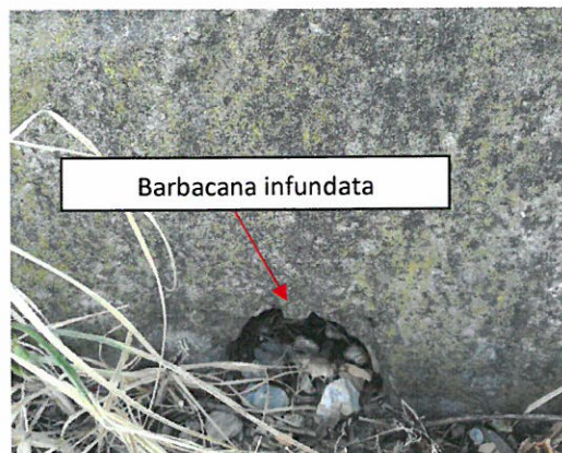
Camera de cadere podet de la baza zidului – degradata; podet colmatat
