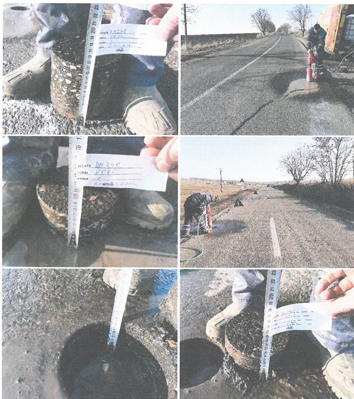
Fig. 15. Execuție și prelevare carote în mixtura asfaltică
