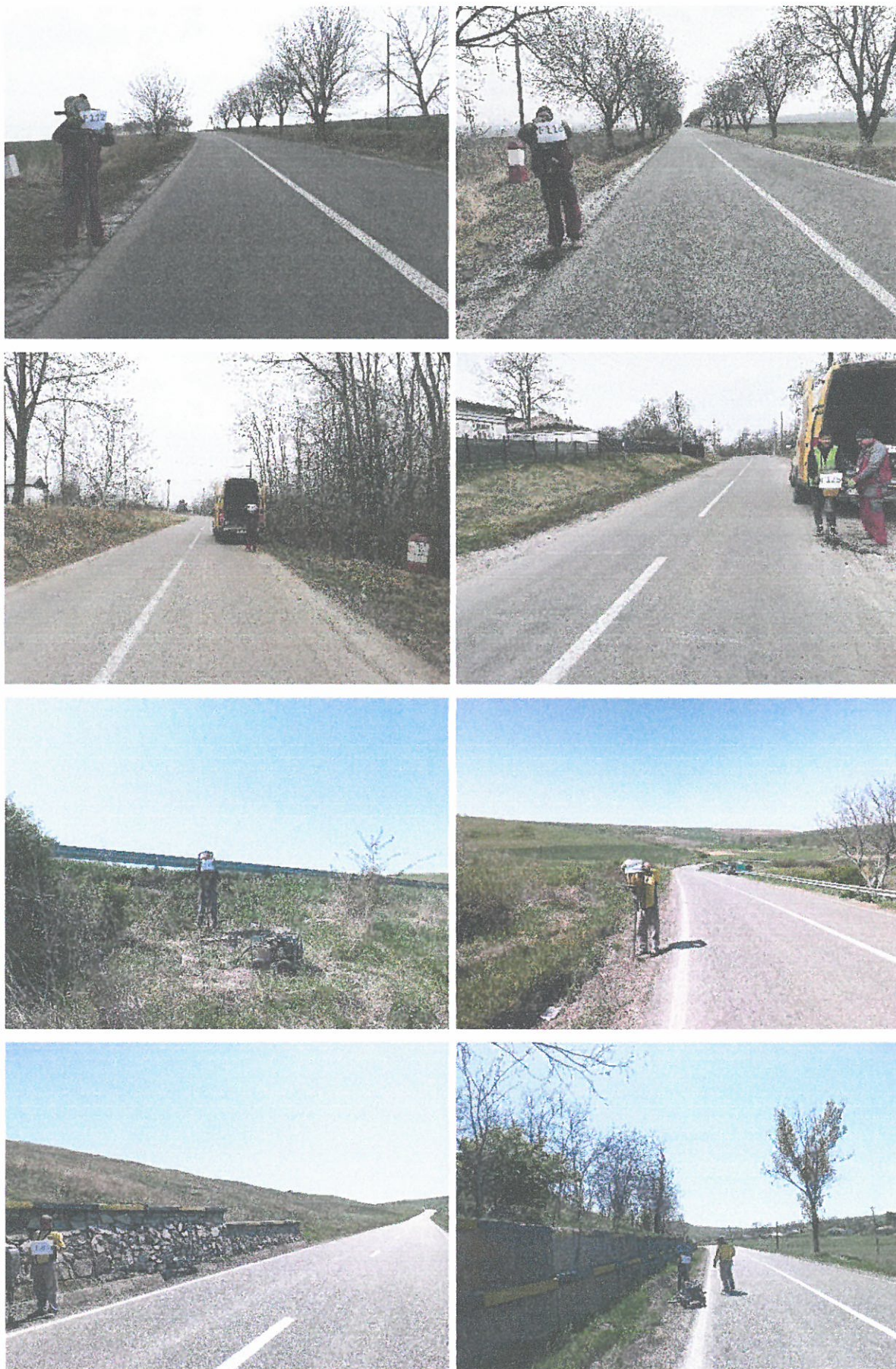
Fig. 16. Foraje geotehnice și prelevare probe de pământ
