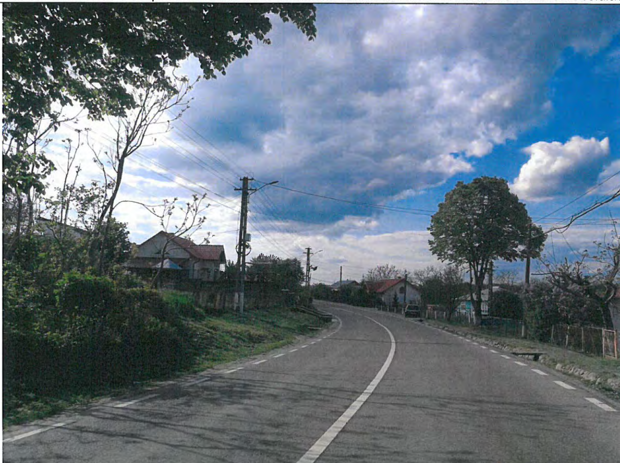
Foto 82: Drumul National DN 29, km 64+000 - 65+000 – Parte carosabila aflata intr-o stare tehnica corespunzatoare. Santuri inierbate si colmatate (stanga).
