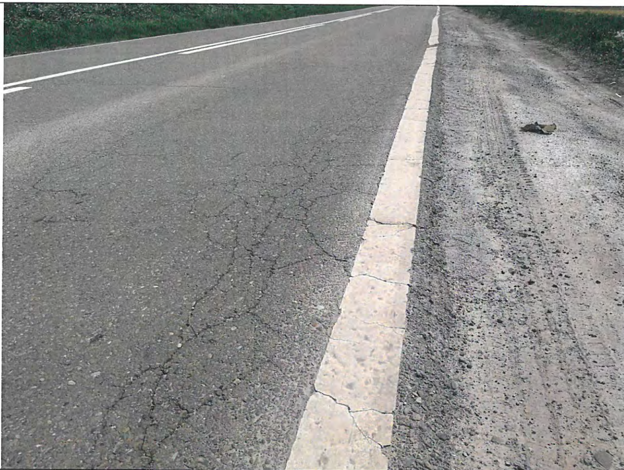
Foto 45: Drumul National DN 29, km 55+000 - 56+000 - Fagase longitudinale pe zonele marginale a drumului national.
