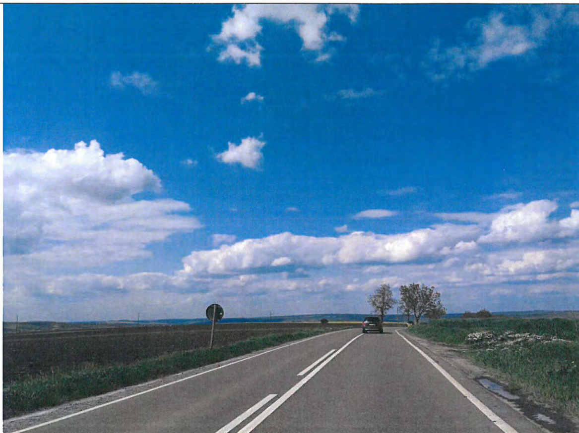
Foto 67: Drumul National DN 29, km 60+000 - 61+000 – Parte carosabila aflată într-o stare optimă de exploatare. Acostamente din pamant cu vegetatie și apa la nivelul acestora. Sisteme de colectare și evacuare a apelor pluviale inierbate.
