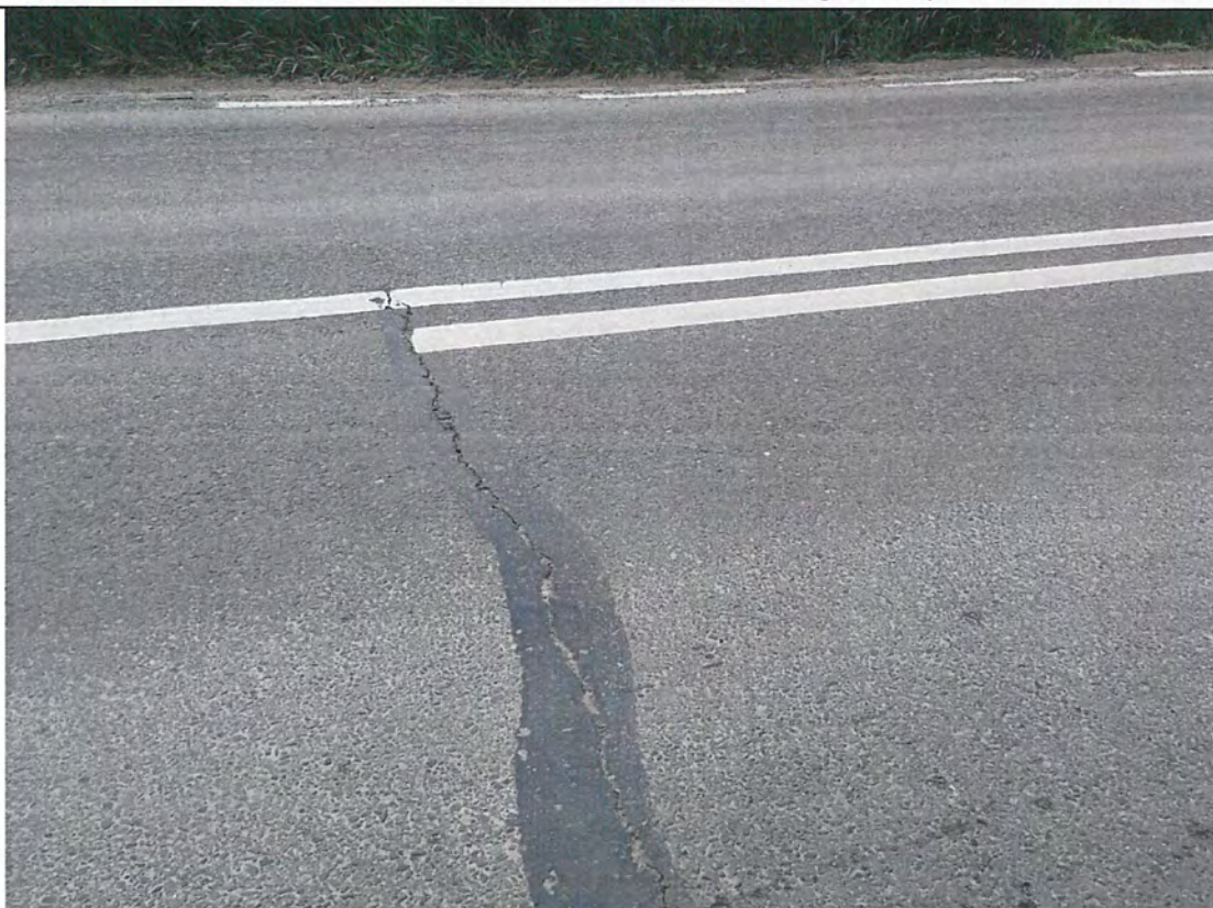
Foto 2: Drumul National DN 29, km 44+100 -45+000 – Fisura transversala colmatata cu mastic bituminos.
