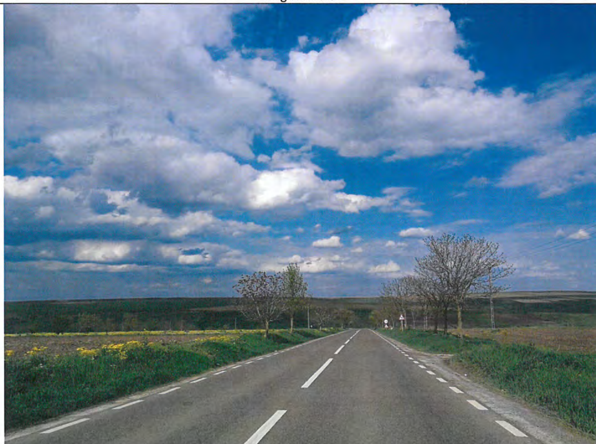
Foto 36: Drumul National DN 29, km 52+000 - 53+000 - Calea de rulare aflata intr-o stare tehnica corespunzatoare.
