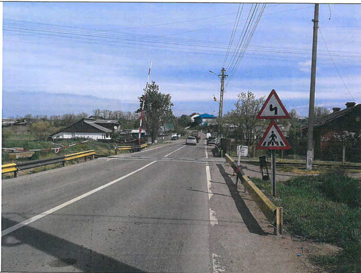
Foto 85: Drumul National DN 29, km 65+000 - 66+000 – Trecere la nivel cu calea ferata.
