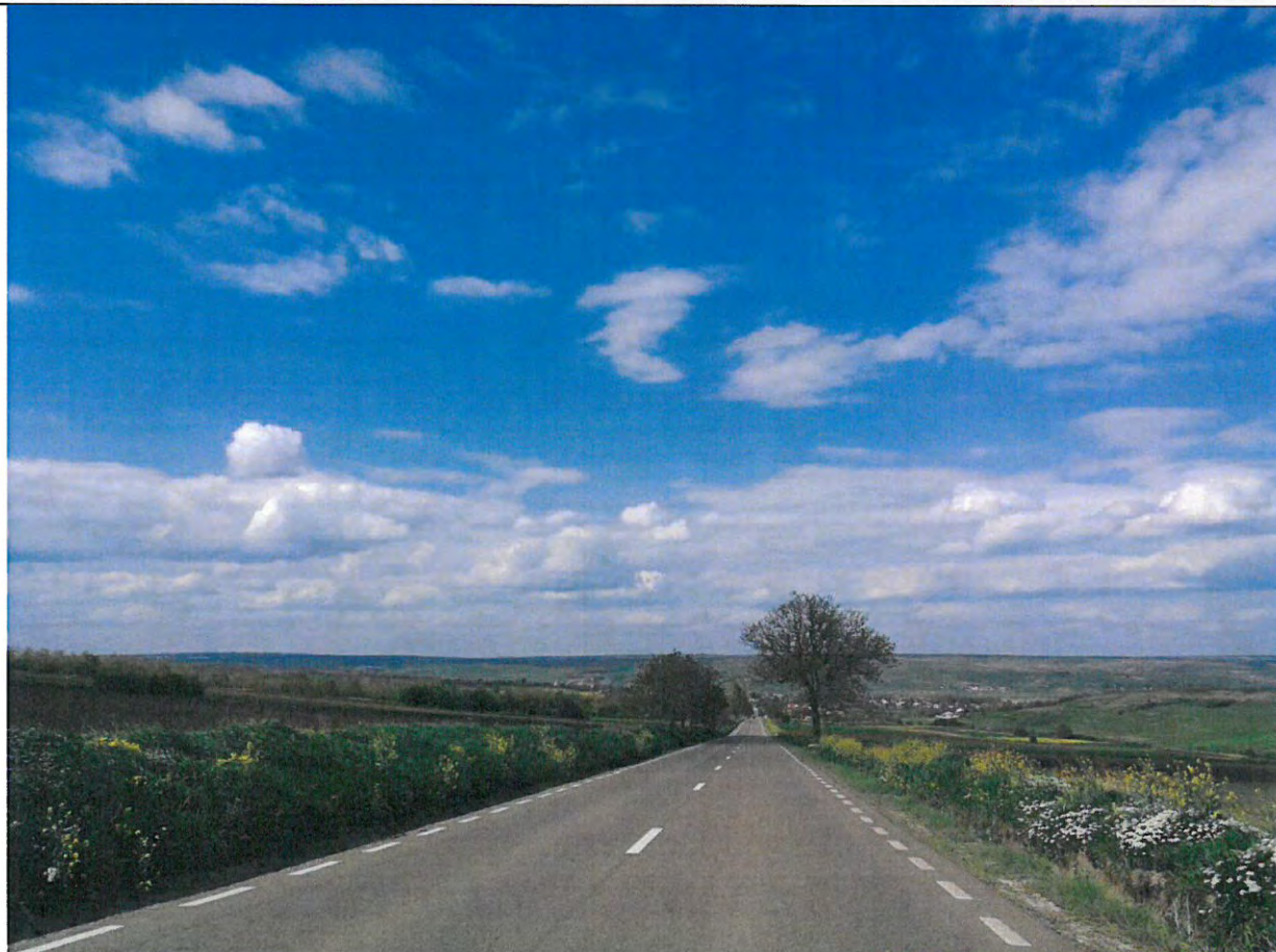
Foto 70: Drumul National DN 29, km 61+000 - 62+000 – Parte carosabila aflata intr-o stare optima de exploatare.
