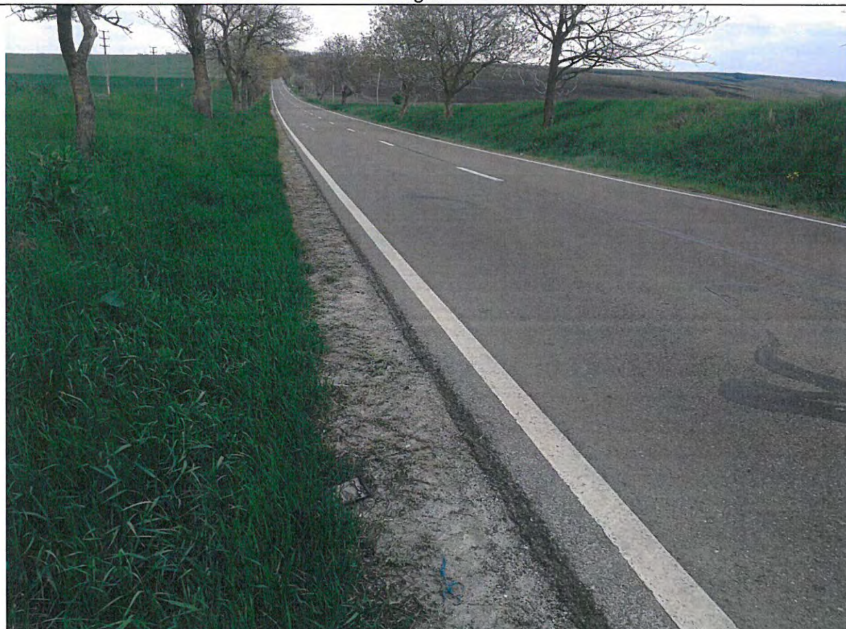
Foto 104: Drumul National DN 29, km 69+000 - 70+000 – Tronson caracterizat de usoare forme de valuriri si fagase. Santuri inierbate si colmatate.
