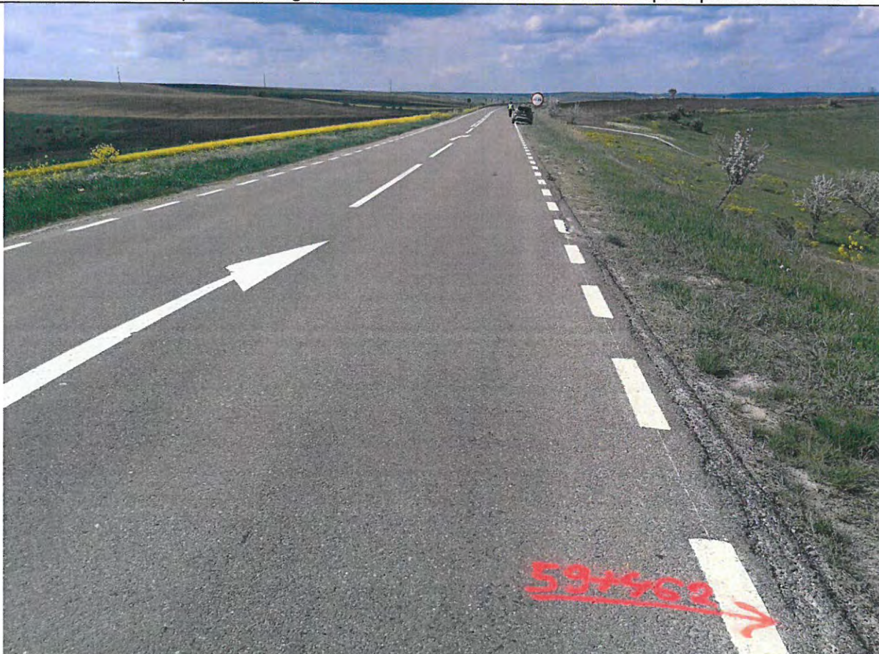
Foto 62: Drumul National DN 29, km 59+000 - 60+000 – Parte carosabila aflata intr-o stare optima de exploatare. Stabilitatea taluzului de rambleu dreapta este asigurata prin intermediul unor ziduri de sprijin din beton.
