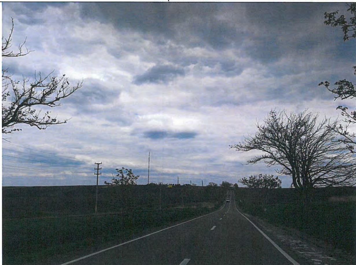
Foto 104: Drumul National DN 29, km 70+000 - 71+000 – Suprafata de rulare aflata intr-o stare optima de exploatare.
