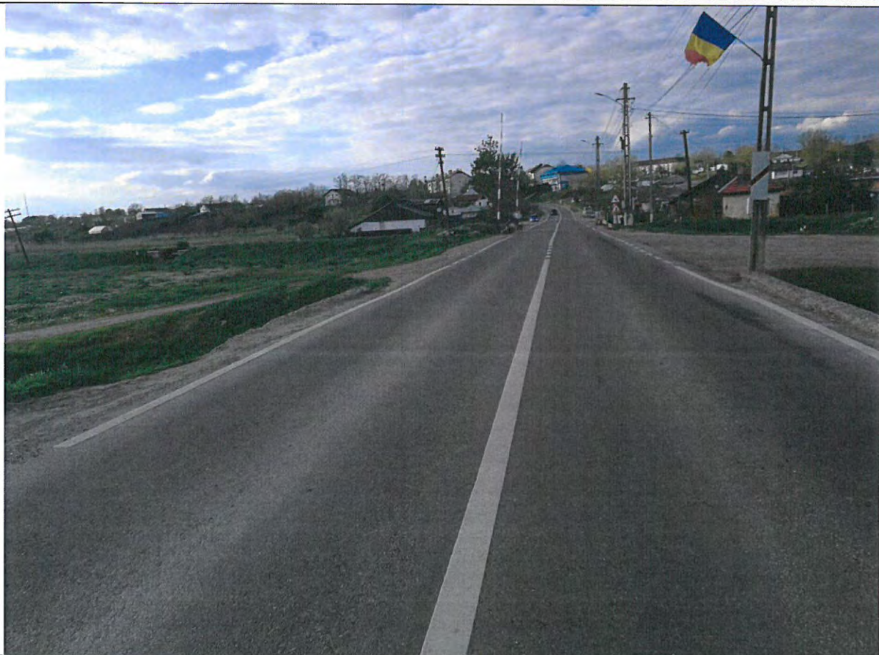
Foto 84: Drumul National DN 29, km 64+000 - 65+000 – Fagase longitudinale, usoare forme de denivelare. Lipsa parapetelor la nivelul timpanelor podetului.
