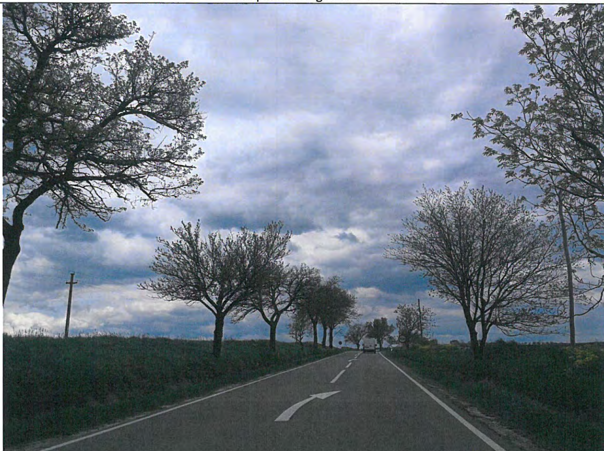
Foto 94: Drumul National DN 29, km 67+000 - 68+000 – Partea carosabila intr-o stare tehnica buna. Acostamente din pamant vegetalizate.
