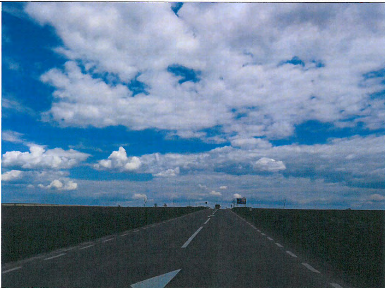
Foto 52: Drumul National DN 29, km 56+000 - 57+000 – Parte carosabila aflata intr-o stare optima de exploatare.
