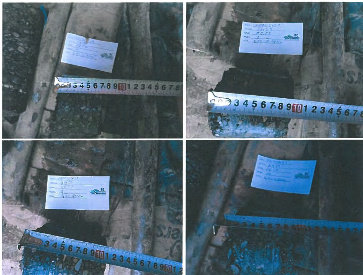
Fig. 17. Execuție carote în mixtura asfaltică
