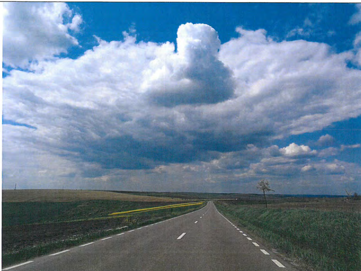
Foto 61: Drumul National DN 29, km 59+000 - 60+000 – Parte carosabila aflata intr-o stare optima de exploatare. Acostamente din pamant cu vegetatie. Sisteme de colectare si evacuare a apelor pluviale inierbate.
