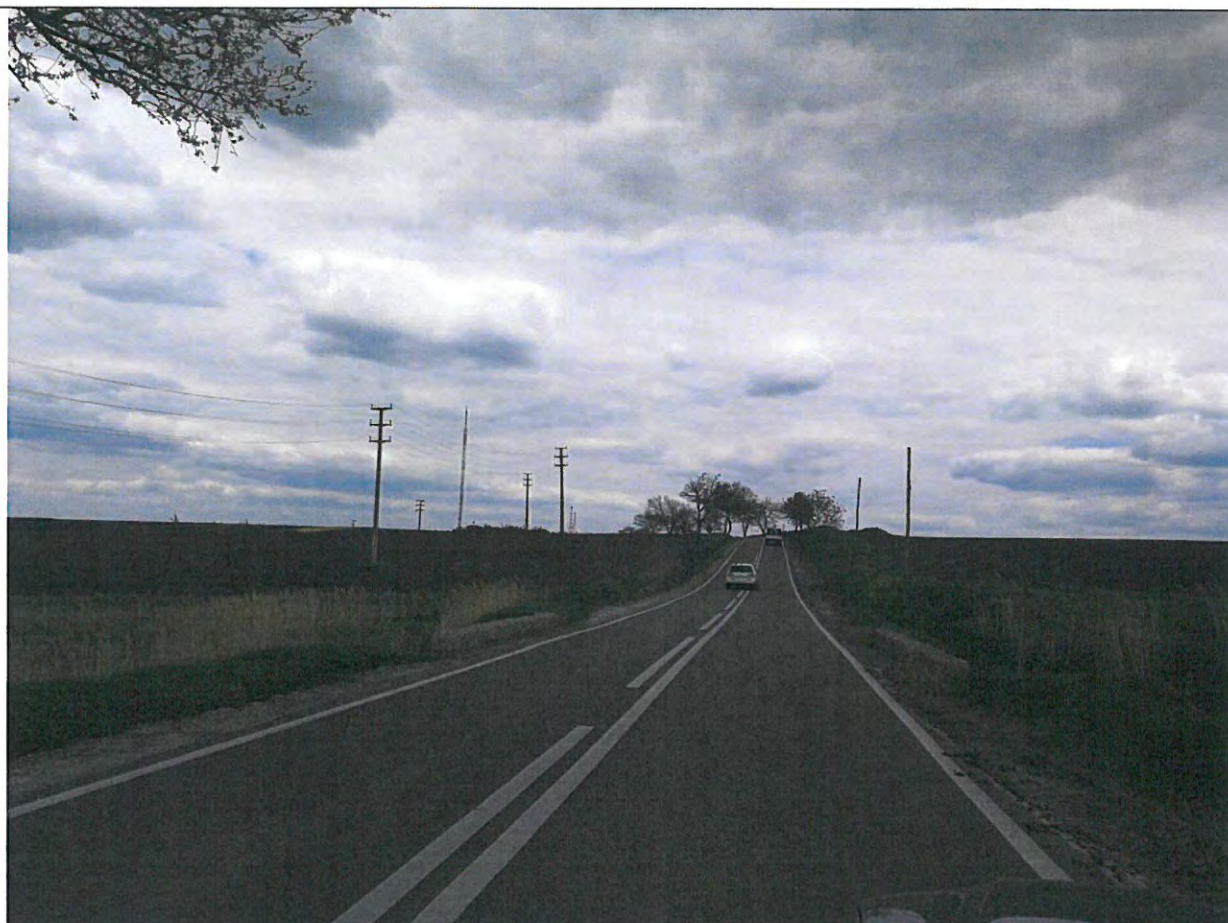
Foto 105: Drumul National DN 29, km 71+000 - 72+000 – Suprafata de rulare aflata intr-o stare optima de exploatare.
