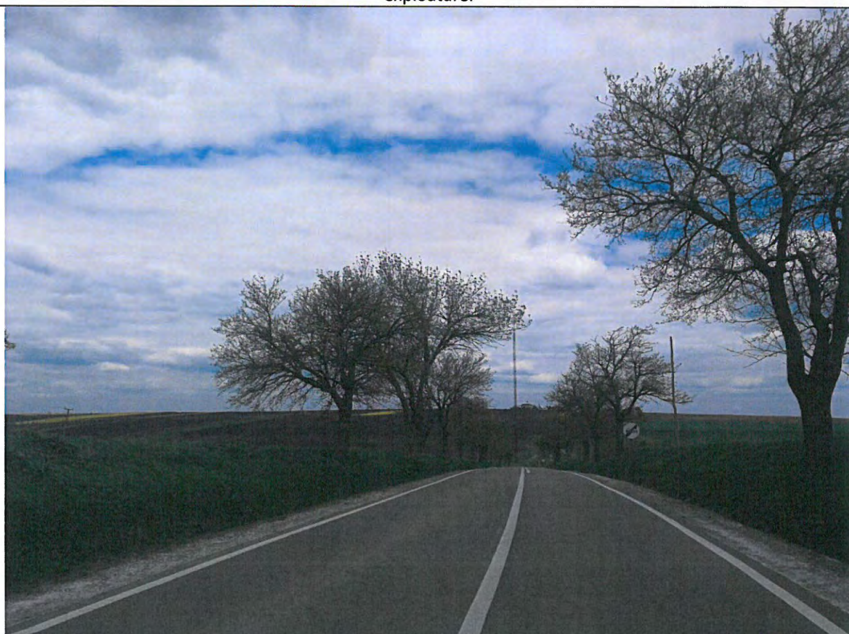
Foto 106: Drumul National DN 29, km 71+000 - 72+000 – Suprafata de rulare aflata intr-o stare optima de exploatare. Usoare forme de valurire.
