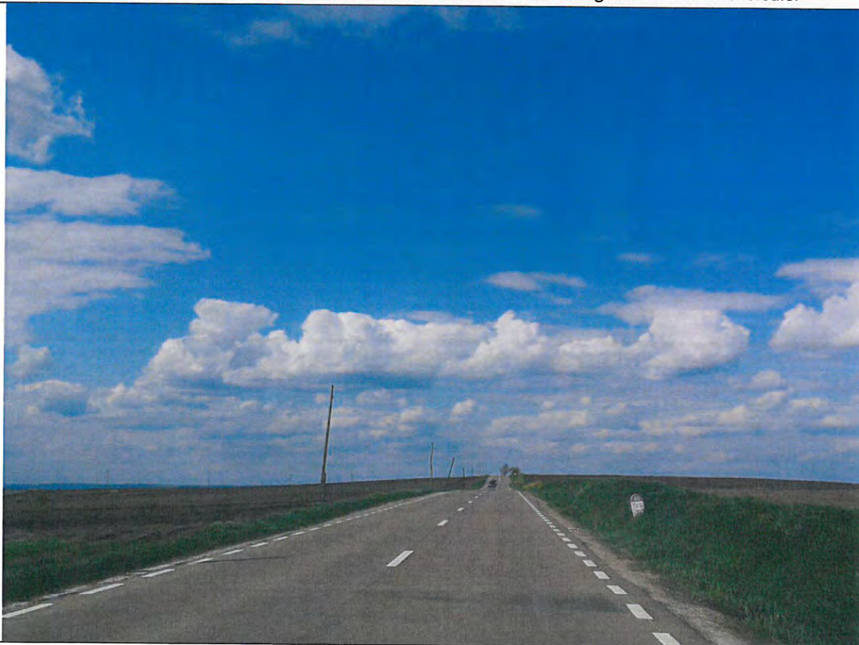
Foto 64: Drumul National DN 29, km 59+000 - 60+000 – Parte carosabila aflata intr-o stare optima de exploatare. Acostamente din pamant cu vegetatie. Sisteme de colectare si evacuare a apelor pluviale inierbate.
