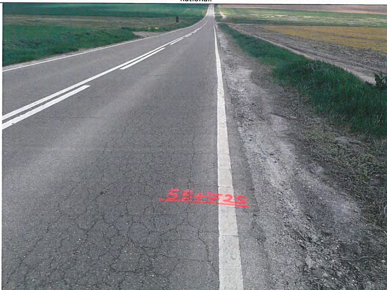
Foto 46: Drumul National DN 29, km 55+000 - 56+000 - Fagase longitudinale pe zonele marginale a drumului national.
