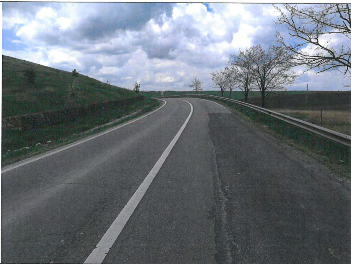
Foto 25: Drumul National DN 29, km 50+000 - 51+000— Plombări marginale pe suprafețe extinse.
