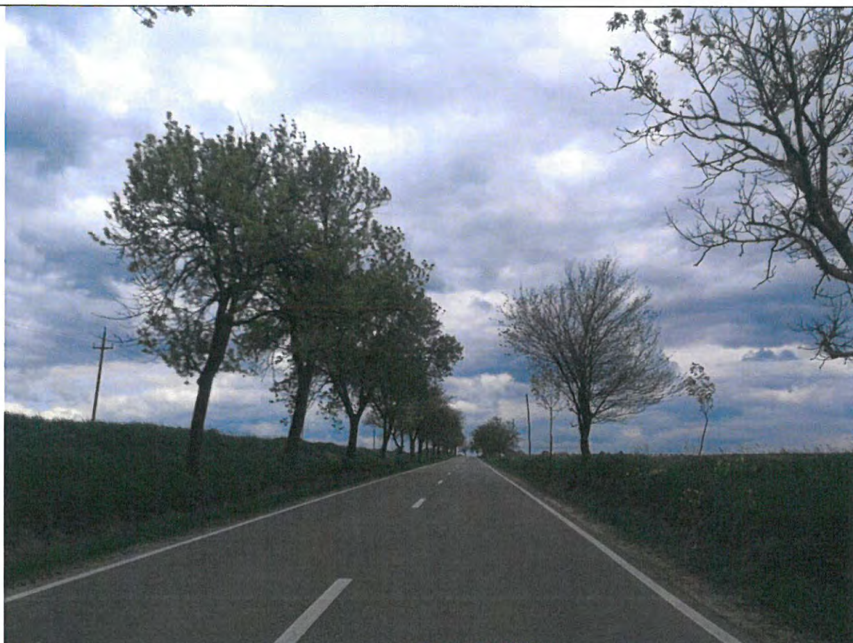
Foto 93: Drumul National DN 29, km 67+000 - 68+000 – Partea carosabila intr-o stare tehnica buna. Acostamente din pamant vegetalizate.
