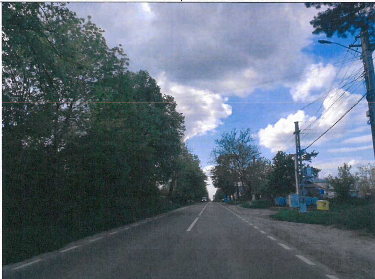
Foto 78: Drumul National DN 29, km 63+000 - 64+000 – Parte carosabila aflata intr-o stare tehnica corespunzatoare. Santuri inierbate si colmatate (stanga).
