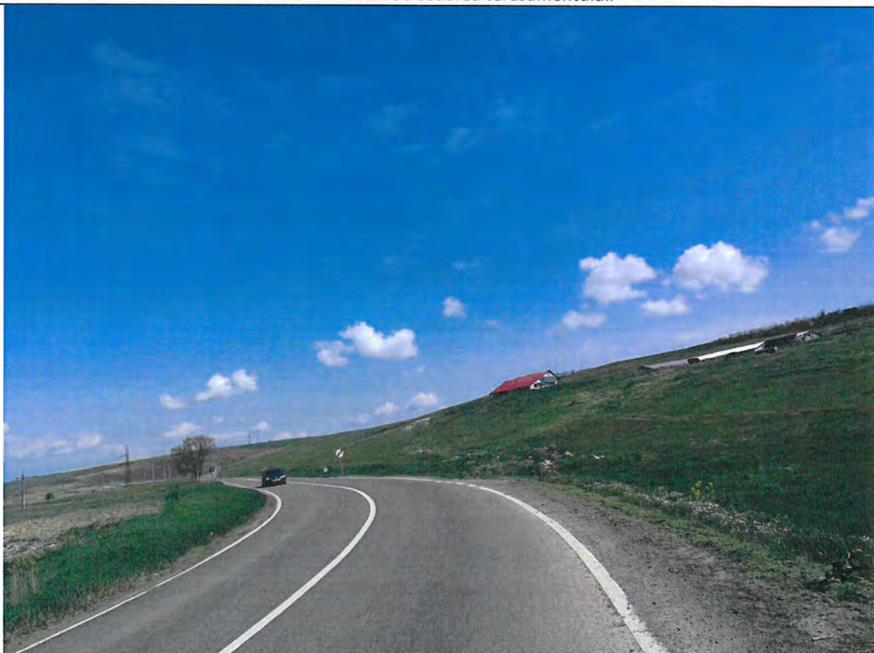
Foto 20: Drumul National DN 29, km 48+000 - 49+000– Cale de rulare aflata intr-o stare tehnica corespunzatoare.
