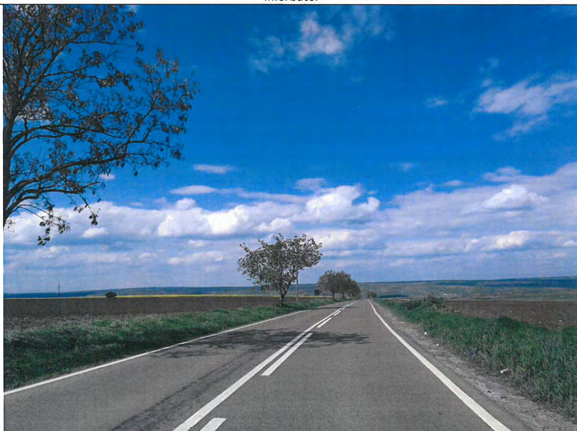
Foto 68: Drumul National DN 29, km 60+000 - 61+000 – Parte carosabila aflată într-o stare optimă de exploatare. Acostamente din pamant. Sisteme de colectare și evacuare a apelor pluviale inierbate.
