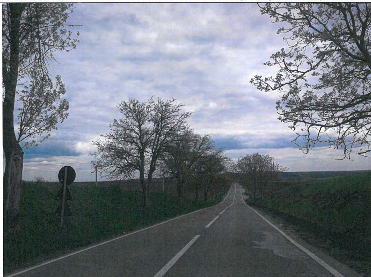
Foto 102: Drumul National DN 29, km 69+000 - 70+000 – Tronson caracterizat de usoare forme de valuriri si fagase.
