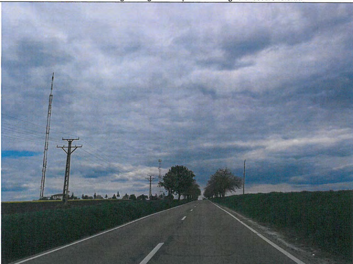
Foto 110: Drumul National DN 29, km 72+000 - 73+000 – Multiple fisuri la nivelul partii carosabile colmatate cu mastic bituminos. Fagase longitudinale pe zonele marginale. Usoare valuriri.
