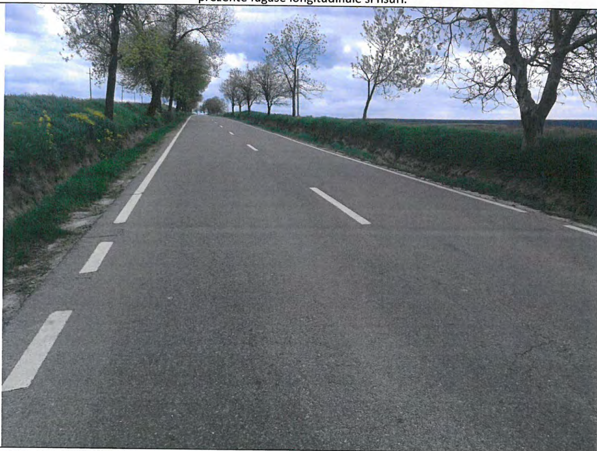
Foto 92: Drumul National DN 29, km 66+000 - 67+000 – Partea carosabila intr-o stare tehnica buna. Acostamente din pamant vegetalizate.
