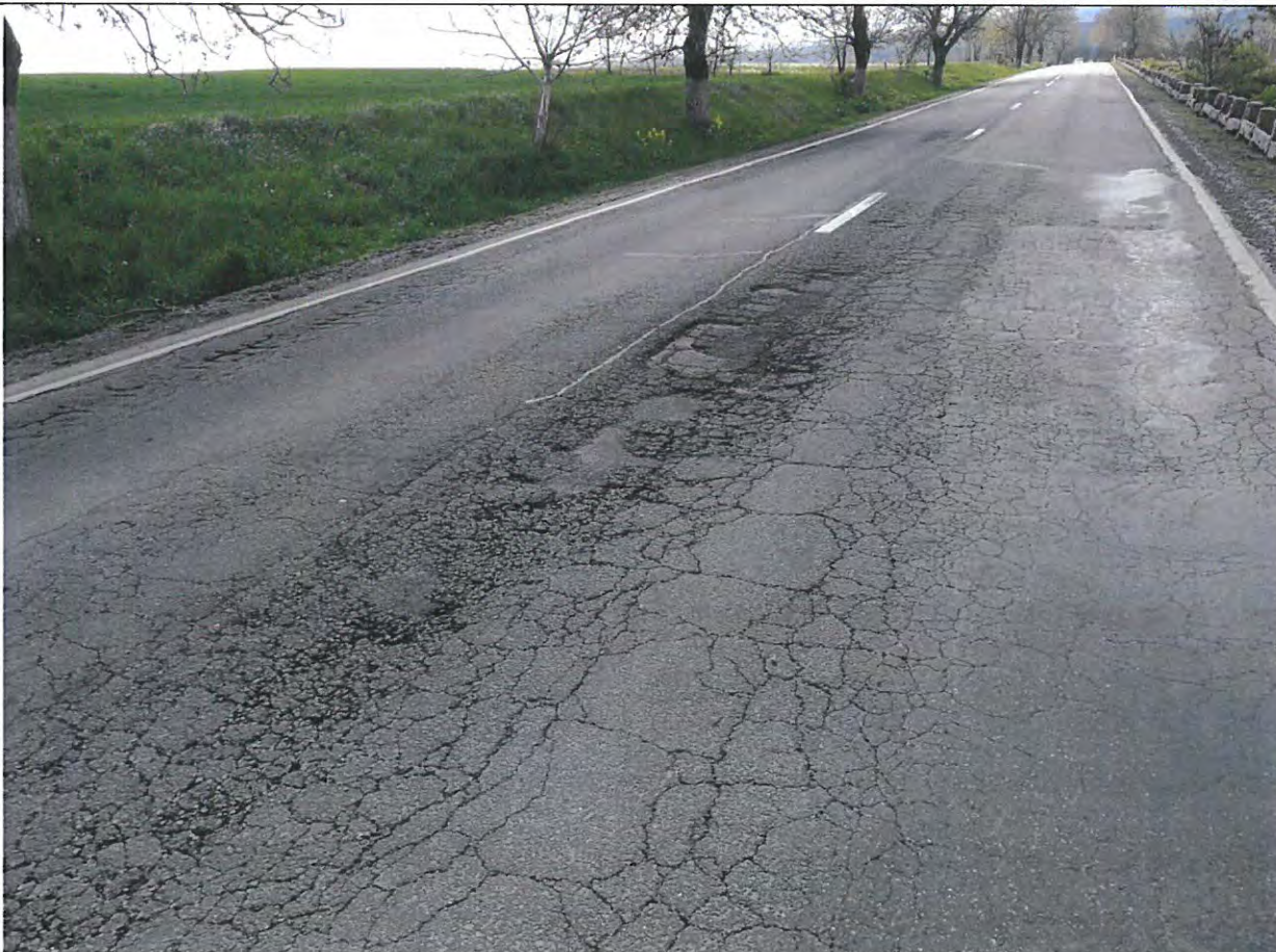
Foto 44: Drumul National DN 29B, km 16+000 -17+000 – Gropi pe zona mediana a drumului national, faiantari pe zone extinse.
