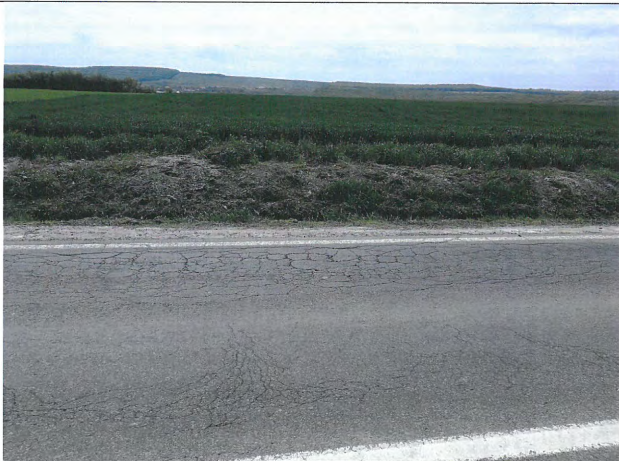
Foto 6: Drumul National DN 29B, km 7+000 -8+000 – Faiantari pe zone extinse. Fagase longitudinale pe zonele marginale.
