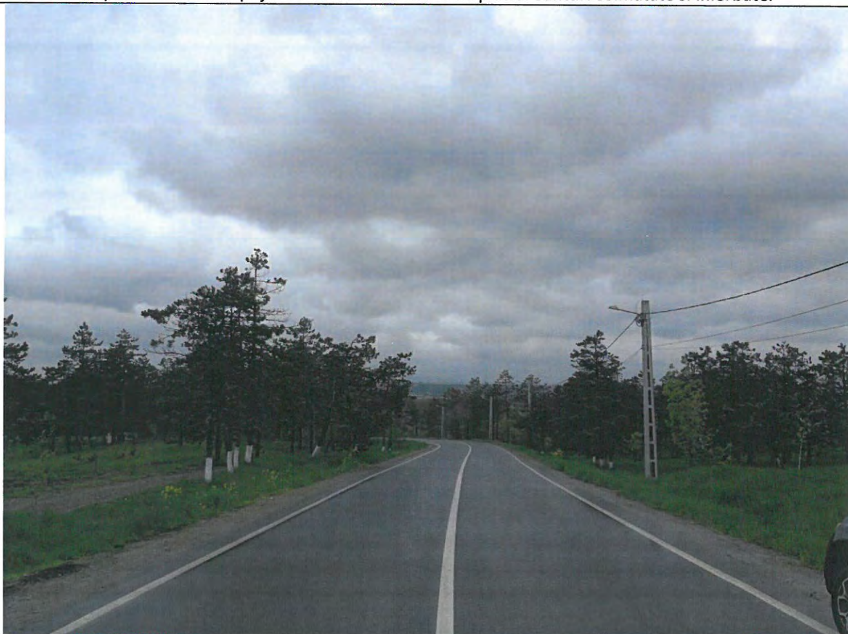
Foto 102: Drumul National DN 29B, km 31+000 -31+500 – Suprafata de rulare aflata intr-o stare optima de exploatare.
