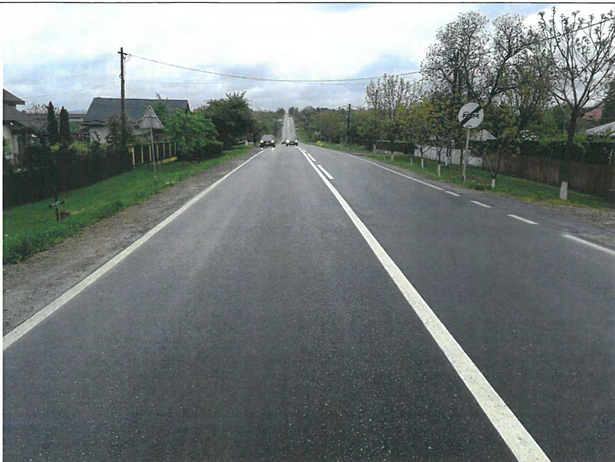
Foto 97: Drumul National DN 29B, km 30+000 -31+000 – Suprafata de rulare aflata intr-o stare optima de exploatare.
