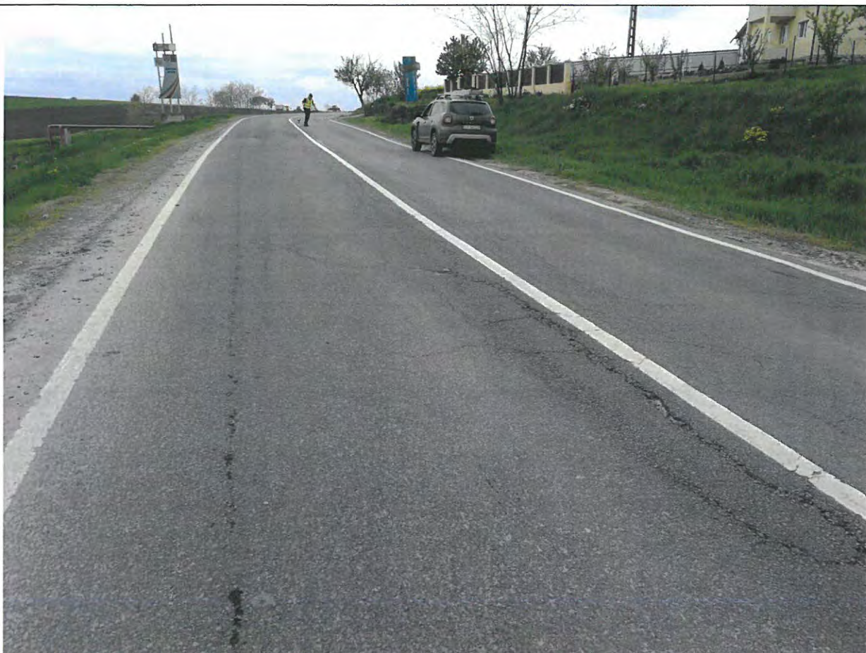
Foto 27: Drumul National DN 29B, km 12+000 -13+000 – Crapaturi longitudinale in zona axului drumului national.
