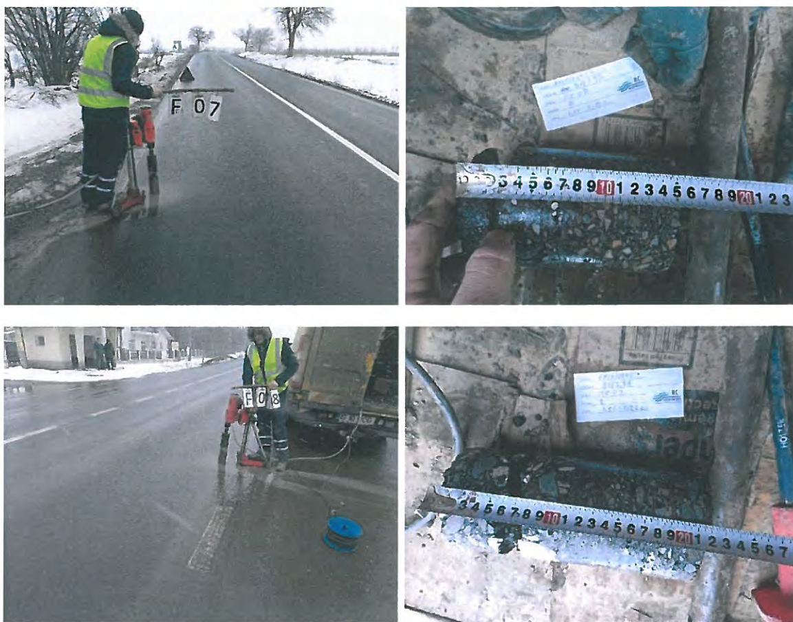
Fig. 17. Execuție carote în mixtura asfaltică
