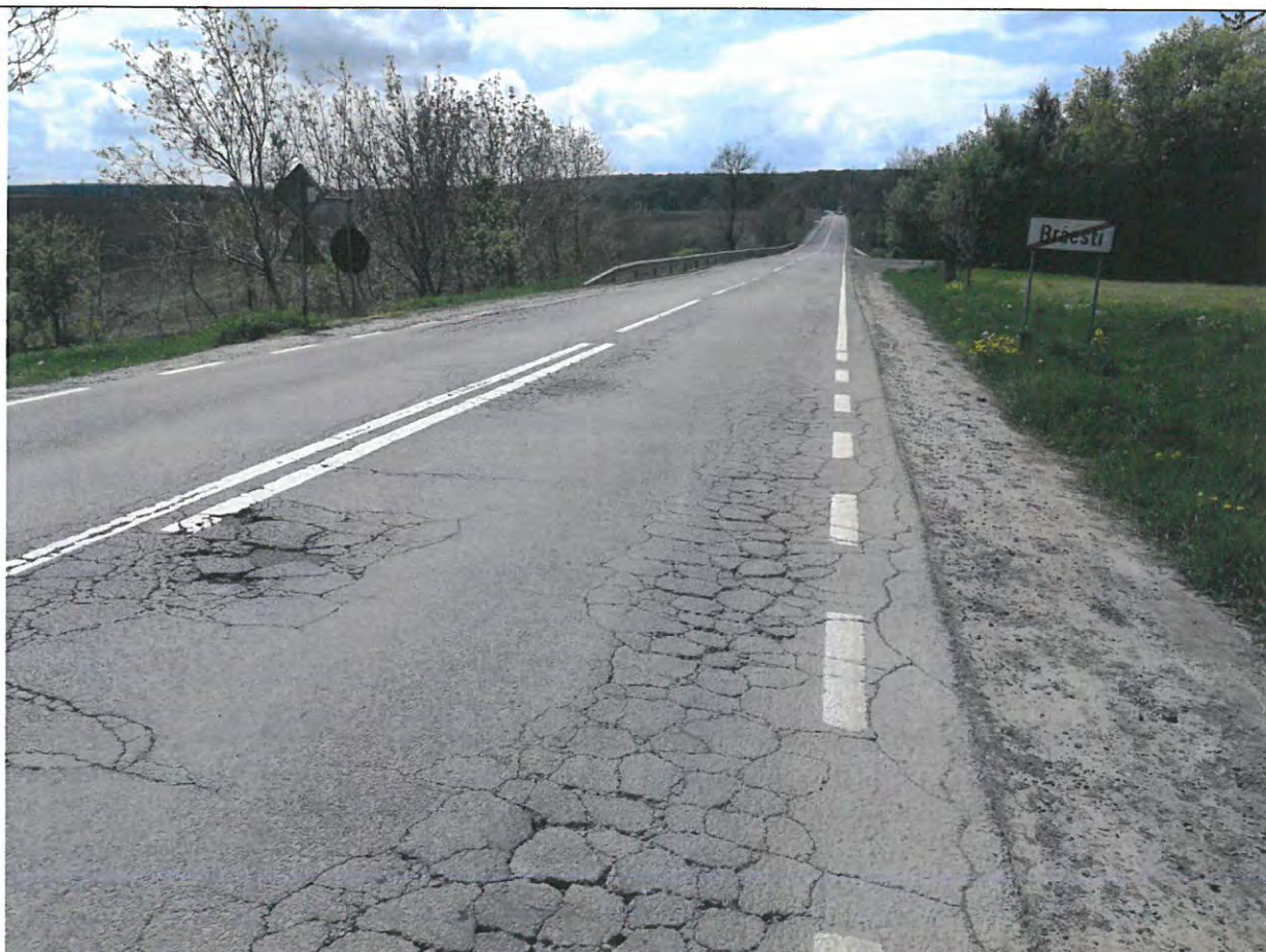
Foto 59: Drumul National DN 29B, km 20+000 -21+000 – Faianțări pronunțate pe întreaga suprafață a părții carosabile cu posibilitate de apariție a gropilor. Fagase longitudinale pe zonele marginale.
