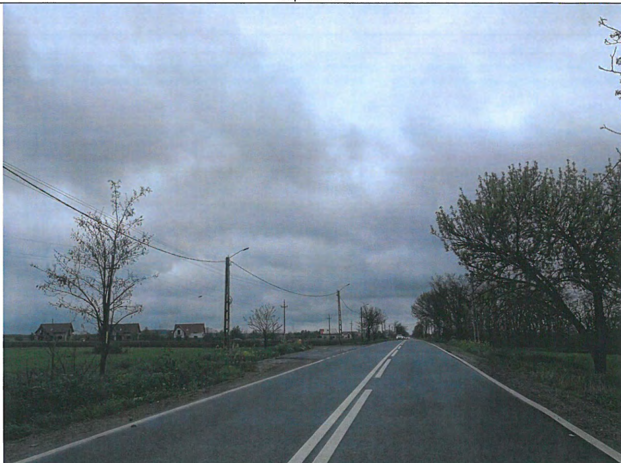
Foto 90: Drumul National DN 29B, km 28+000 -29+000 – Suprafata de rulare aflata intr-o stare optima de exploatare.
