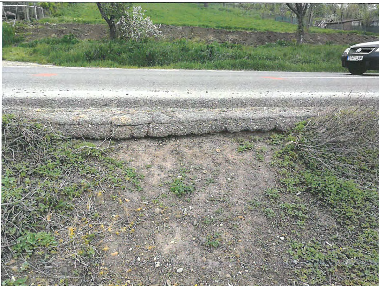
Foto 25: Drumul National DN 29B, km 12+000 -13+000 – Turnari succesive covoare asfaltice
