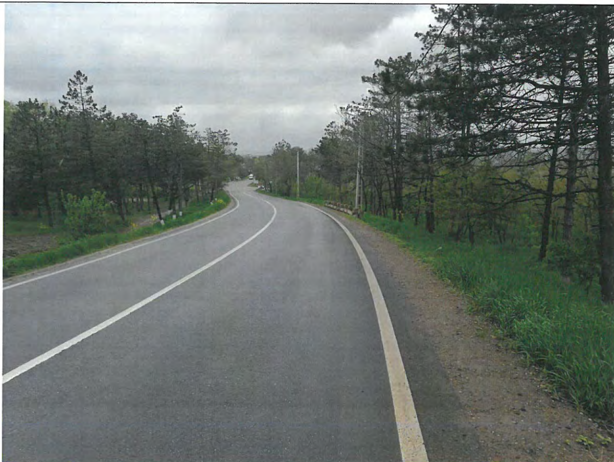
Foto 103: Drumul National DN 29B, km 31+000 -31+500 – Suprafata de rulare aflata intr-o stare optima de exploatare.
