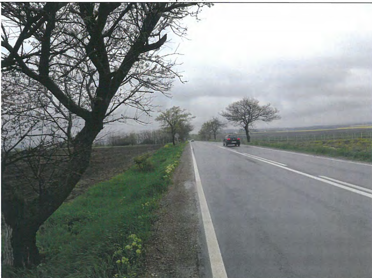
Foto 80: Drumul National DN 29B, km 25+000 -26+000 – Suprafata de rulare aflata intr-o stare optima de exploatare.
