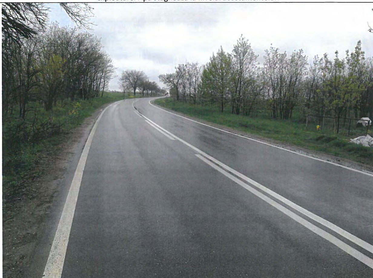
Foto 82: Drumul National DN 29B, km 26+000 -27+000 – Suprafata de rulare aflata intr-o stare optima de exploatare. Apa stagneaza la nivelul acostamentelor.
