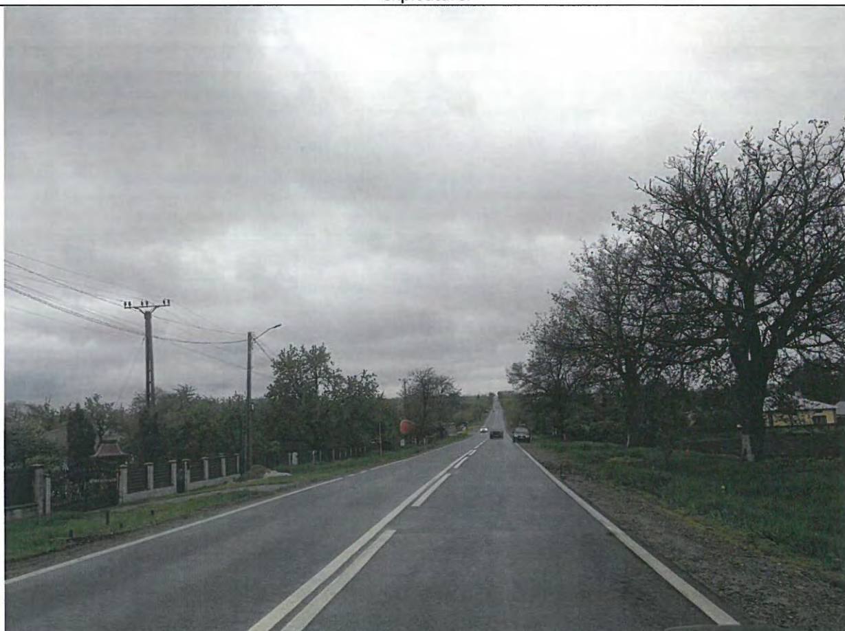
Foto 86: Drumul National DN 29B, km 27+000 -28+000 – Suprafata de rulare aflata intr-o stare optima de exploatare.
