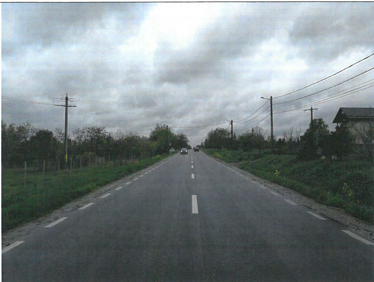
Foto 99: Drumul National DN 29B, km 30+000 -31+000 – Suprafata de rulare aflata intr-o stare optima de exploatare.
