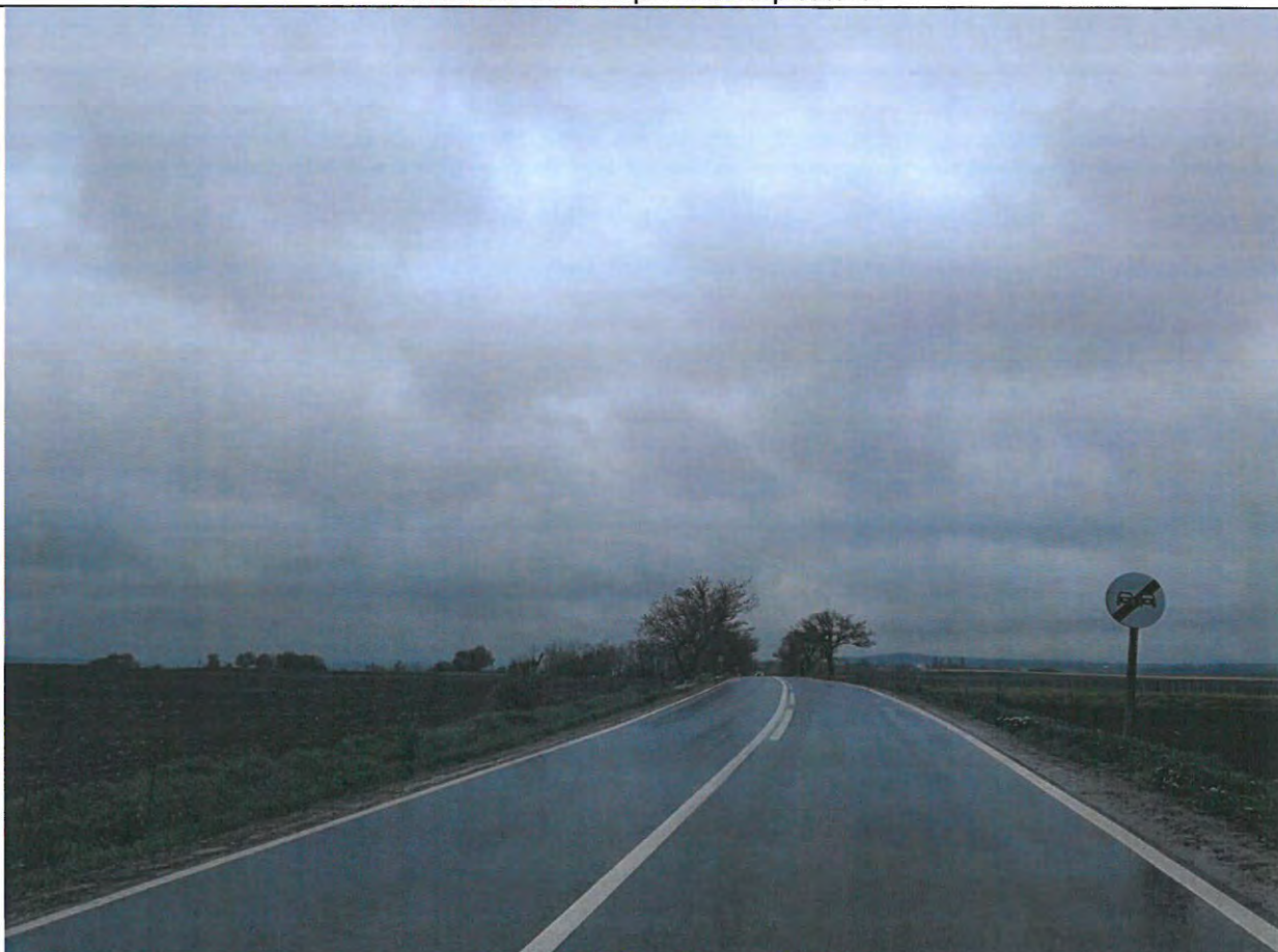
Foto 78: Drumul National DN 29B, km 25+000 -26+000 – Suprafata de rulare aflata intr-o stare optima de exploatare.
