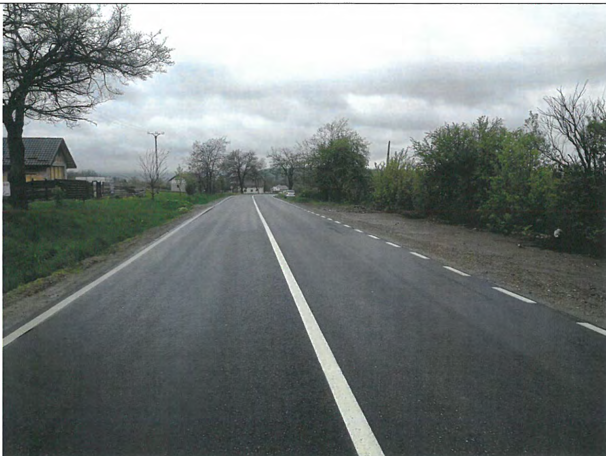
Foto 85: Drumul National DN 29B, km 27+000 -28+000 – Suprafata de rulare aflata intr-o stare optima de exploatare.
