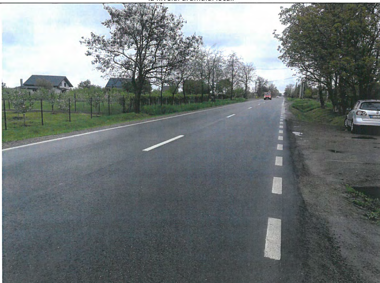
Foto 94: Drumul National DN 29B, km 29+000 -30+000 – Suprafata de rulare aflata intr-o stare optima de exploatare.
