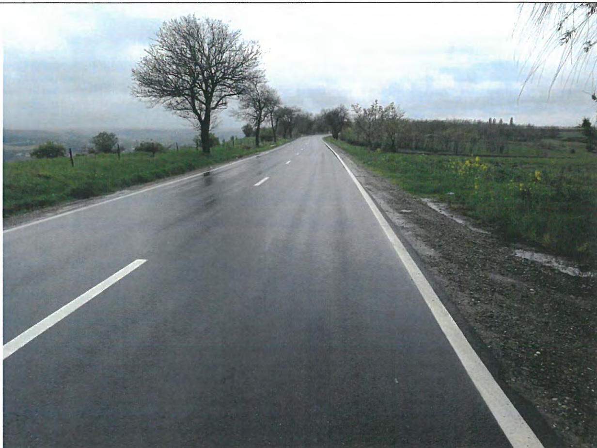
Foto 81: Drumul National DN 29B, km 26+000 -27+000 – Suprafata de rulare aflata intr-o stare optima de exploatare. Apa stagneaza la nivelul acostamentelor.
