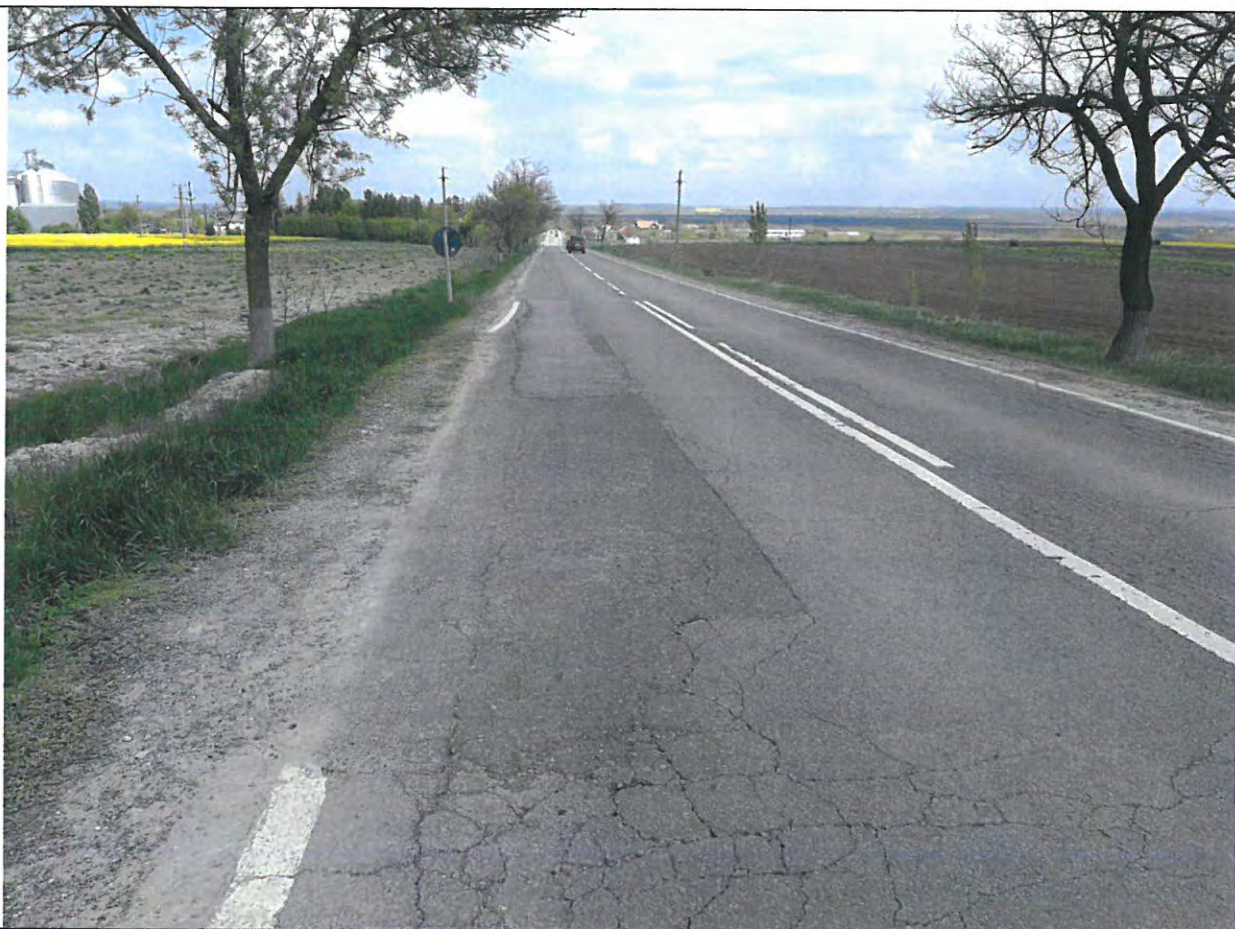
Foto 57: Drumul National DN 29B, km 20+000 -21+000 – Lucrari de intretinere prin plombare. Acostamente din pamant denivelate. Taluze inierbate.
