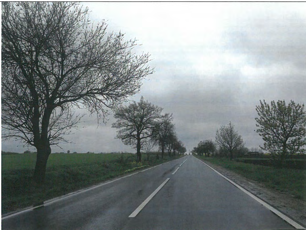
Foto 83: Drumul National DN 29B, km 26+000 -27+000 – Suprafata de rulare aflata intr-o stare optima de exploatare. Apa stagneaza la nivelul acostamentelor.
