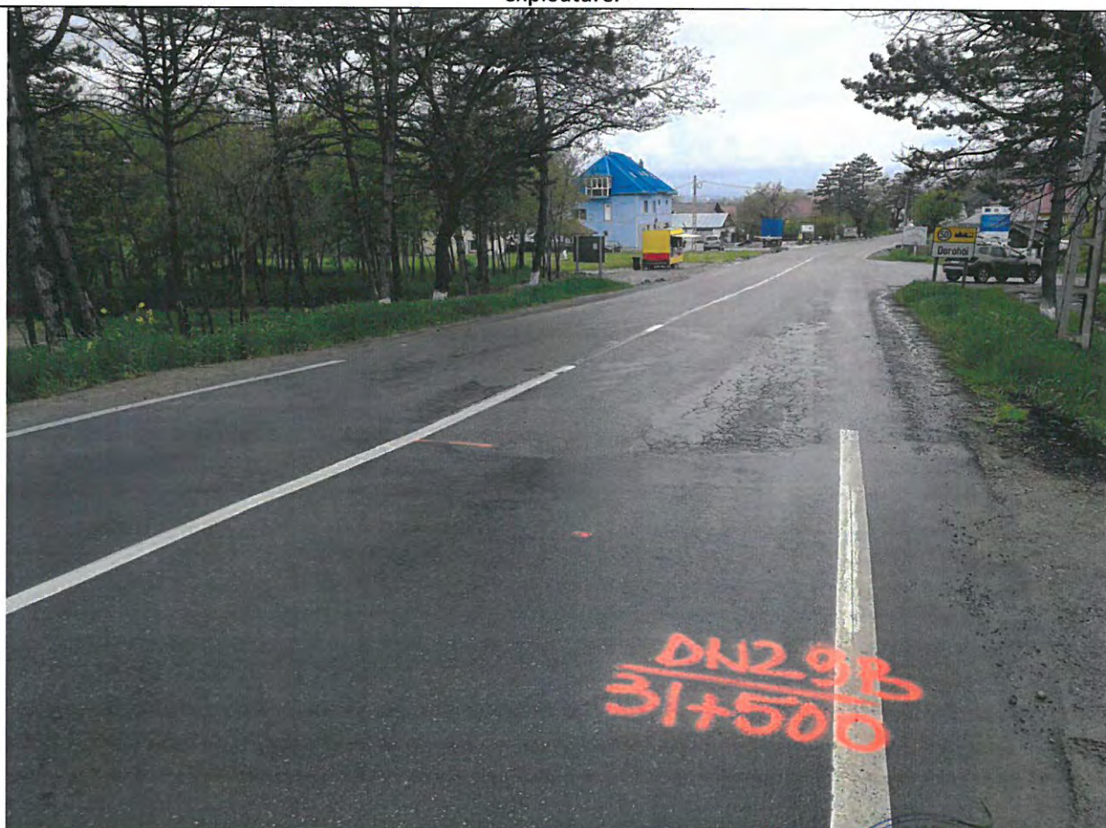
Foto 104: Drumul National DN 29B, km 31+000 -31+500 – Suprafata de rulare aflata intr-o stare optima de exploatare. Sfarsit proiect.
