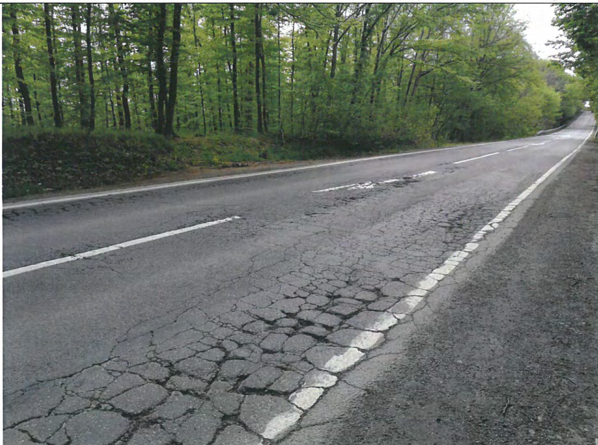
Foto 56: Drumul National DN 29B, km 19+000 -20+000 – Faiantari marginale pronuntate cu posibilitate de aparitie a gropilor.
