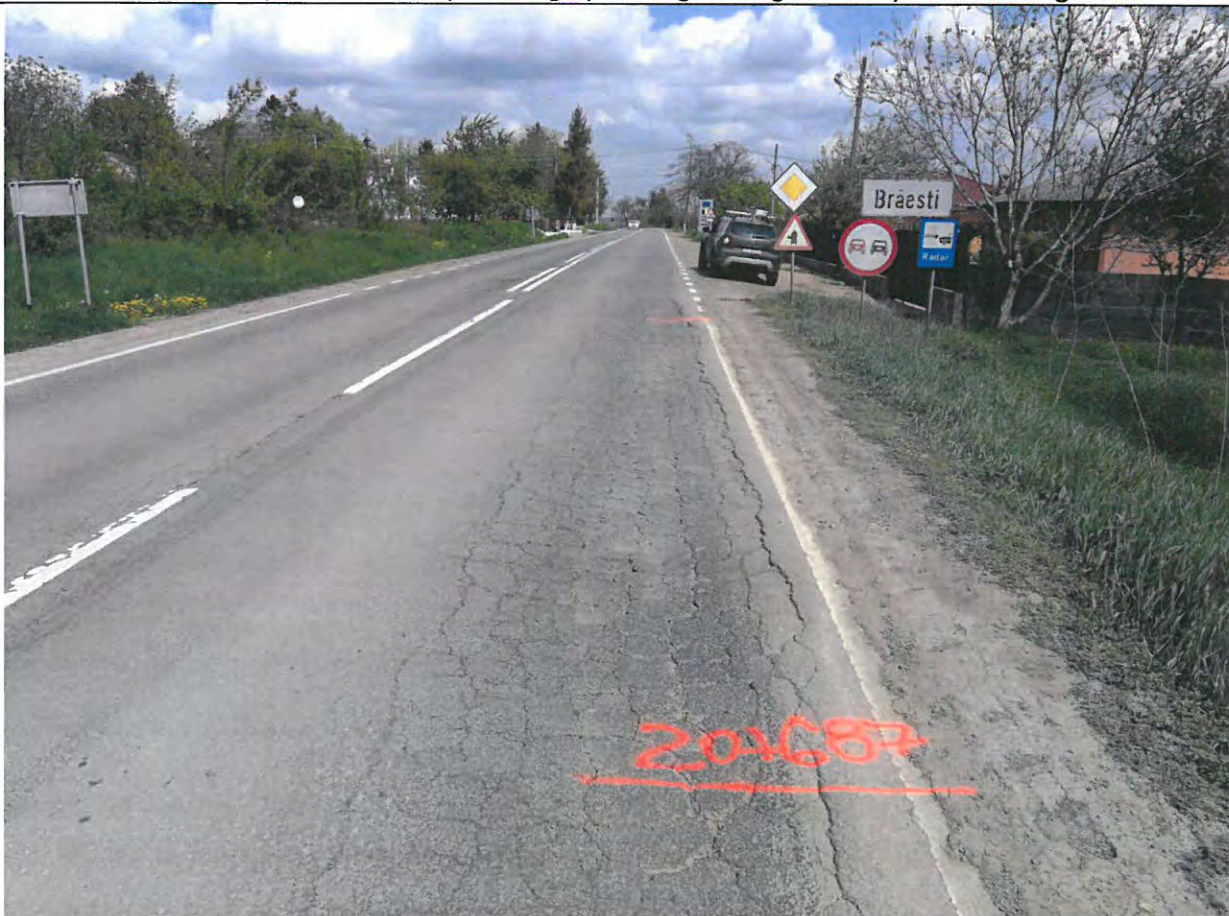
Foto 60: Drumul National DN 29B, km 20+000 -21+000 – Faianțări și fagase longitudinale. Intrare în localitatea Braiești.
