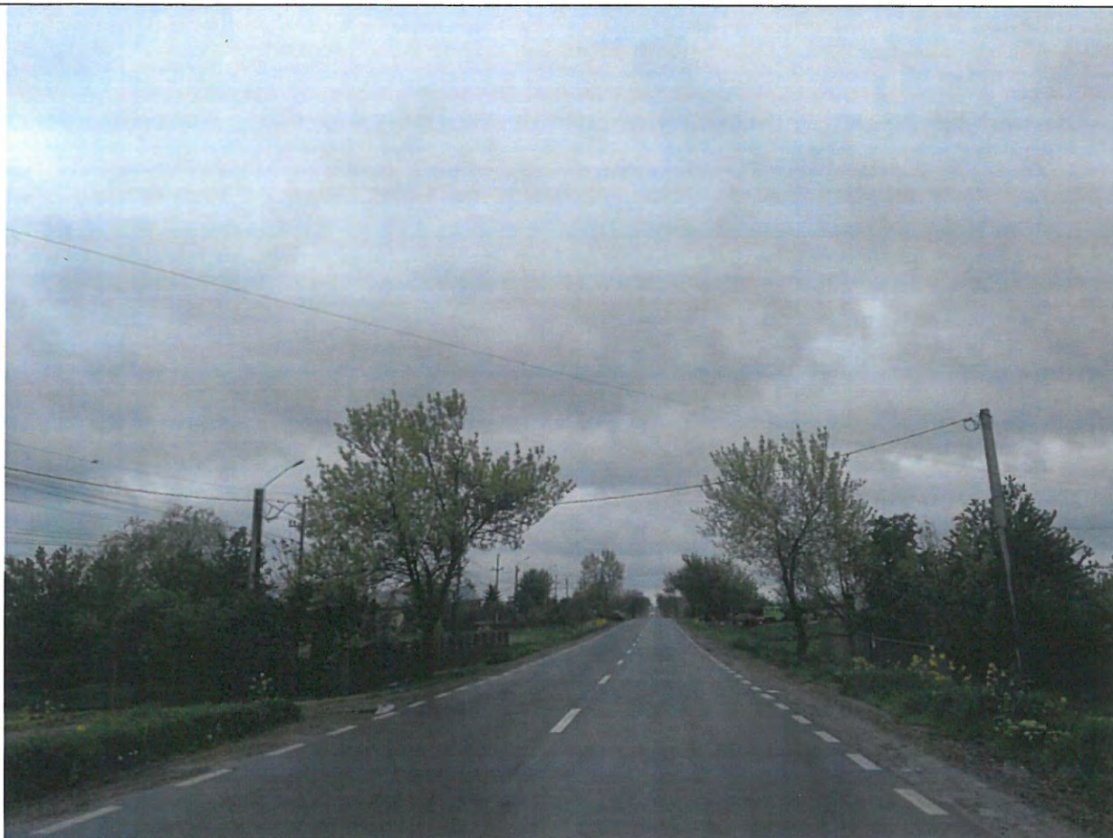
Foto 87: Drumul National DN 29B, km 27+000 -28+000 – Suprafata de rulare aflata intr-o stare optima de exploatare.
