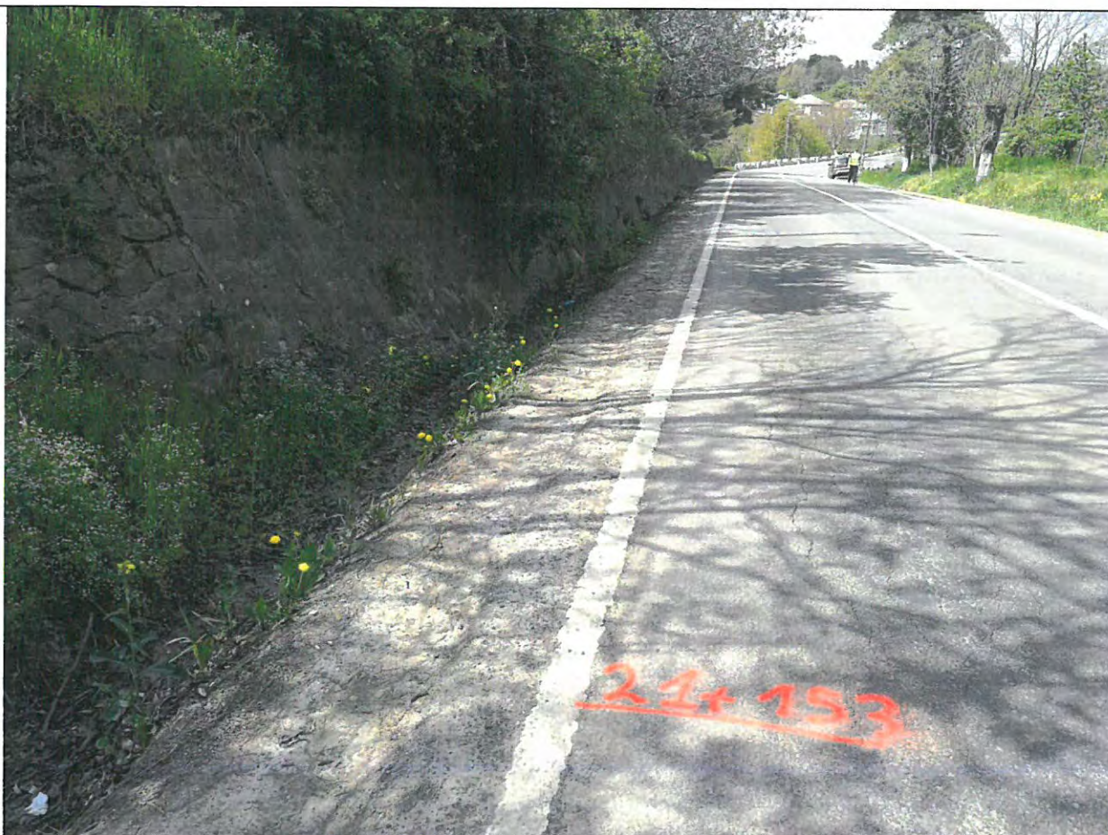
Foto 61: Drumul National DN 29B, km 21+000 -22+000 – Sant din pamant inierbat si colmatat. Zid de sprijin de debleu din zidarie de piatra.
