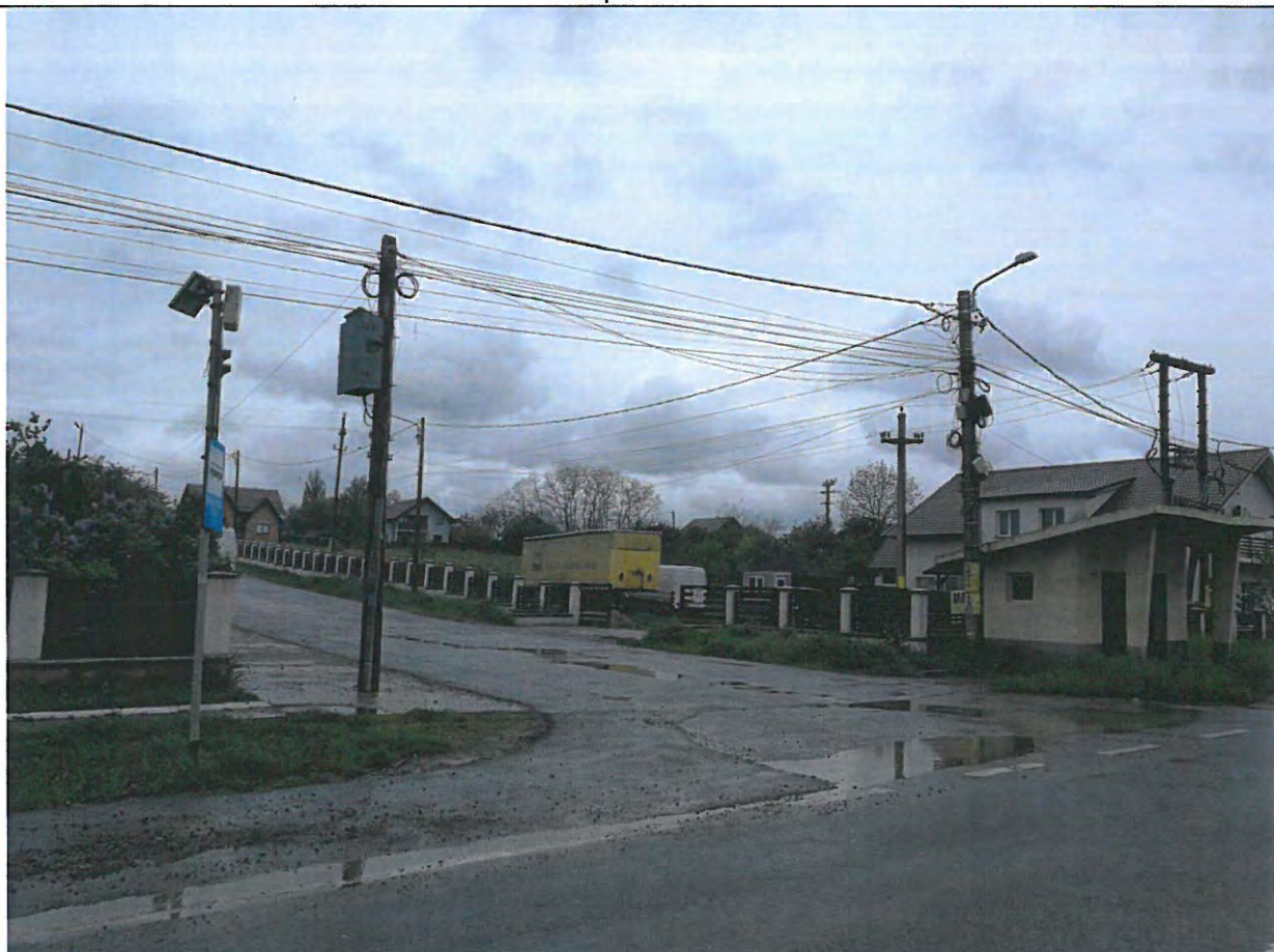
Foto 98: Drumul National DN 29B, km 30+000 -31+000 – Intersectie cu drum local. Apele stagneaza la nivelul partii carosabile.
