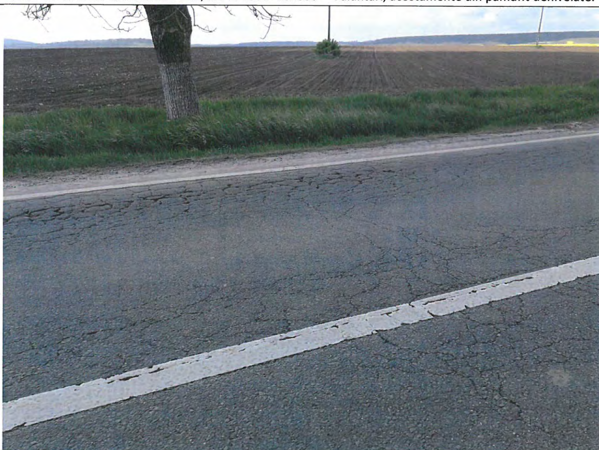
Foto 46: Drumul National DN 29B, km 17+000 -18+000 – Faientari si fagase longitudinale.
