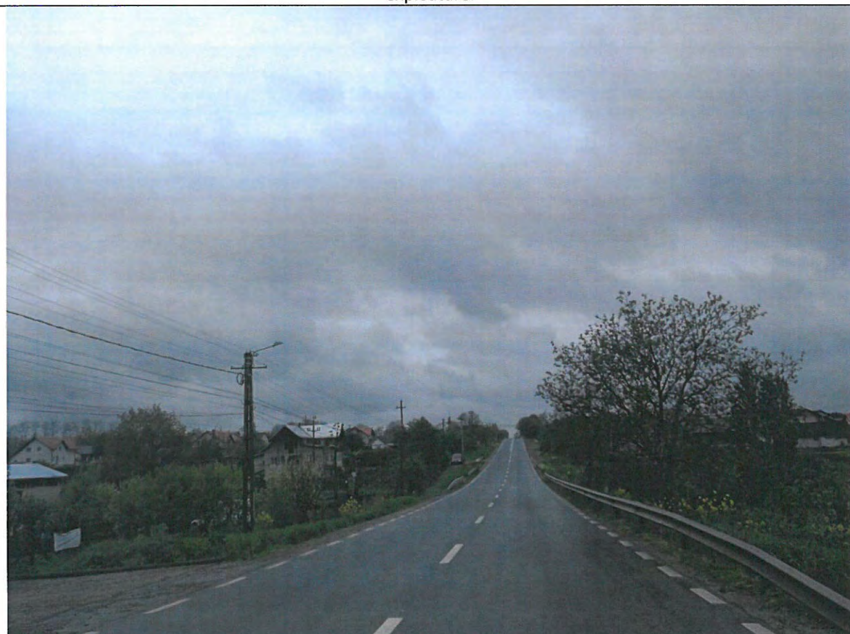
Foto 96: Drumul National DN 29B, km 29+000 -30+000 – Suprafata de rulare aflata intr-o stare optima de exploatare.
