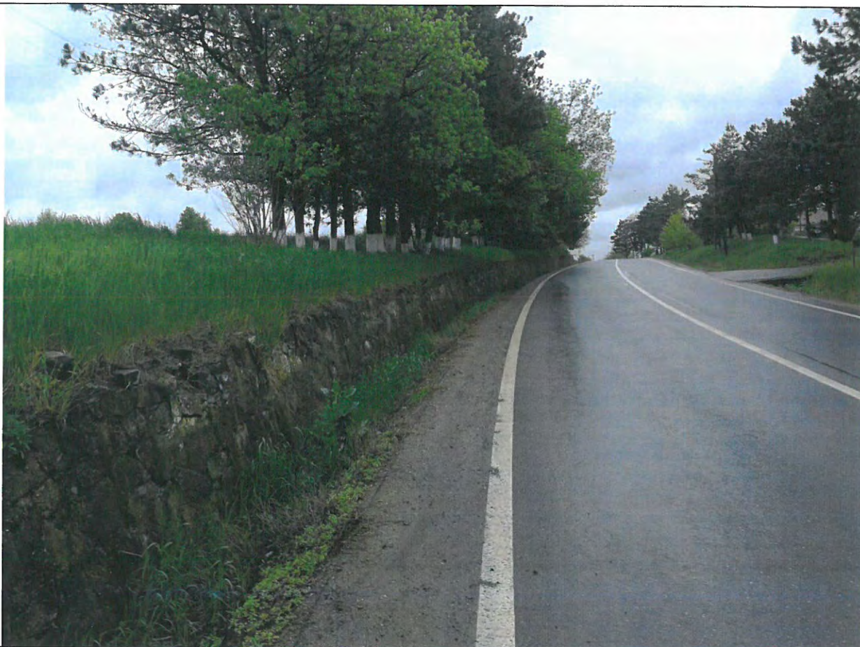
Foto 101: Drumul National DN 29B, km 31+000 -31+500 – Suprafata de rulare aflata intr-o stare optima de exploatare. Zid de sprijin de debleu din zidarie de piatra. Santuri colmatate si inierbate.
