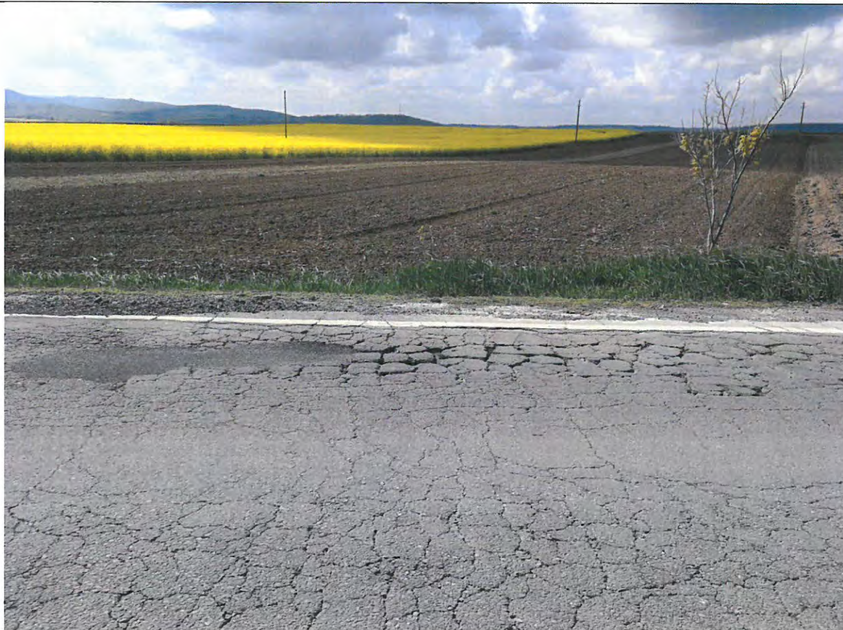
Foto 48: Drumul National DN 29B, km 17+000 -18+000 – Zone marginale cu faiantari pronuntate. Risc iminent de aparitie a gropilor.
