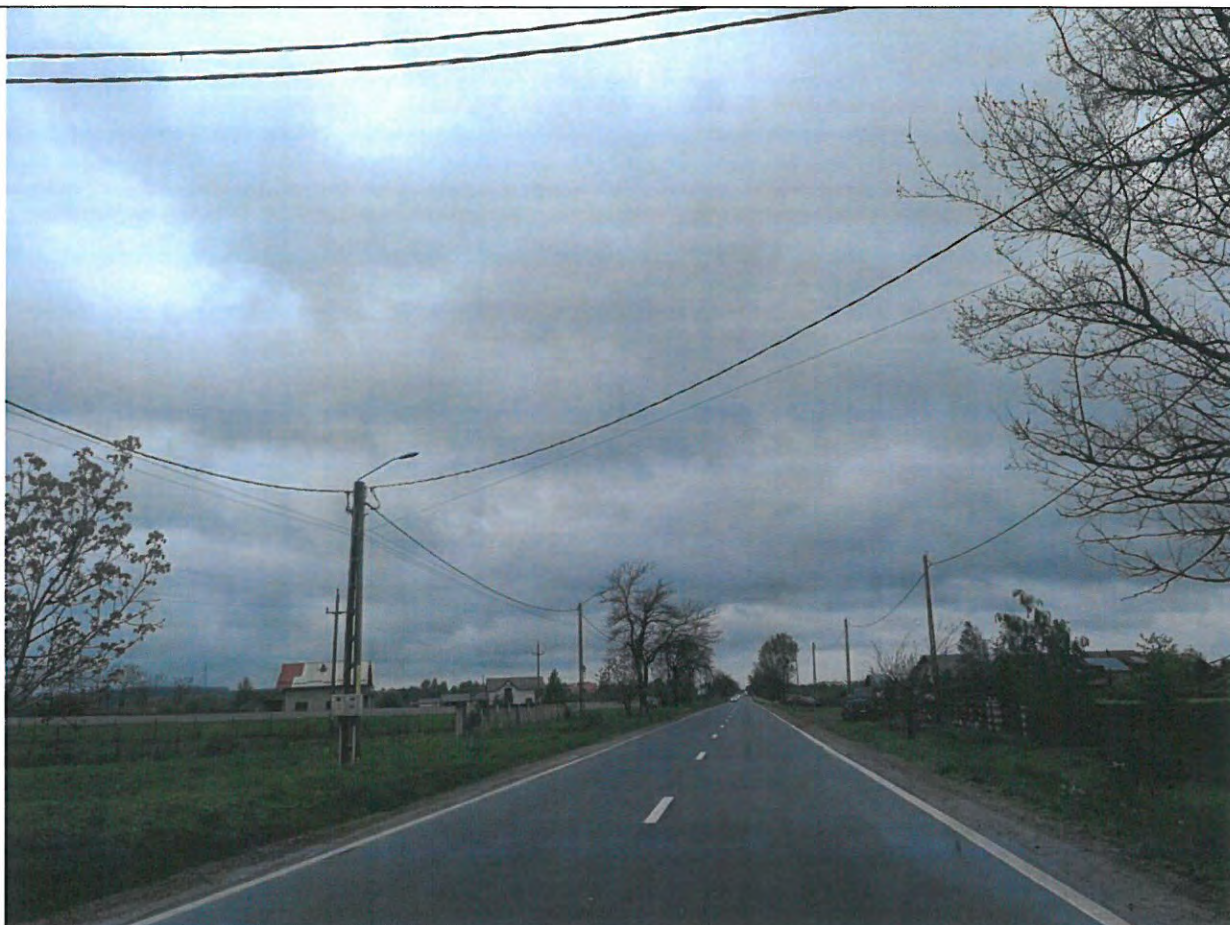
Foto 91: Drumul National DN 29B, km 28+000 -29+000 – Suprafata de rulare aflata intr-o stare optima de exploatare.
