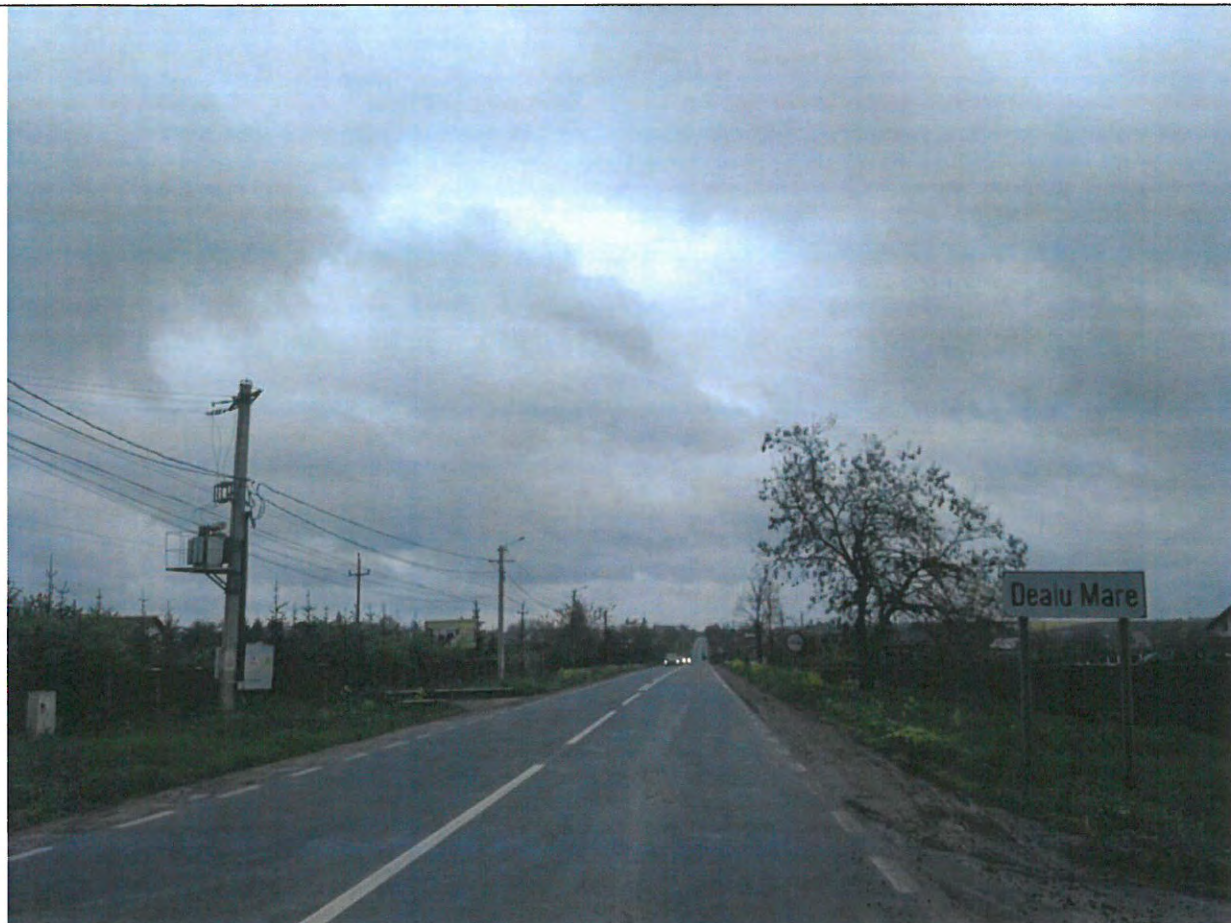
Foto 95: Drumul National DN 29B, km 29+000 -30+000 – Suprafata de rulare aflata intr-o stare optima de exploatare.
