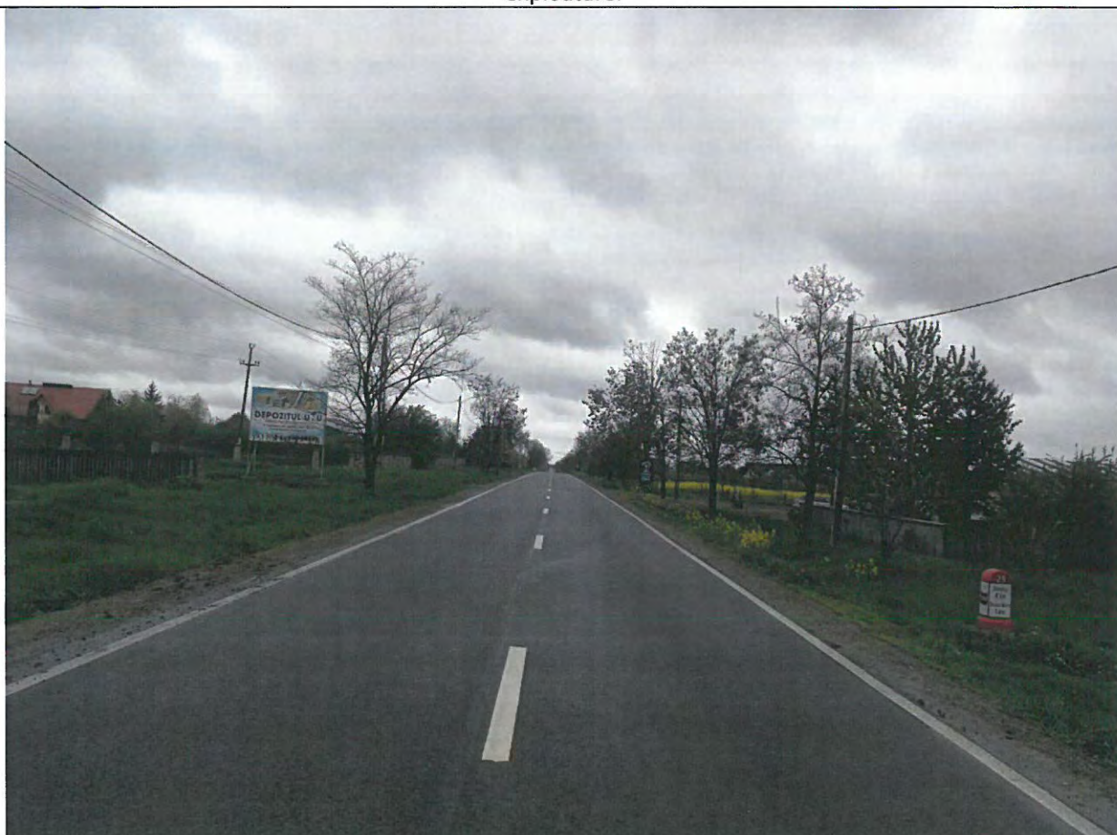
Foto 92: Drumul National DN 29B, km 28+000 -29+000 – Suprafata de rulare aflata intr-o stare optima de exploatare.
