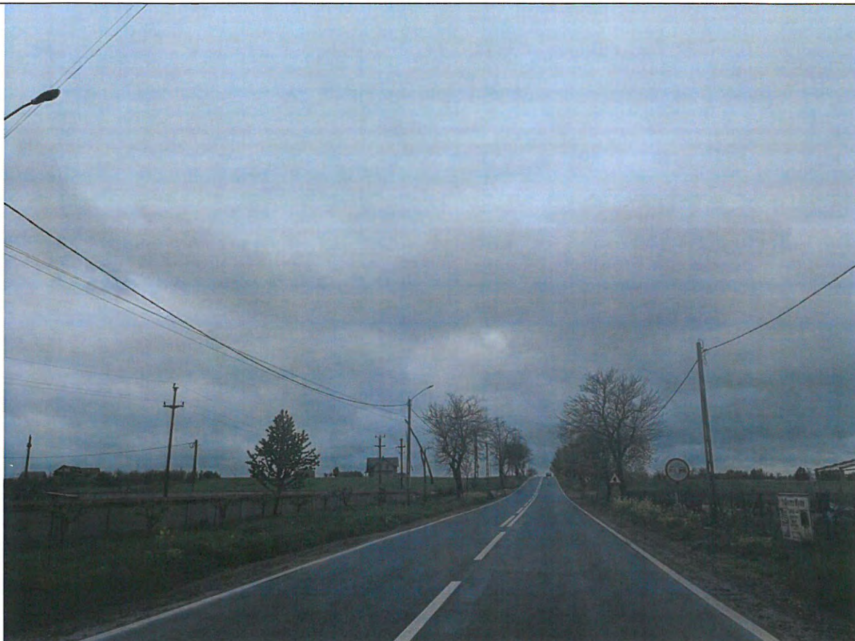
Foto 89: Drumul National DN 29B, km 28+000 -29+000 – Suprafata de rulare aflata intr-o stare optima de exploatare.
