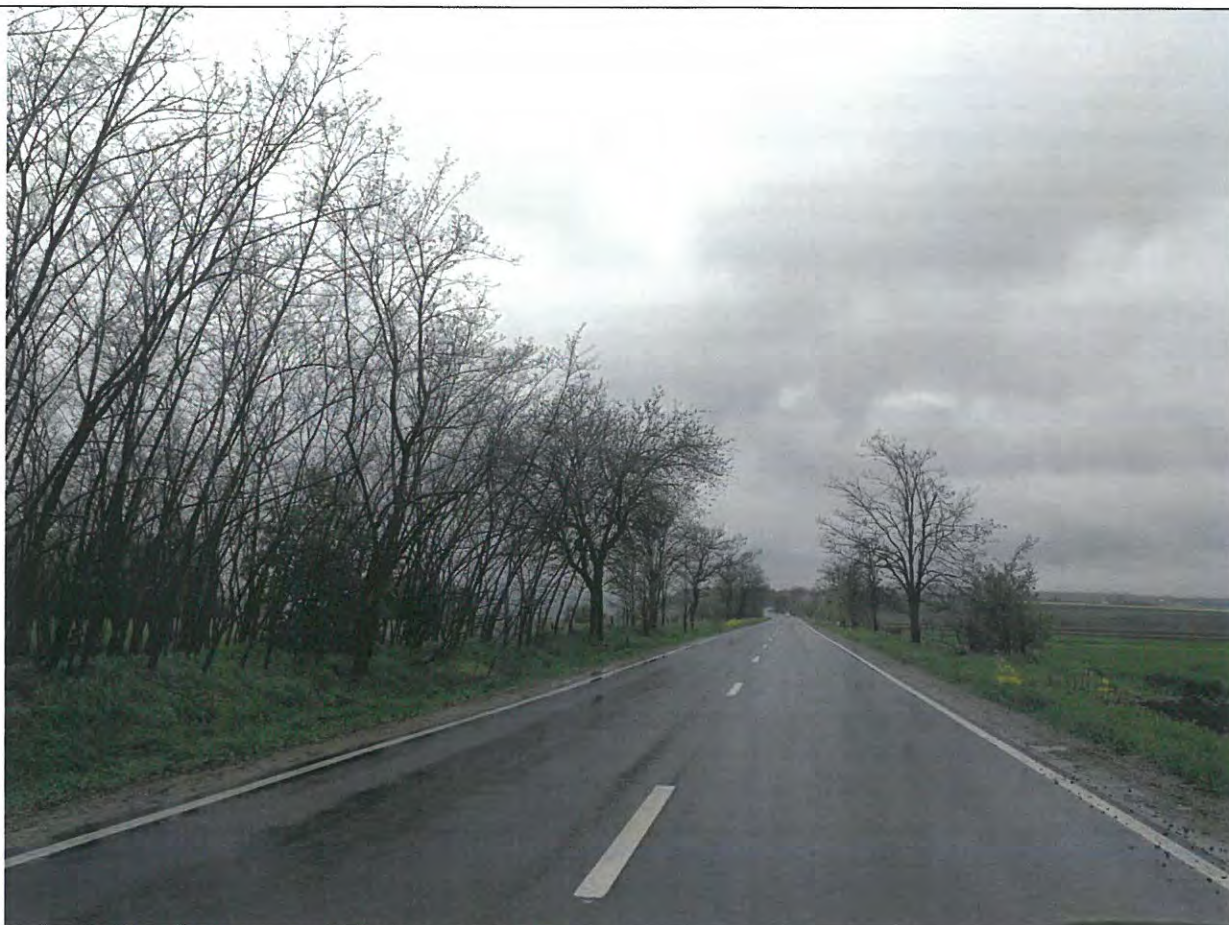
Foto 79: Drumul National DN 29B, km 25+000 -26+000 – Suprafata de rulare aflata intr-o stare optima de exploatare.
