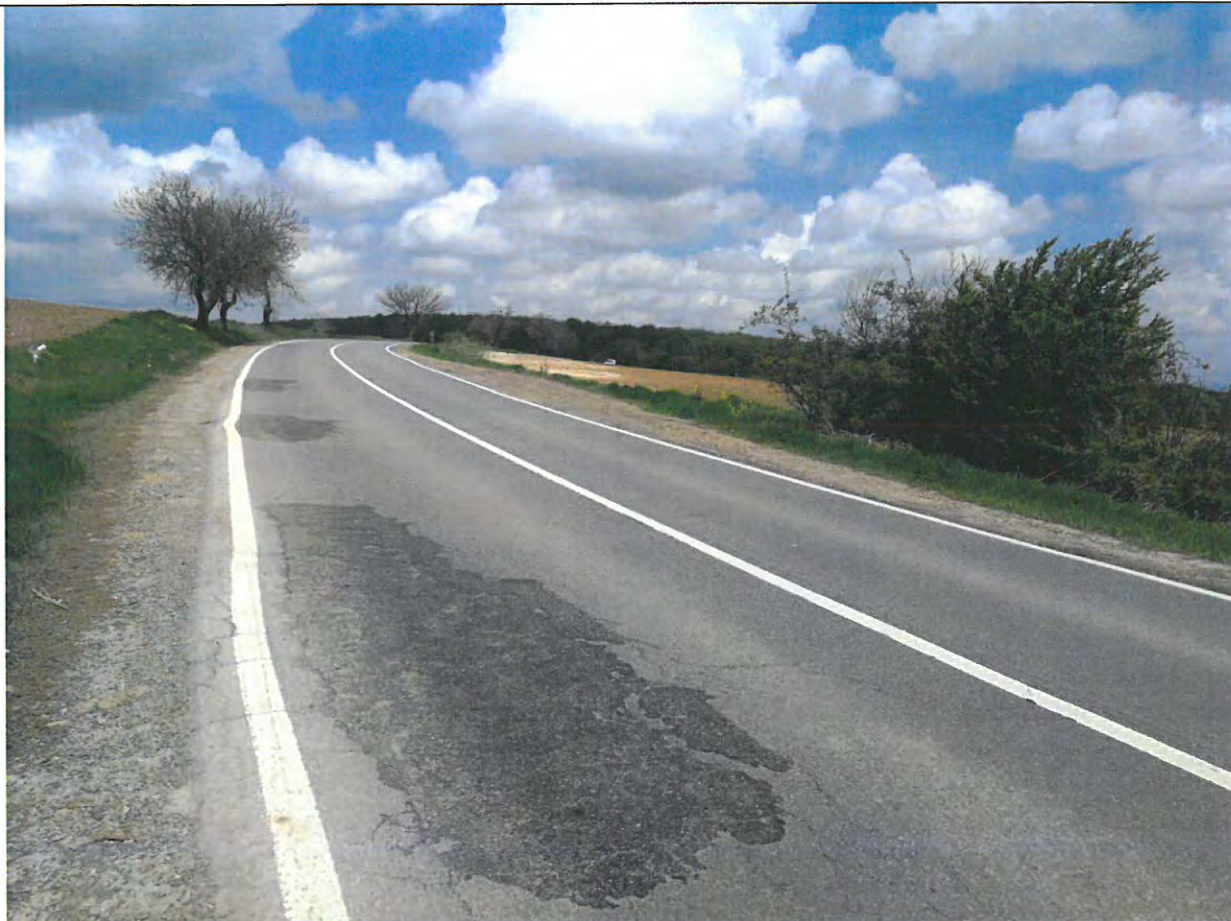
Foto 53: Drumul National DN 29B, km 19+000 -20+000 – Lucrari de reparatii prin acoperirea cu mastic bituminos a faiantarilor.
