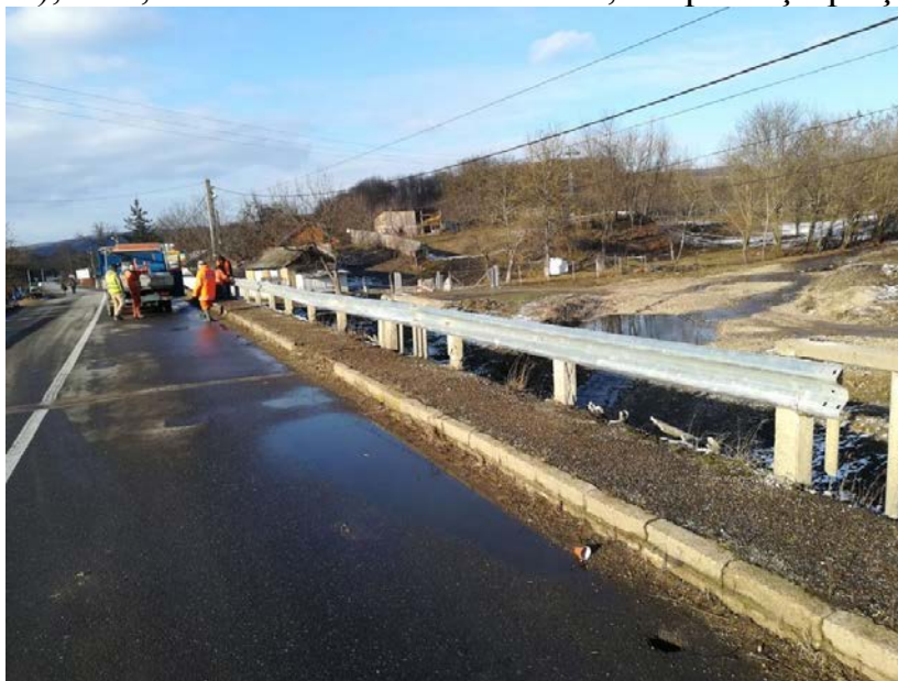
Foto DRDP Iași: reparații balustradă pod Varnița, pe DN2L
