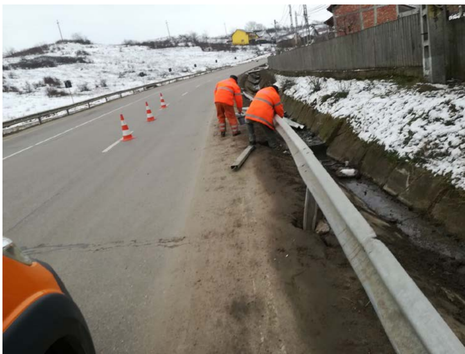
Foto DRDP Iași: refacere parapet DN28, panta Tomești
