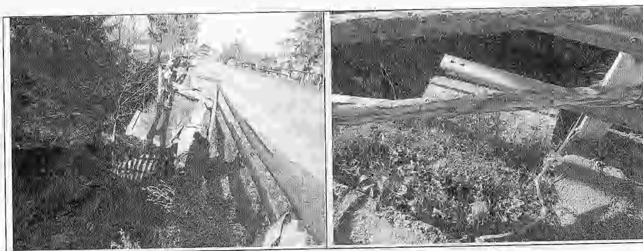
Foto. 3 - Degradarea avansata a parapetului si a bordurilor la trotuar
