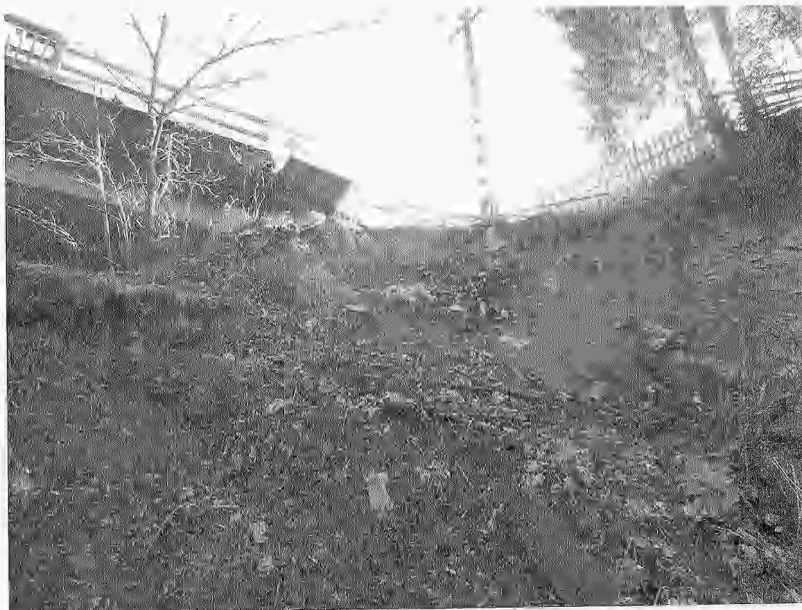
Foto. 7- Surpari masive de terasamente in zona rampelor de acces
