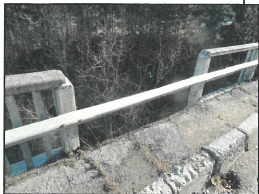
Gard proprietate privata
