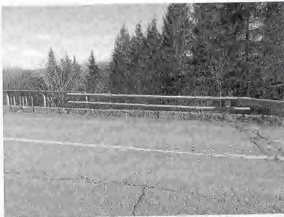
Foto. 3 - Degradarea avansata a parapetului si a bordurilor la trotuar
