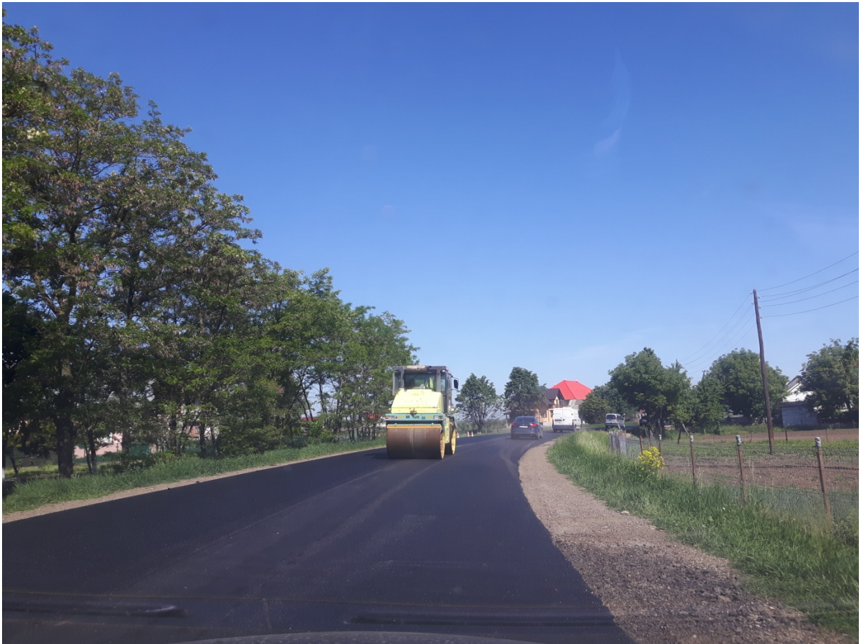
Covor asfaltic nou pe DN 2H, Milișăuți – Rădăuți, jud. Suceava
