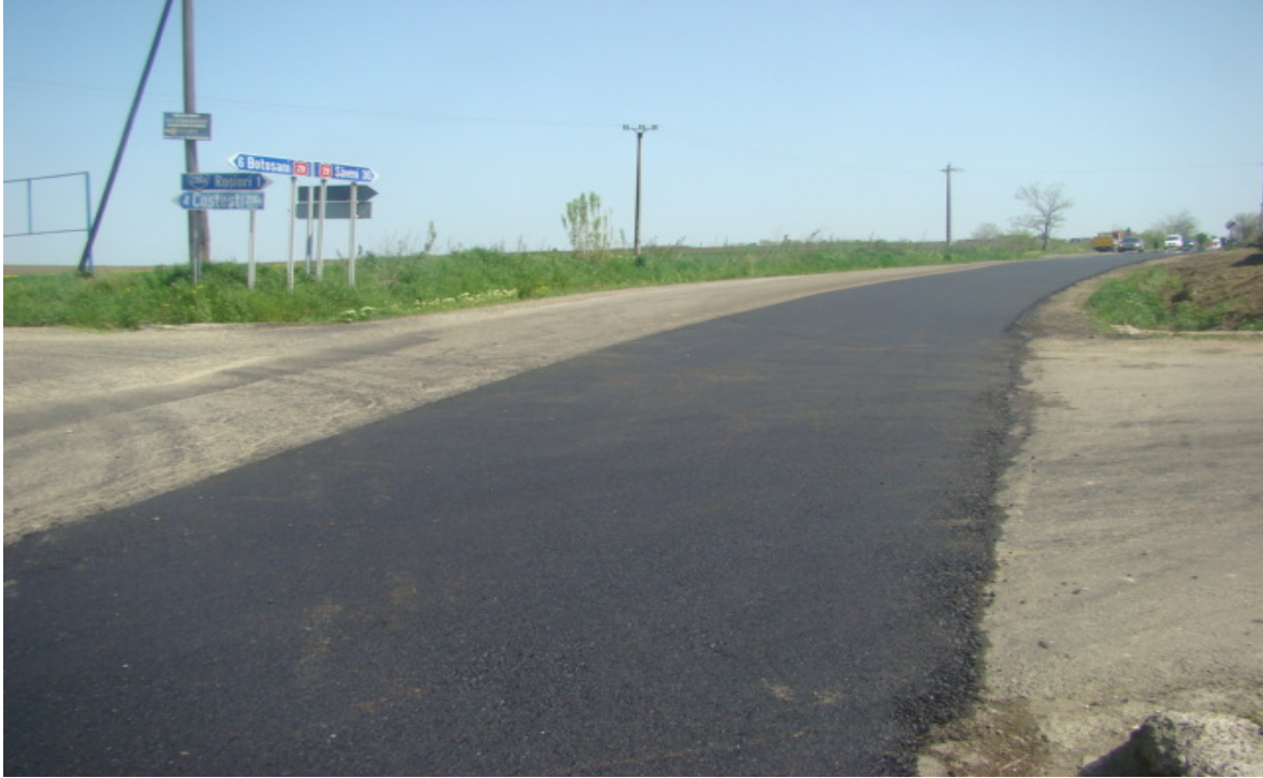
Reparații asfaltice pe DN 29A, Darabani, jud. Botoșani
