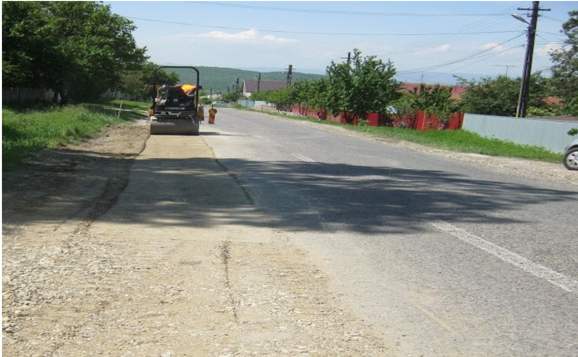
Eliminare burdușiri pe DN 2F, jud. Bacău
