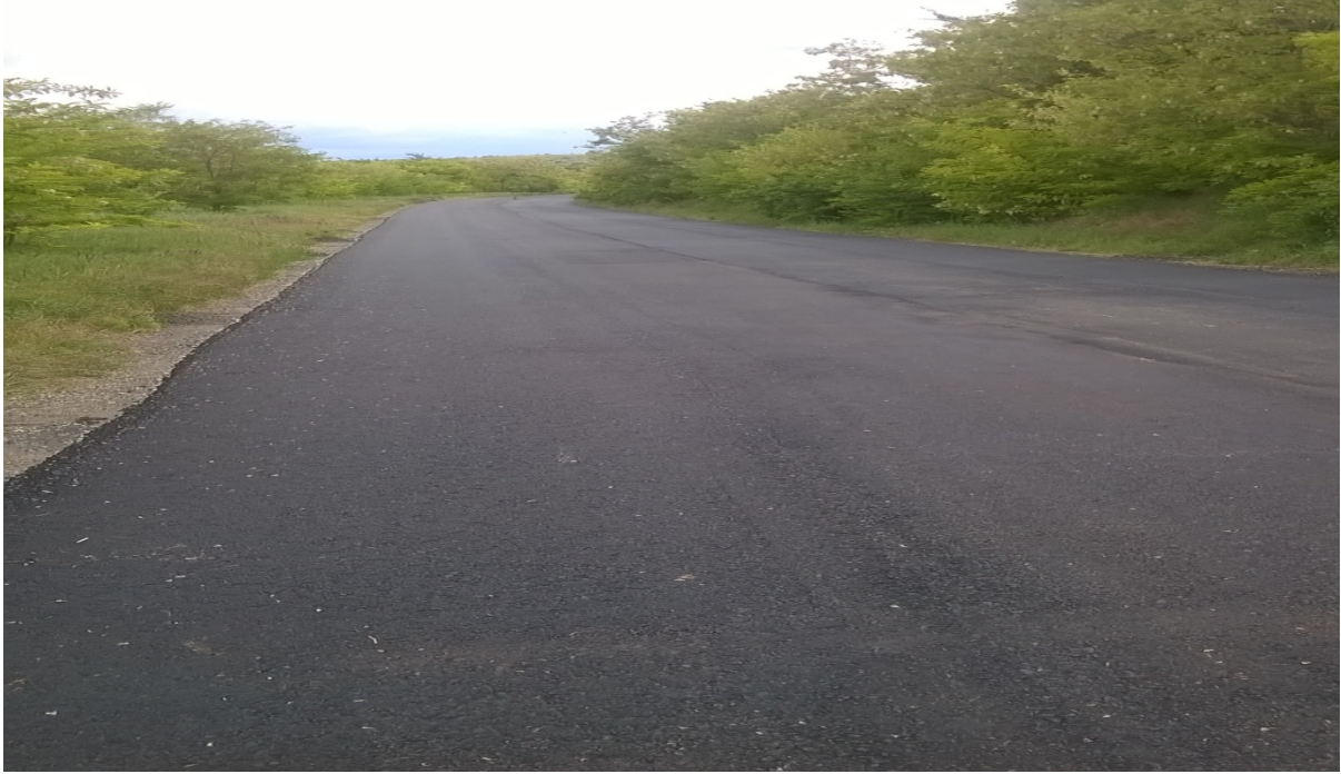
Covor asfaltic pe DN 26, jud Galați
