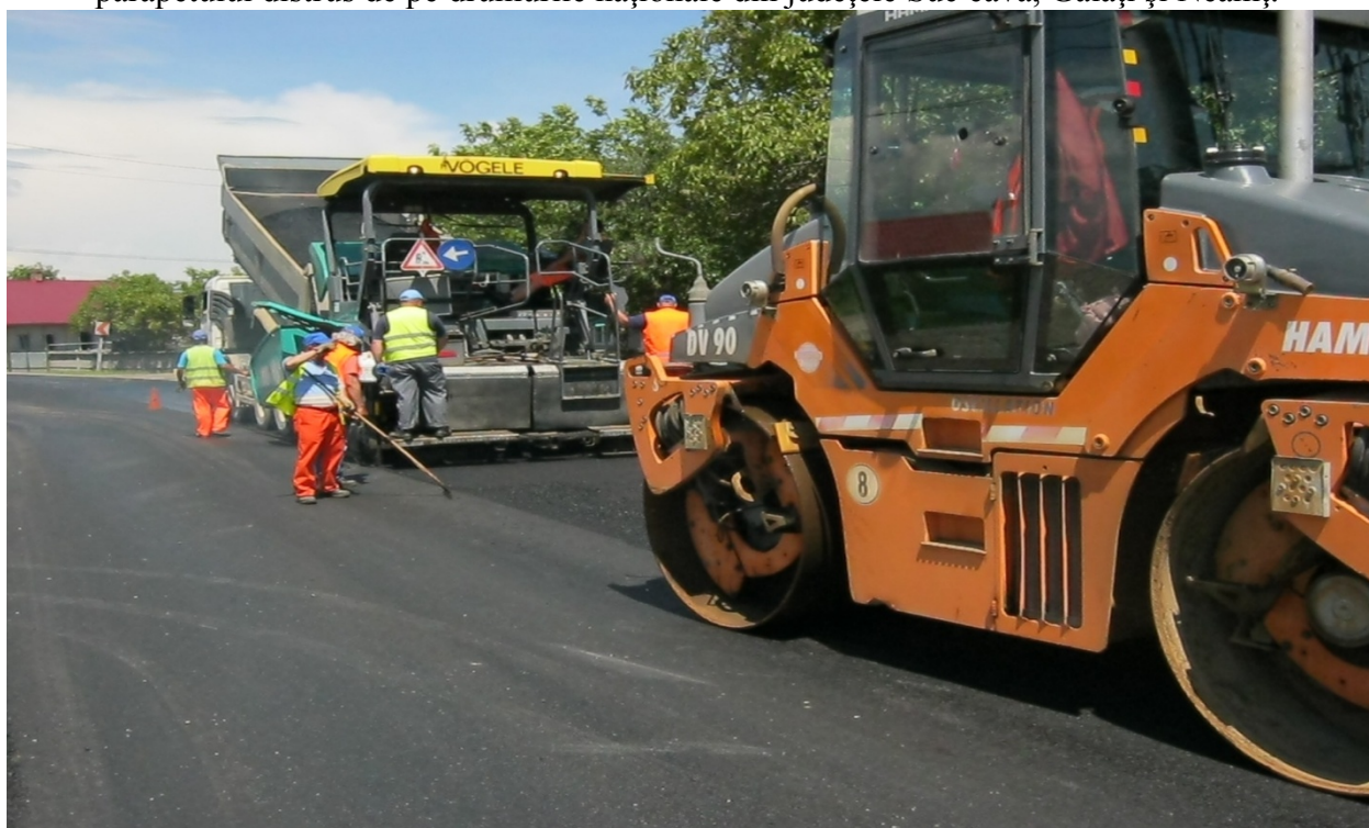
Turnare covor asfaltic pe DN 2E, sectorul Băișești – Păltinoasa(jud. Suceava)
