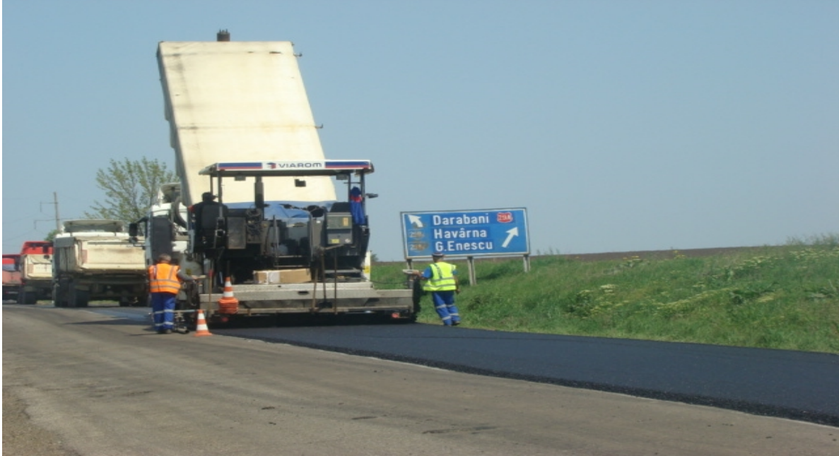
Cover asfaltic pe DN 29A, sectorul Dorohoi - Darabani
