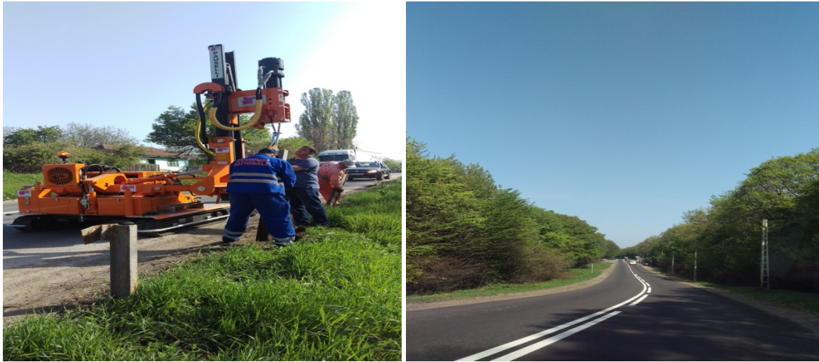
Înlocuire parapet degradat și trasare marcaj rutier pe DN 28A, jud. Iași
