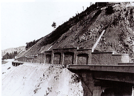
Cleionaje cu prefabricate „japoneze”
