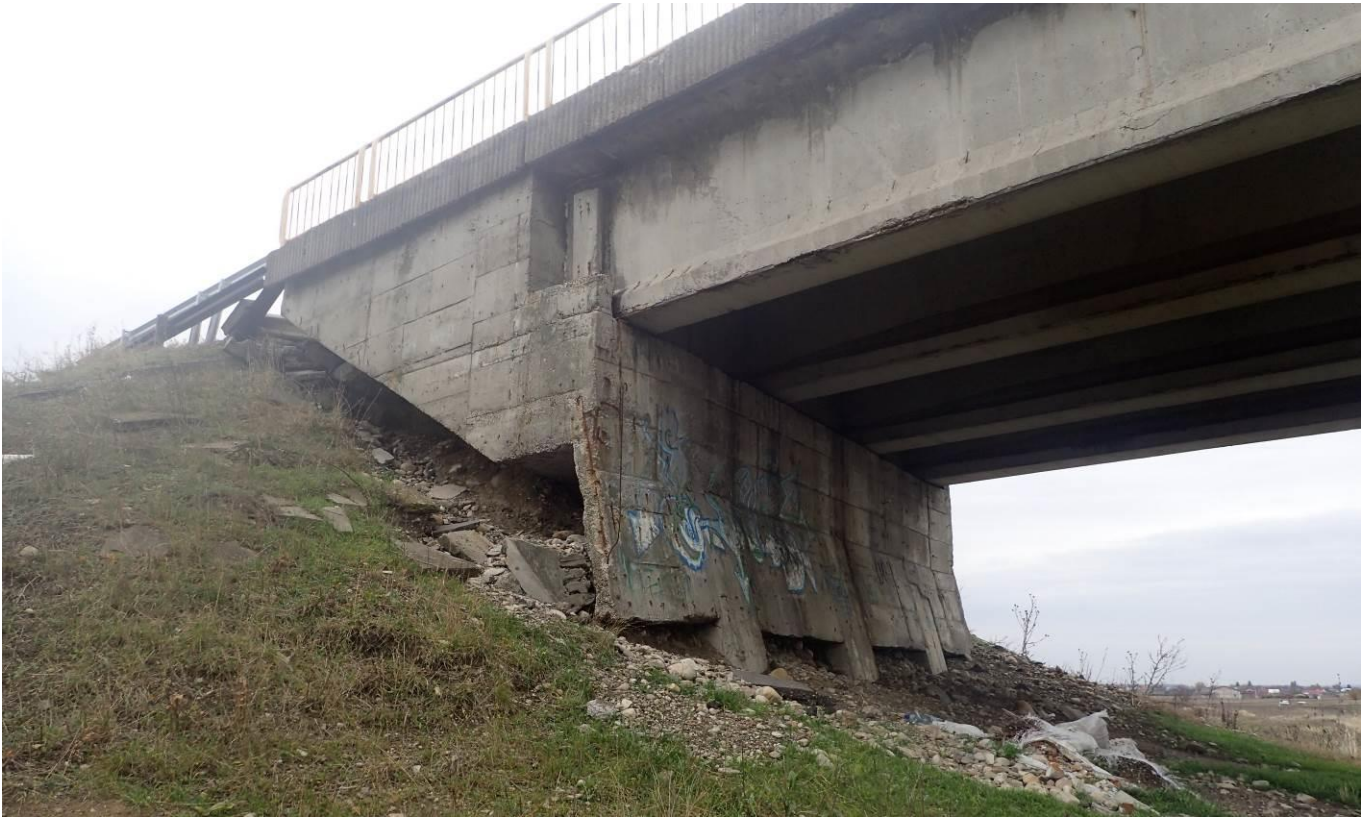
FOTO 9. Vedere culee Focsani – umplutura sfert de con tasata
