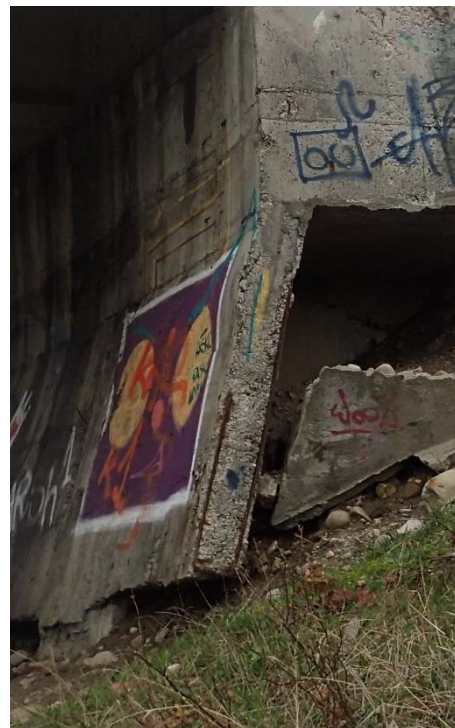
FOTO 13. Defecte de suprafata ale fetei vazute (culoare neuniforma, pete negre, impuritati) – culee Infiltratii in zona rostului
