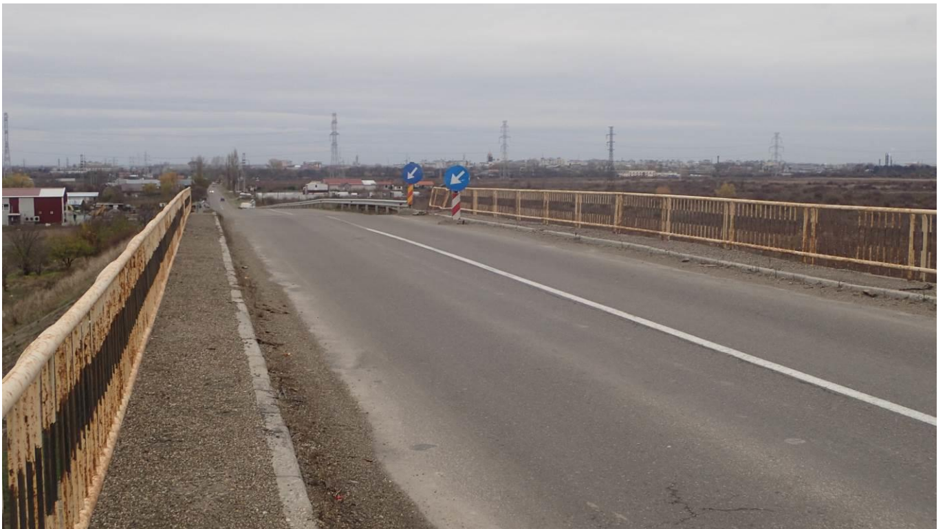
FOTO 3. Vedere cale pe pod
