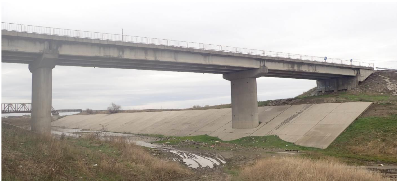
FOTO 1. Vedere laterala pod din aval
