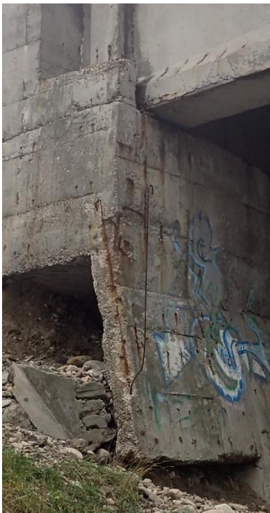
FOTO 13. Defecte de suprafata ale fetei vazute (culoare neuniforma, pete negre, impuritati) – culee Infiltratii in zona rostului
