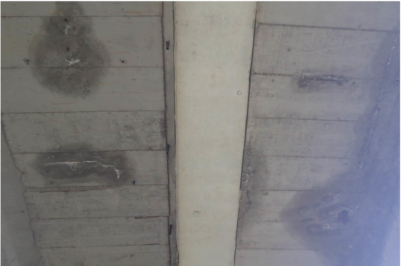
FOTO 7. Infiltratii si eflorescente la intrados
