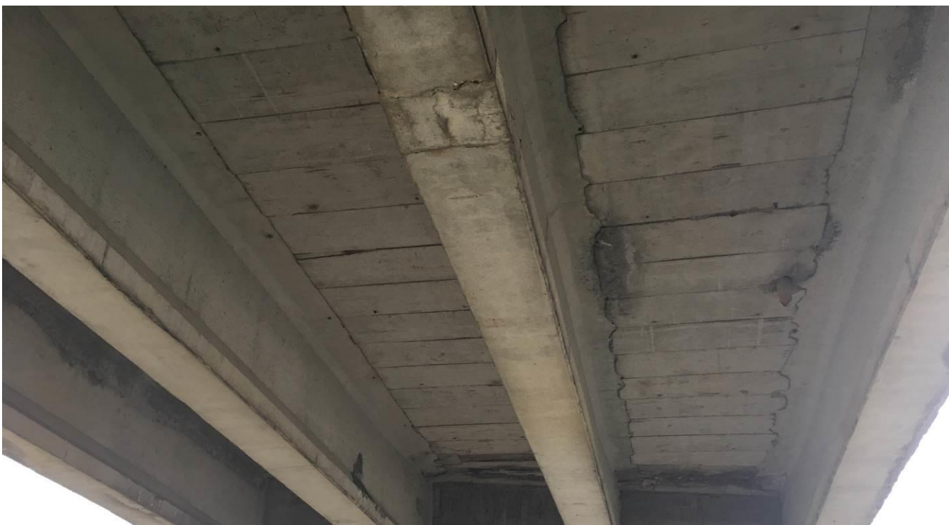
FOTO 2. Vedere intrados pod
