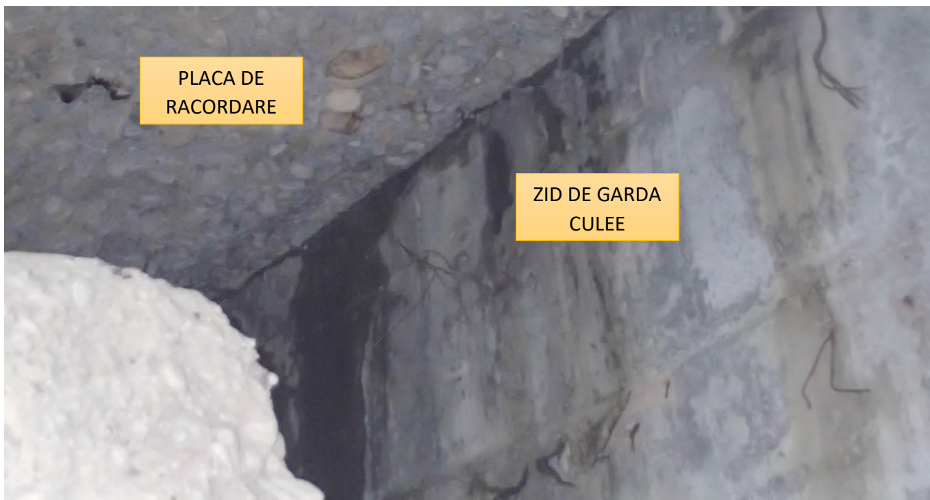
FOTO 21. Vedere caverna sub placa de racordare
