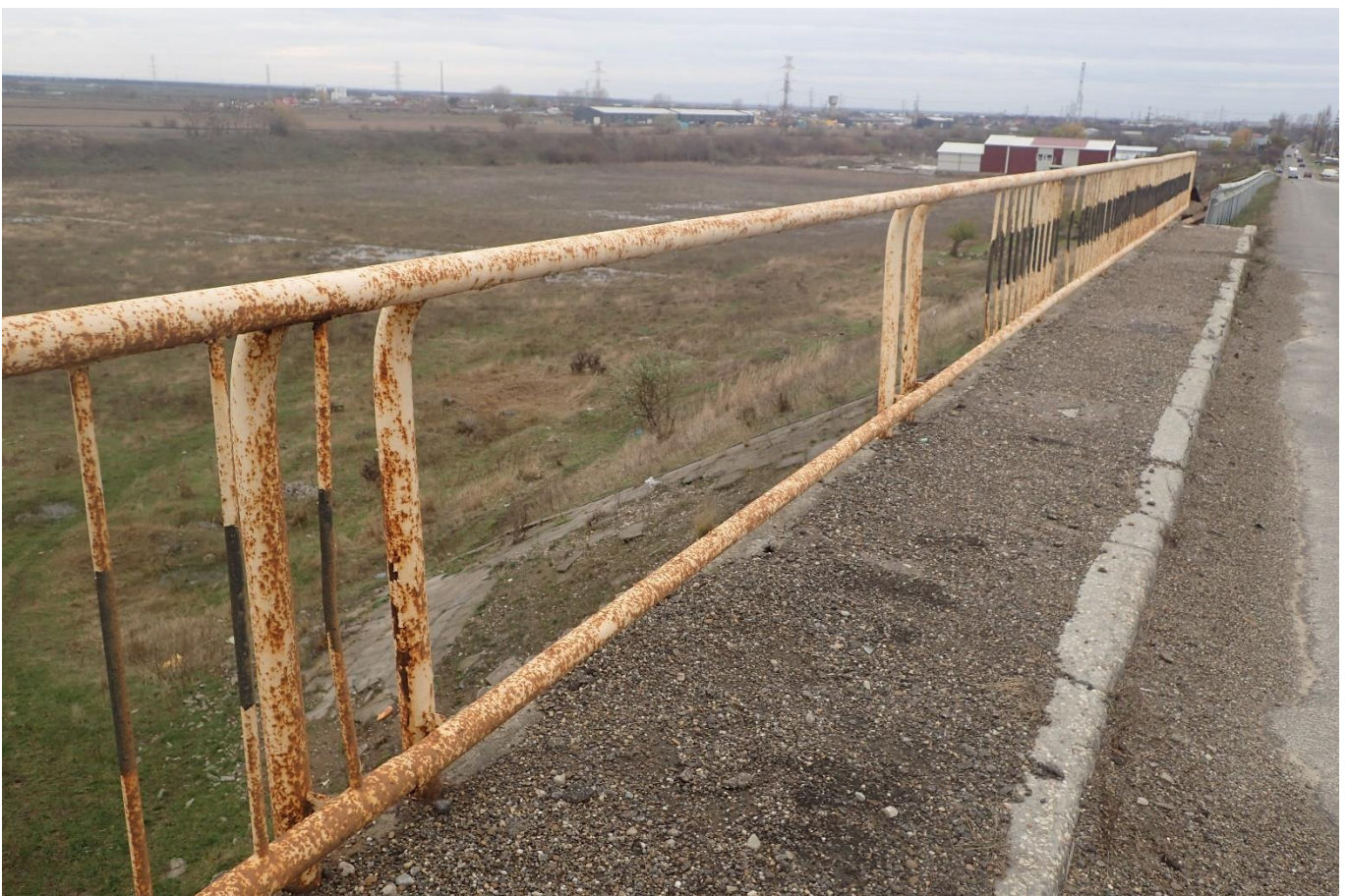
FOTO 24. Parapet pietonal degradat cu elemente lipsa
