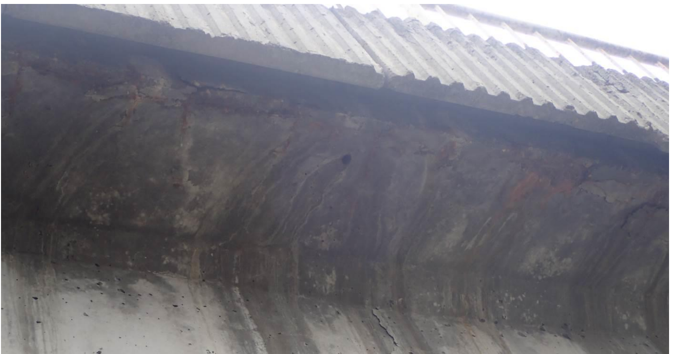
FOTO 7. Infiltratii si eflorescente la intrados
