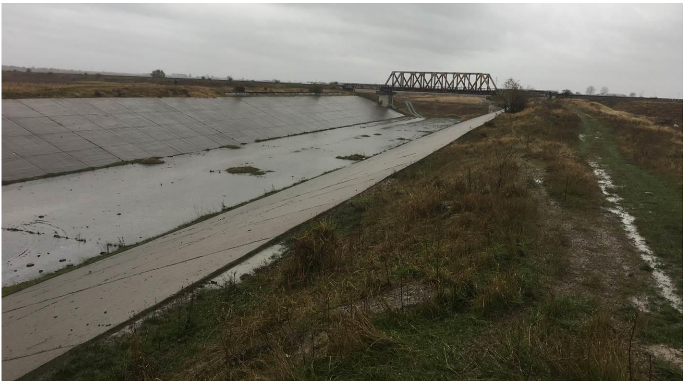
FOTO 4. Vedere canal Siret-Baragan spre amonte
