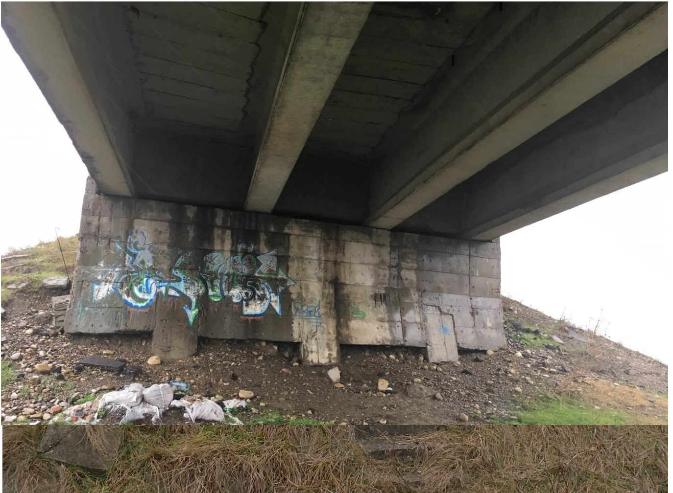
FOTO 13. Defecte de suprafata ale fetei vazute (culoare neuniforma, pete negre, impuritati) – culee Infiltratii in zona rostului
