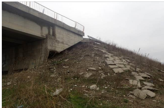
FOTO 17. Sfert de con culee Focsani stanga
