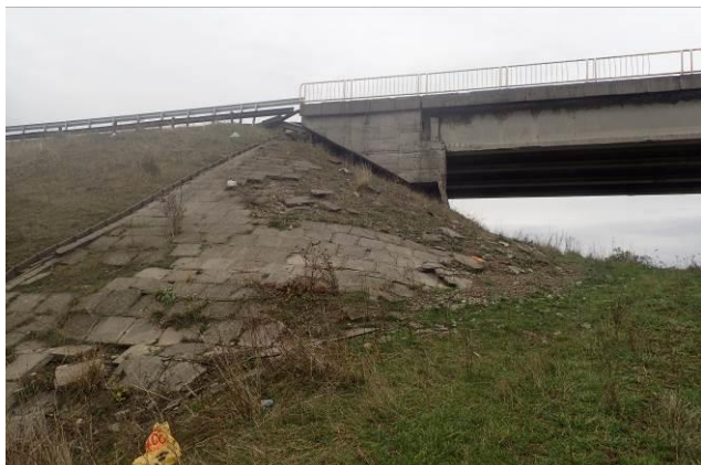
FOTO 16. Sfert de con culeea Focsani dreapta
