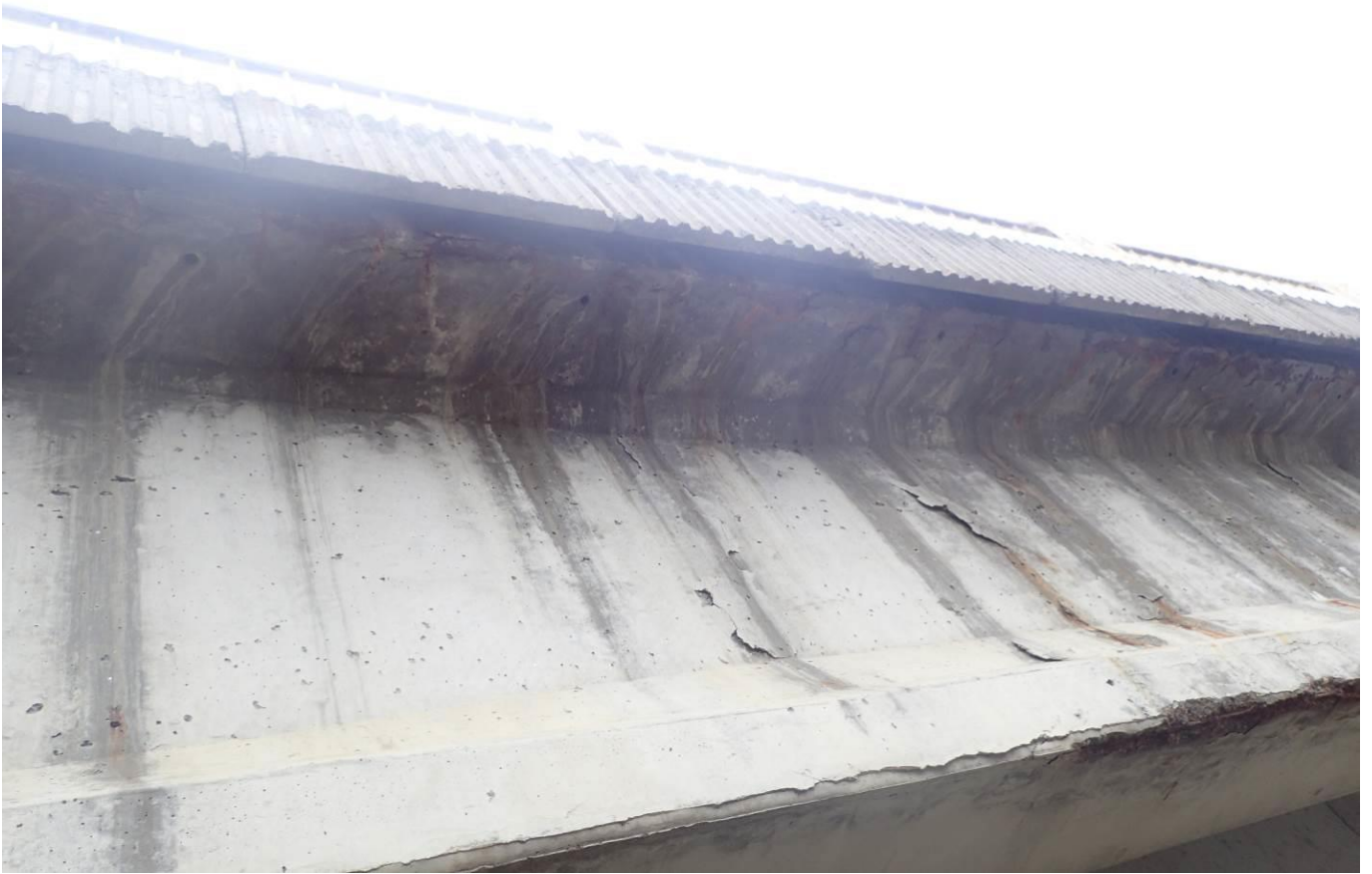
FOTO 5. Grinzi cu defecte de suprafata ale fetei vazute (culoare neuniforma, pete negre, impuritati, pete de rugina, aspect prafuit, imperfectiuni geometrice, aspect macroporos, agregate la suprafata).
