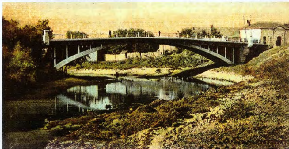
Podul de la Tecuci peste râul Bârlad. Pod din beton armat cu boltă dublă, cu o deschidere de 50 de metri - unicat în România (construit în anul 1912).
