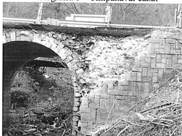
Fotografia 8 – Zidărie degradată
