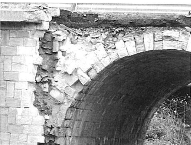
Fotografia 7 – Zidărie degradată
