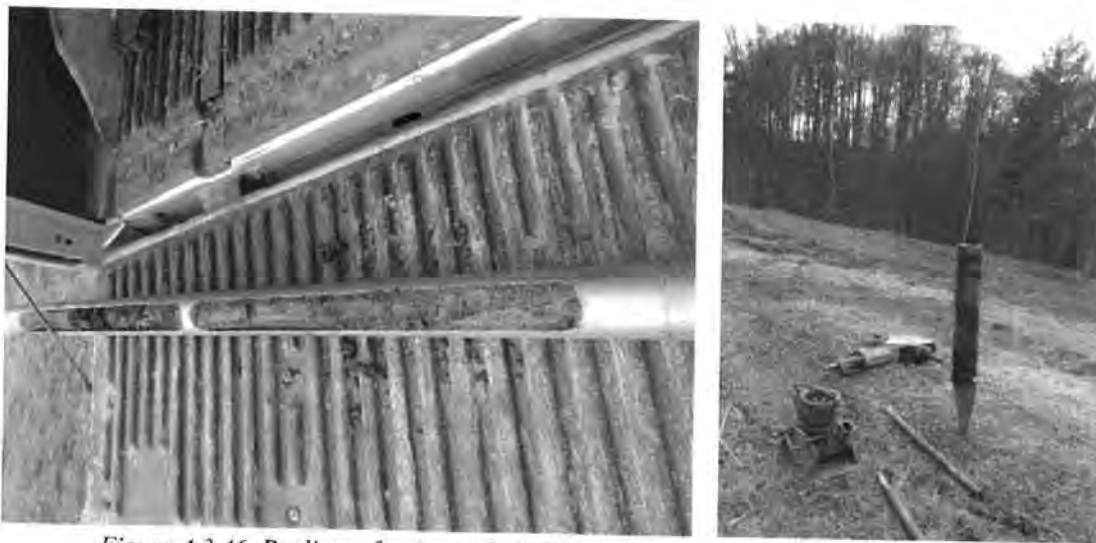
Figura 4.3.46. Realizare foraj geotehnic F46 și prelevarea eșantioanelor de pământ
