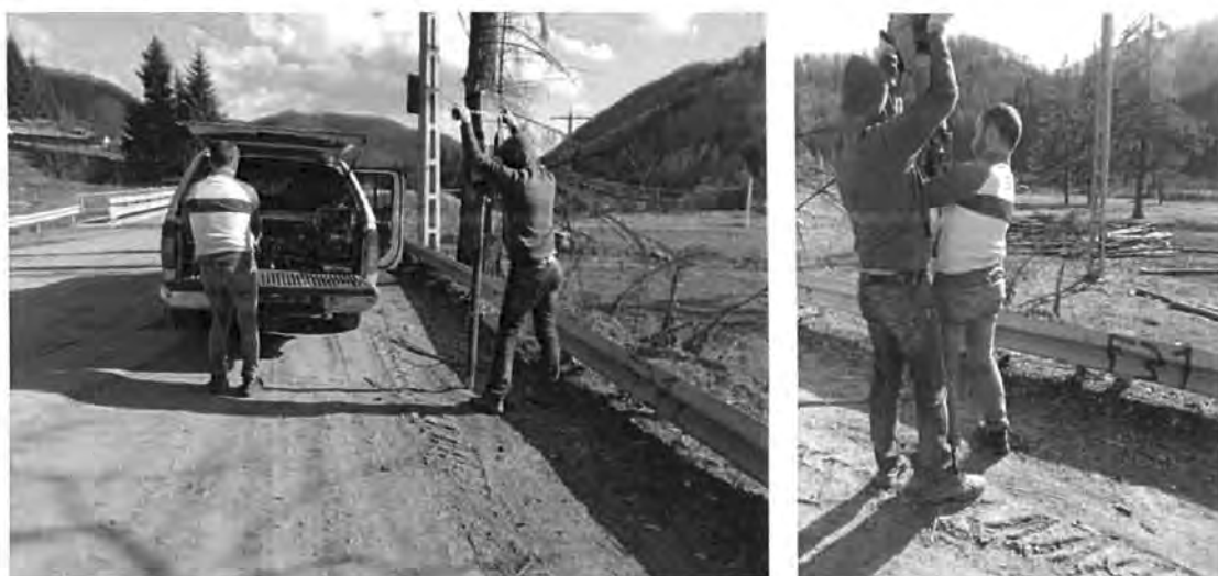
Figura 4.3.31. Realizare foraj geotehnic F31 și prelevarea eșantioanelor de pământ
