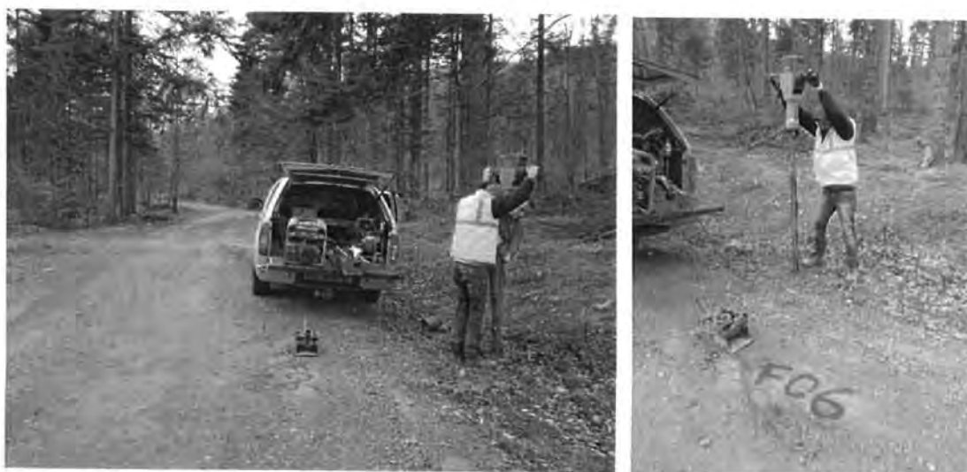
Figura 4.3.6. Realizare foraj geotehnic F06 și prelevarea eșantioanelor de pământ
