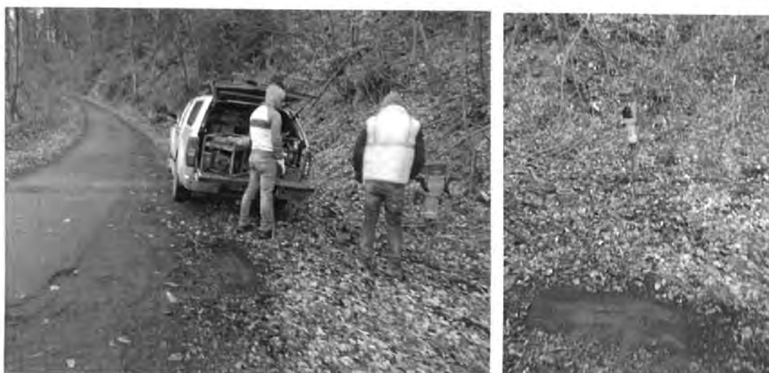
Figura 4.3.13. Realizare foraj geotehnic F13 și prelevarea eșantioanelor de pământ
