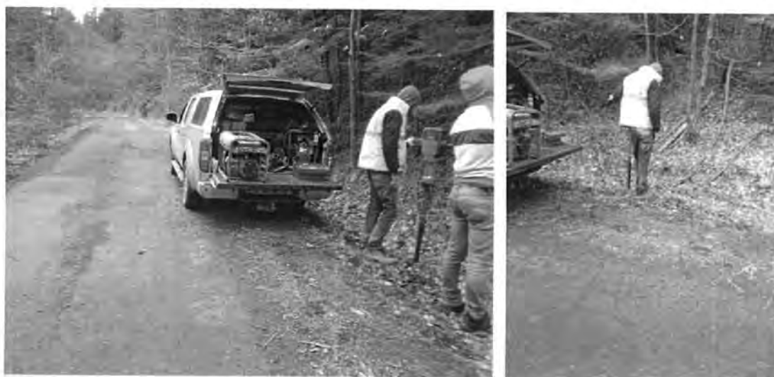
Figura 4.3.16. Realizare foraj geotehnic F16 și prelevarea eșantioanelor de pământ
