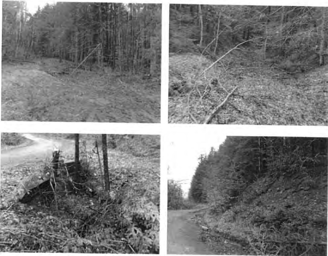
Fig 2.5.10. Zona km 66+440 – km 66+780
