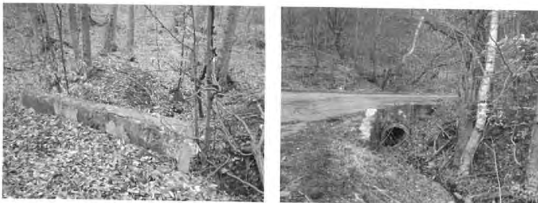
Fig 2.5.15. Zona km 69+600 – km 69+920
