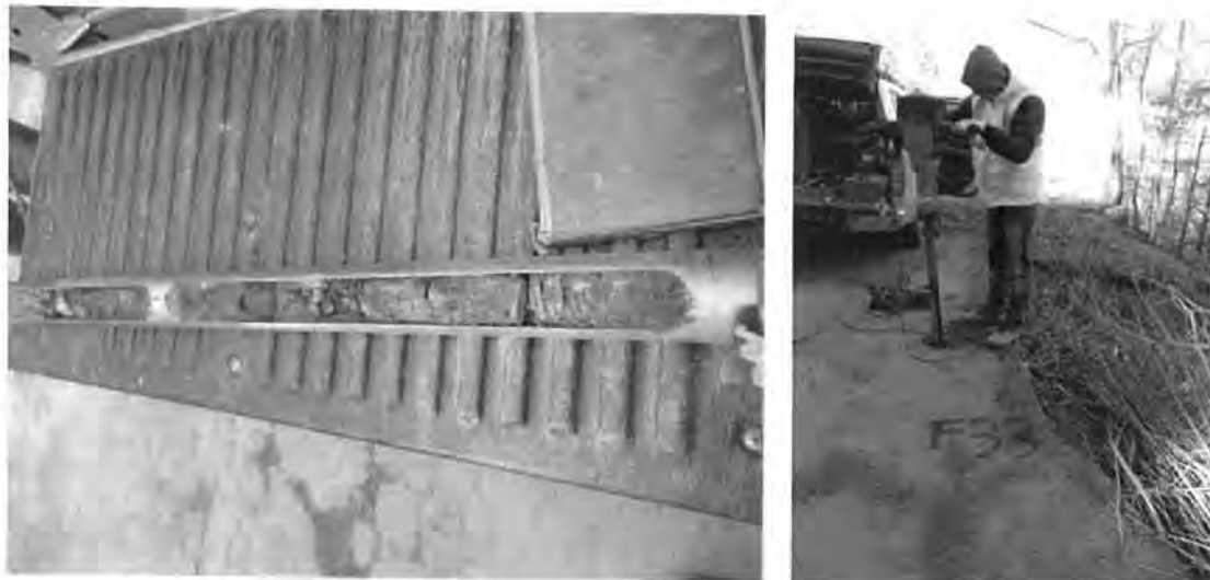
Figura 4.3.33. Realizare foraj geotehnic F33 și prelevarea eșantioanelor de pământ
