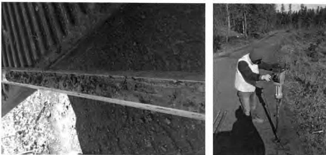
Figura 4.3.34. Realizare foraj geotehnic F34 și prelevarea eșantioanelor de pământ
