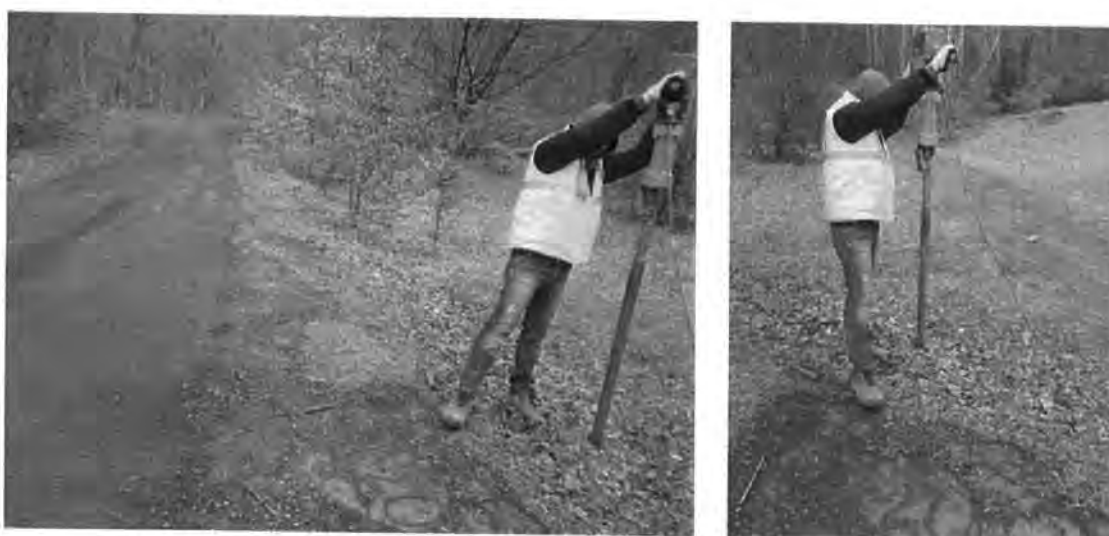
Figura 4.3.20. Realizare foraj geotehnic F20 și prelevarea eșantioanelor de pământ
