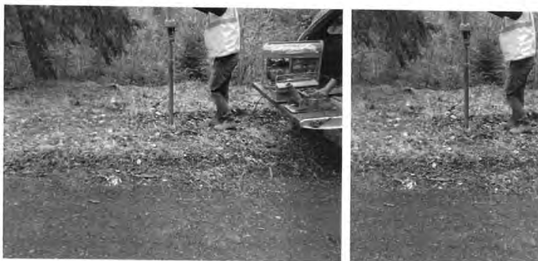
Figura 4.3.14. Realizare foraj geotehnic F14 și prelevarea eșantioanelor de pământ
