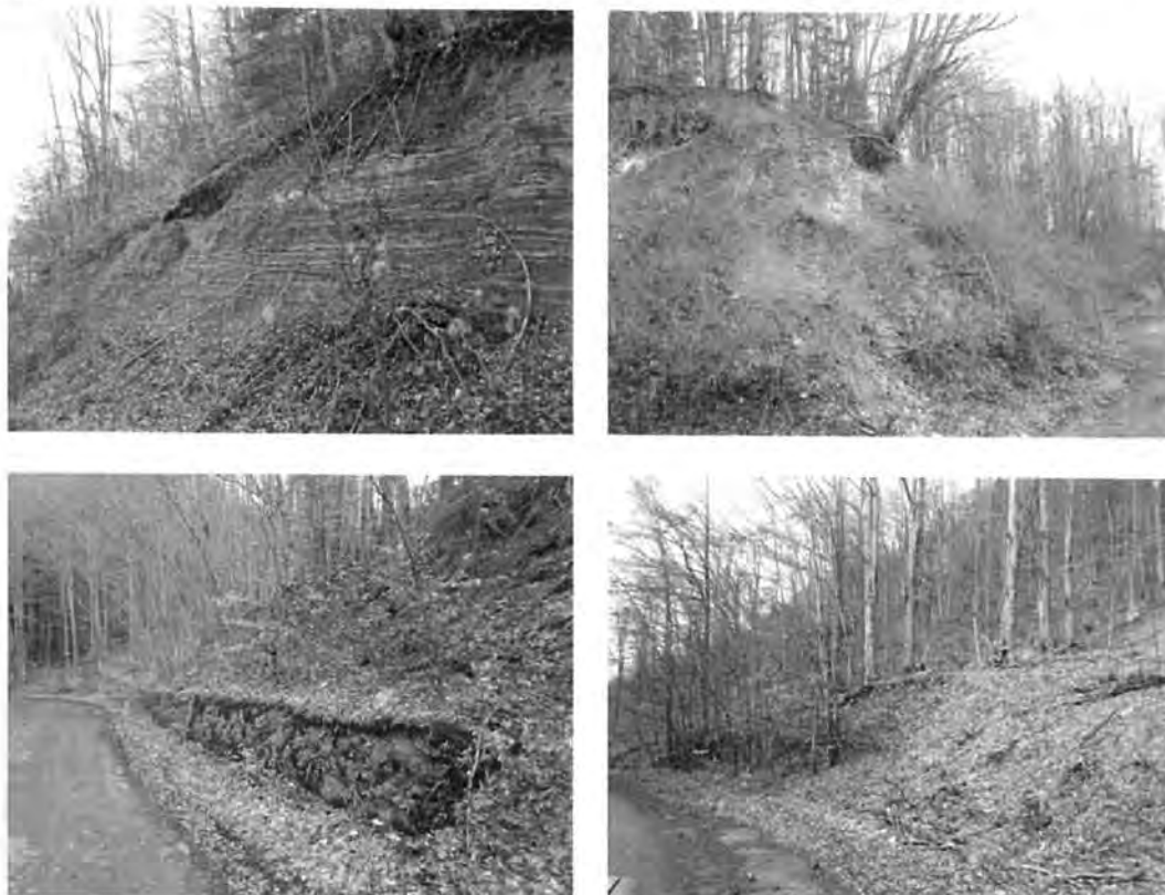
Fig 2.5.13. Zona km 68+080 – km 68+540
