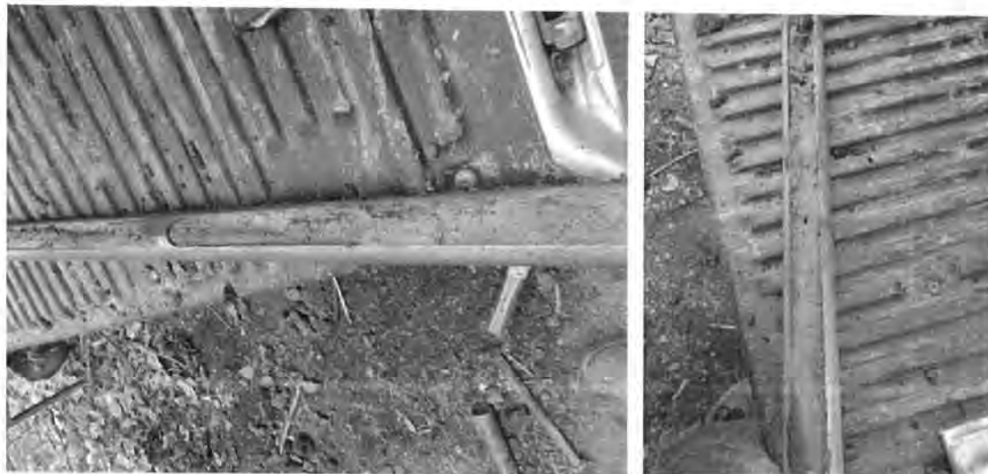
Figura 4.3.44. Realizare foraj geotehnic F44 și prelevarea eșantioanelor de pământ
