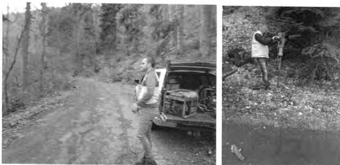
Figura 4.3.12. Realizare foraj geotehnic F12 și prelevarea eșantioanelor de pământ
