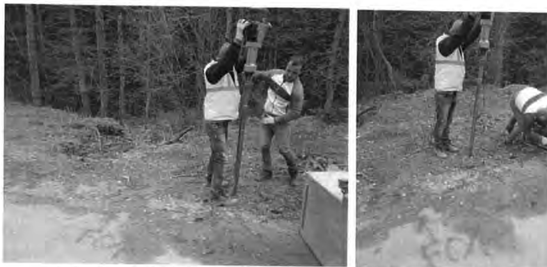
Figura 4.3.1. Realizare foraj geotehnic F01 și prelevarea eșantioanelor de pământ
