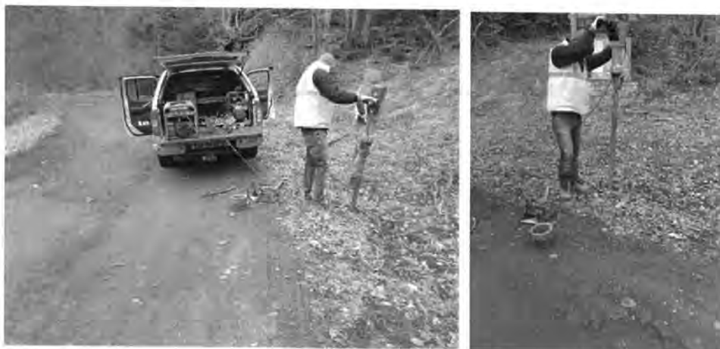
Figura 4.3.17. Realizare foraj geotehnic F17 și prelevarea eșantioanelor de pământ
