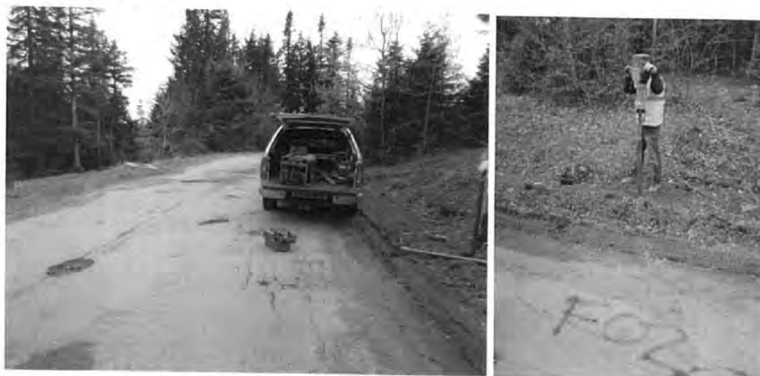
Figura 4.3.2. Realizare foraj geotehnic F02 și prelevarea eșantioanelor de pământ
