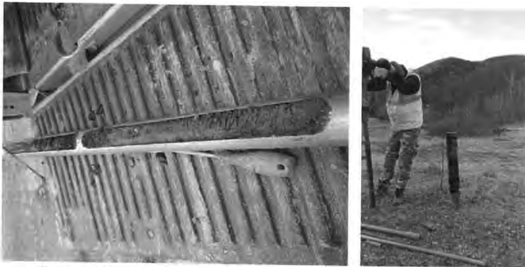
Figura 4.3.45. Realizare foraj geotehnic F45 și prelevarea eșantioanelor de pământ
