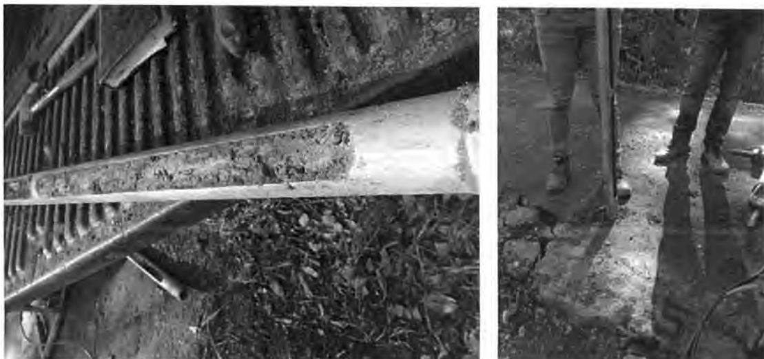
Figura 4.3.35. Realizare foraj geotehnic F35 și prelevarea eșantioanelor de pământ
