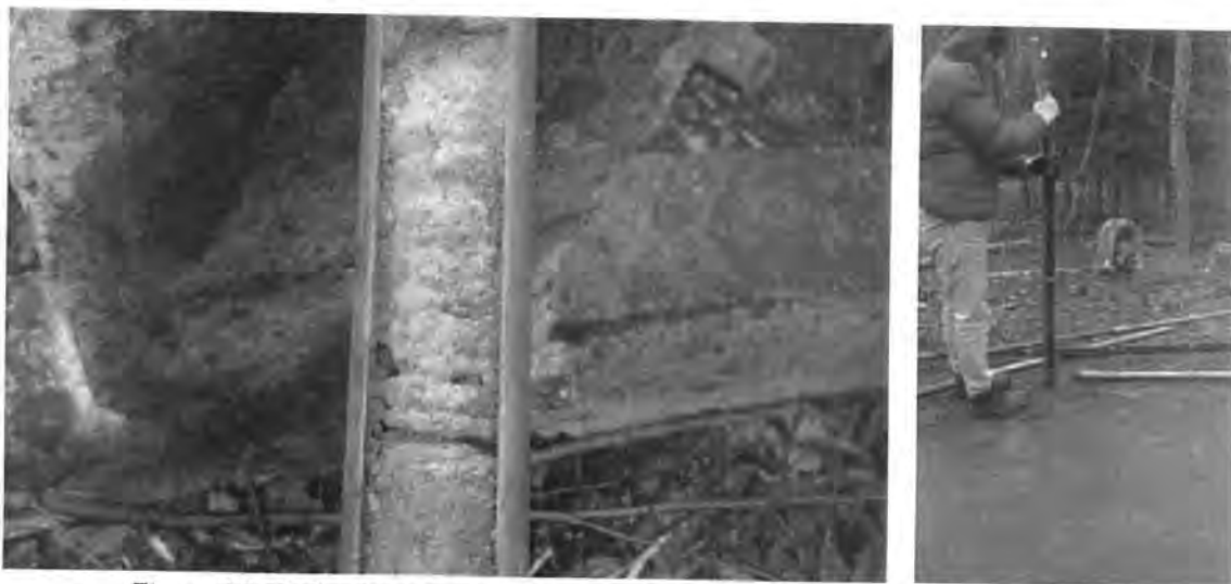
Figura 4.3.50. Realizare foraj geotehnic F50 și prelevarea eșantioanelor de pământ
