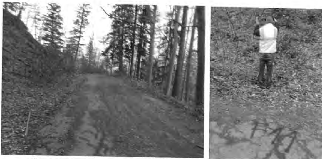
Figura 4.3.11. Realizare foraj geotehnic F11 și prelevarea eșantioanelor de pământ
