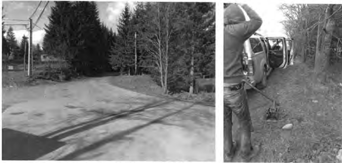
Figura 4.3.32. Realizare foraj geotehnic F32 și prelevarea eșantioanelor de pământ
