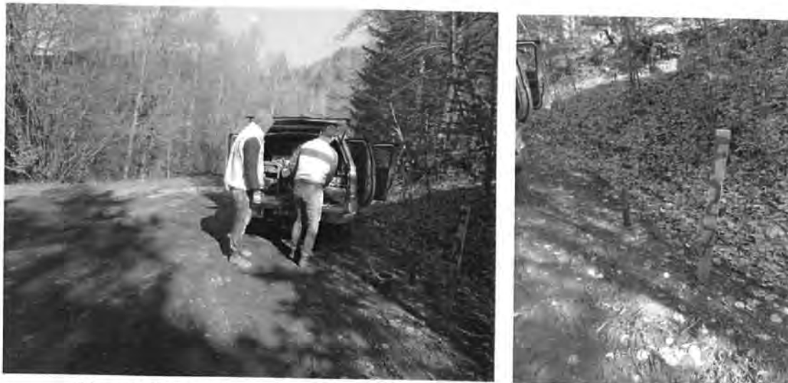
Figura 4.3.27. Realizare foraj geotehnic F27 și prelevarea eșantioanelor de pământ
