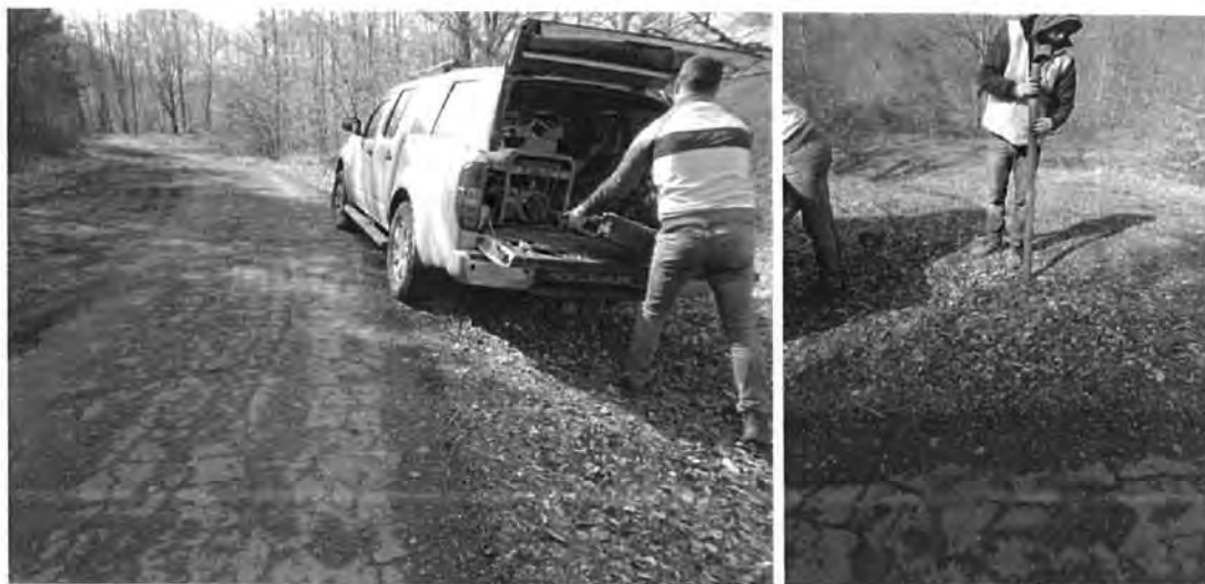
Figura 4.3.22. Realizare foraj geotehnic F22 și prelevarea eșantioanelor de pământ
