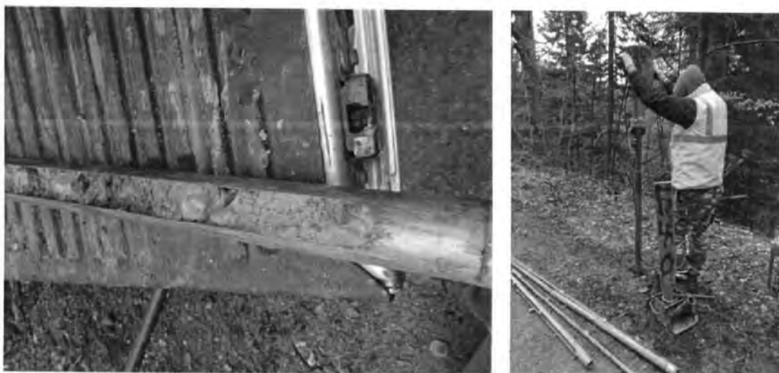
Figura 4.3.40. Realizare foraj geotehnic F40 și prelevarea eșantioanelor de pământ
