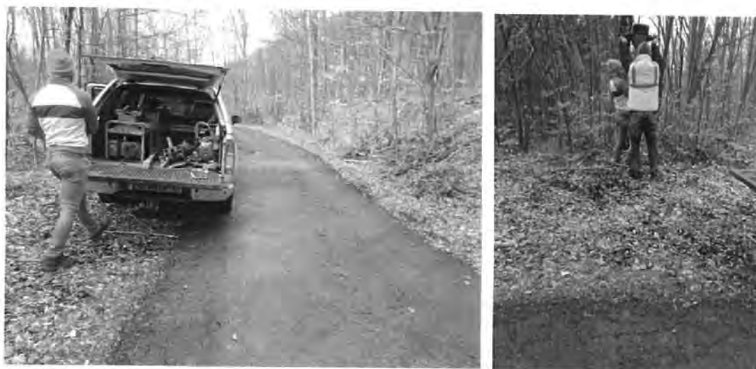
Figura 4.3.19. Realizare foraj geotehnic F19 și prelevarea eșantioanelor de pământ
