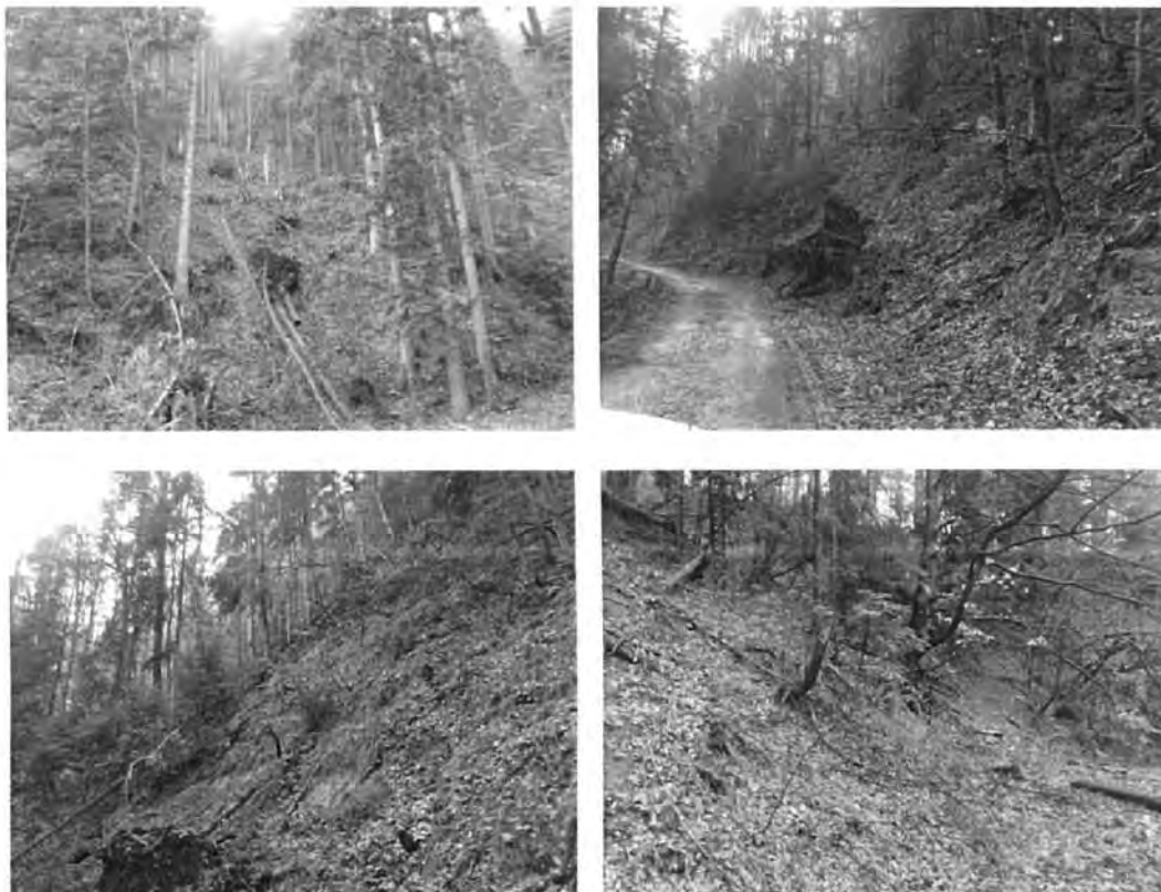
Fig 2.5.9. Zona km 65+340 – km 65+650
