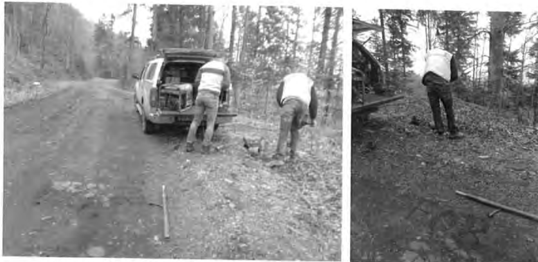
Figura 4.3.8. Realizare foraj geotehnic F08 și prelevarea eșantioanelor de pământ
