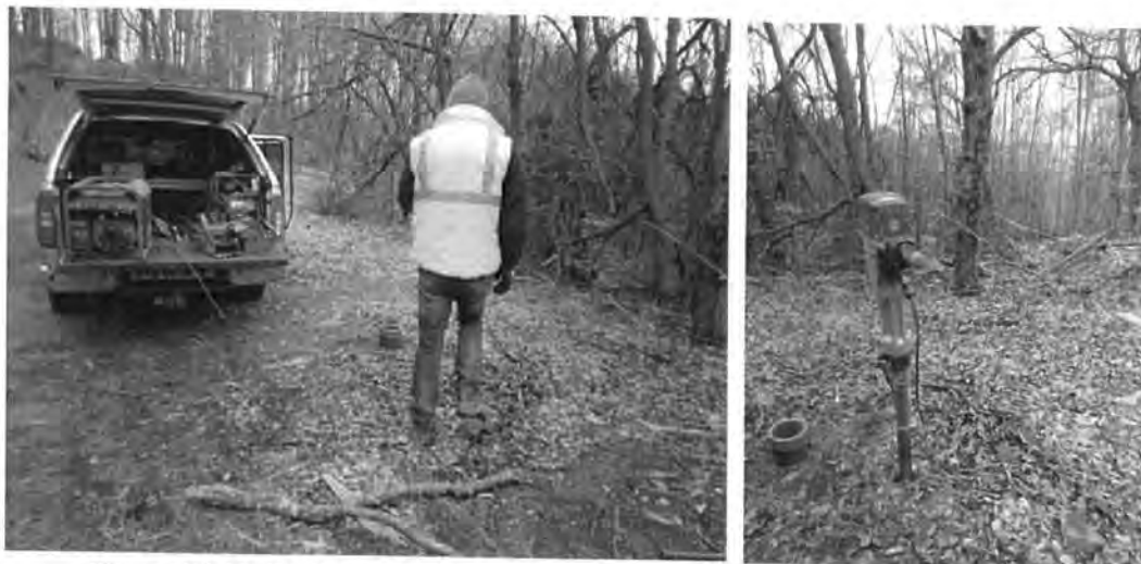
Figura 4.3.18. Realizare foraj geotehnic F18 și prelevarea eșantioanelor de pământ
