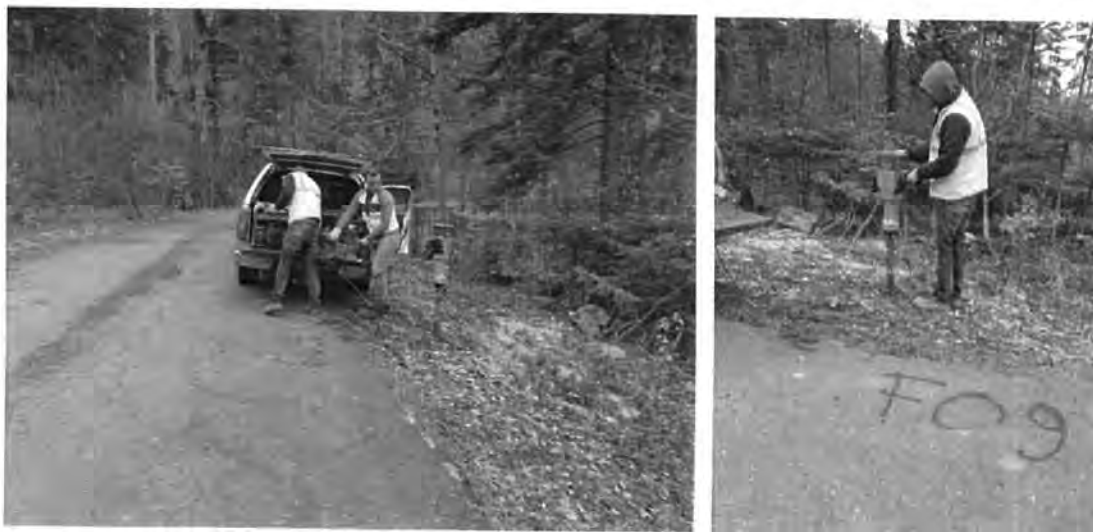
Figura 4.3.9. Realizare foraj geotehnic F09 și prelevarea eșantioanelor de pământ
