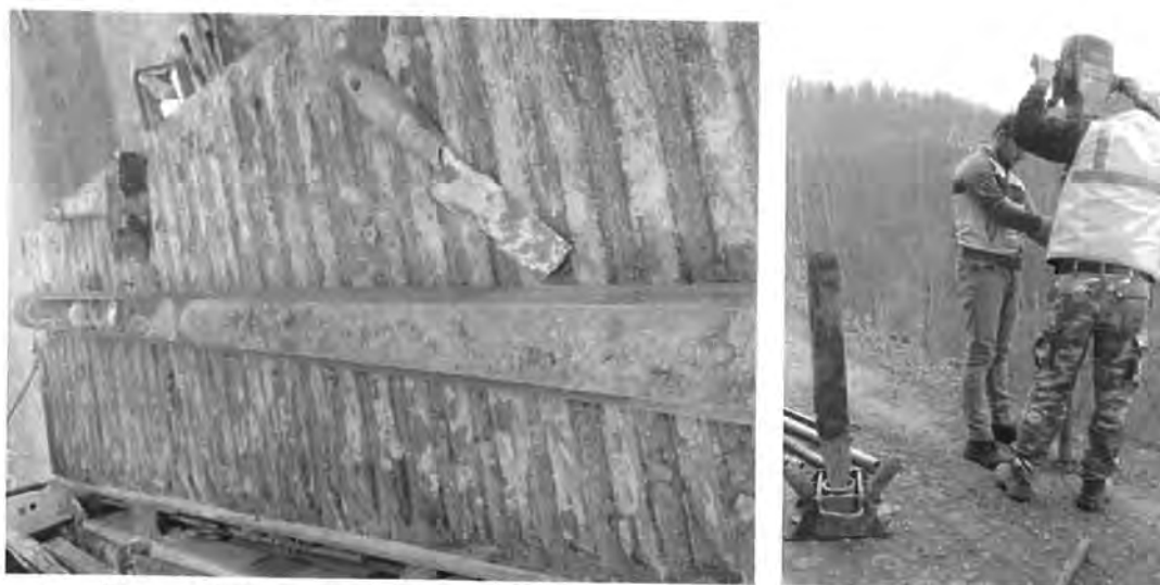
Figura 4.3.48. Realizare foraj geotehnic F48 și prelevarea eșantioanelor de pământ
