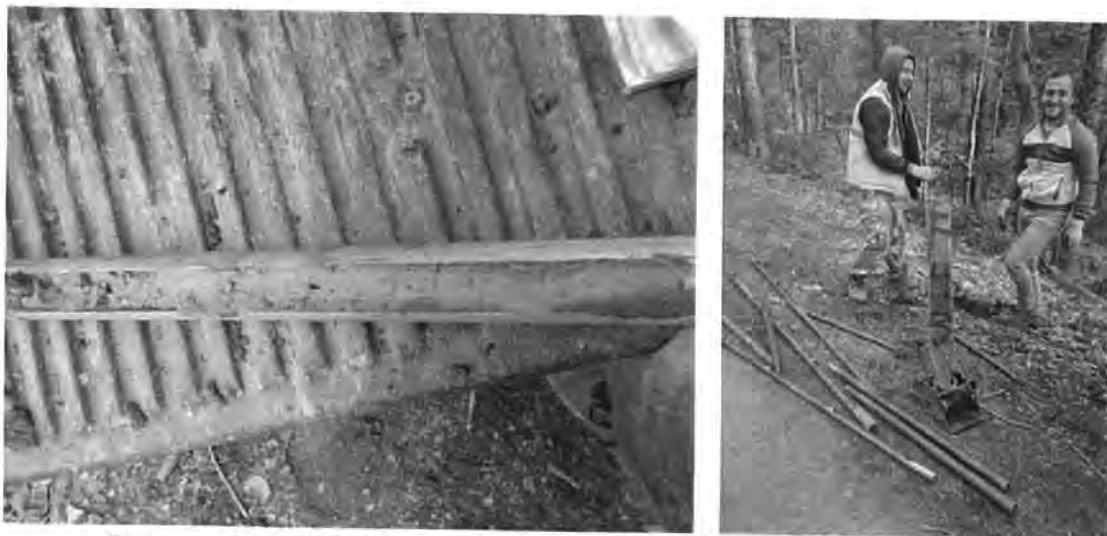
Figura 4.3.43. Realizare foraj geotehnic F43 și prelevarea eșantioanelor de pământ
