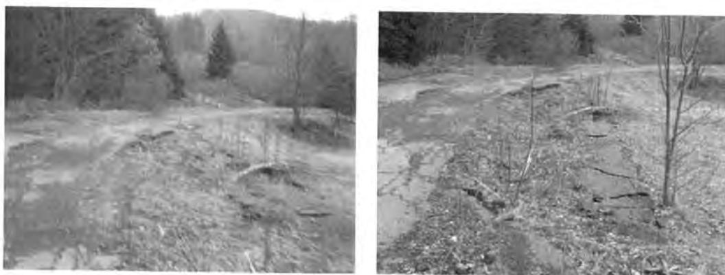
Fig 2.5.16. Zona km 70+300 – km 70+360
