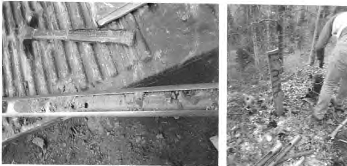
Figura 4.3.37. Realizare foraj geotehnic F37 și prelevarea eșantioanelor de pământ
