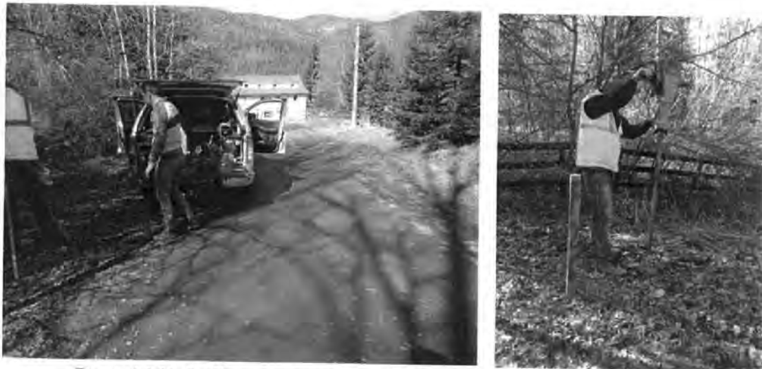
Figura 4.3.26. Realizare foraj geotehnic F26 și prelevarea eșantioanelor de pământ
