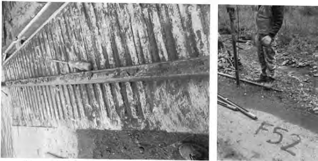
Figura 4.3.52. Realizare foraj geotehnic F52 și prelevarea eșantioanelor de pământ
