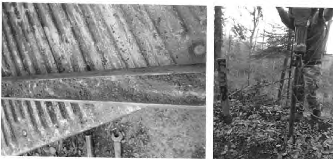
Figura 4.3.38. Realizare foraj geotehnic F38 și prelevarea eșantioanelor de pământ
