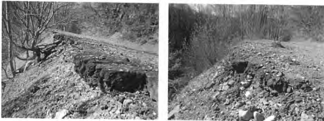
Fig 2.5.19. Structura rutieră existentă
