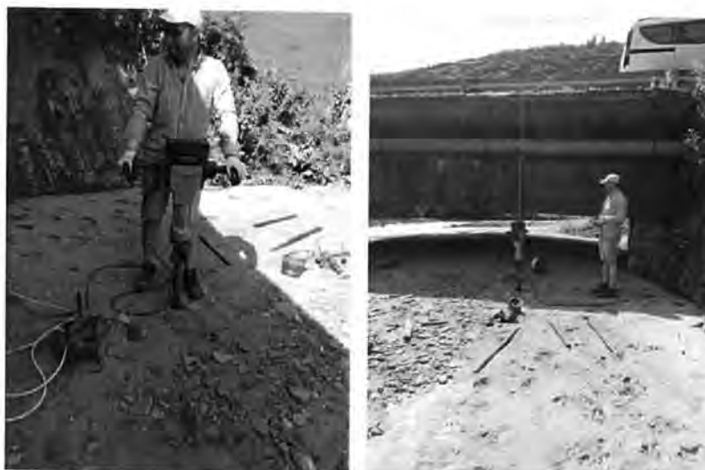
Figura 4.3.53. Realizare foraj geotehnic F53 și prelevarea eșantioanelor de pământ
