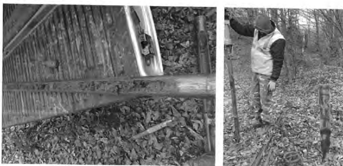
Figura 4.3.47. Realizare foraj geotehnic F47 și prelevarea eșantioanelor de pământ
