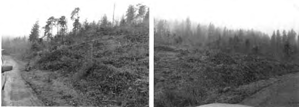
Fig 2.5.4. Zona km 62+700 – km 63+200
