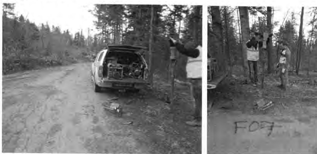
Figura 4.3.7. Realizare foraj geotehnic F07 și prelevarea eșantioanelor de pământ
