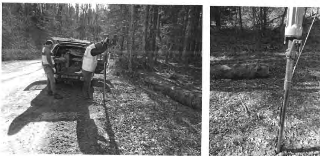
Figura 4.3.28. Realizare foraj geotehnic F28 și prelevarea eșantioanelor de pământ
