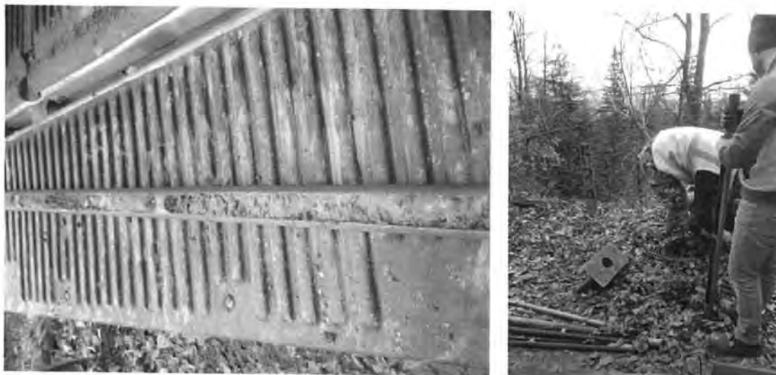
Figura 4.3.39. Realizare foraj geotehnic F39 și prelevarea eșantioanelor de pământ
