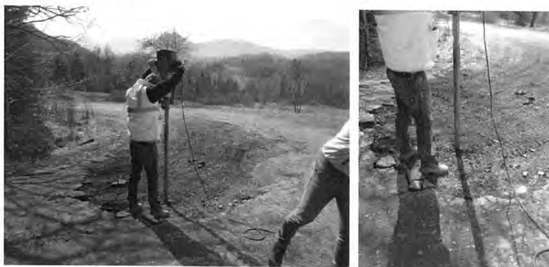
Figura 4.3.23. Realizare foraj geotehnic F23 și prelevarea eșantioanelor de pământ
