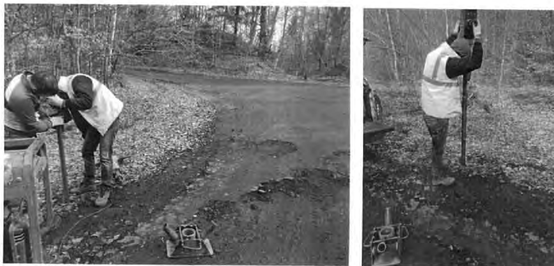
Figura 4.3.25. Realizare foraj geotehnic F25 și prelevarea eșantioanelor de pământ
