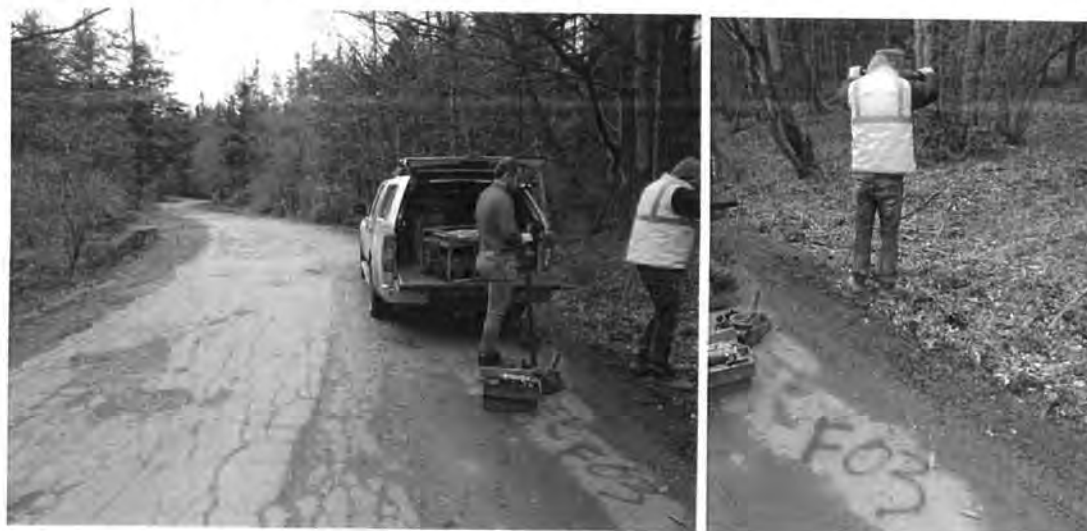
Figura 4.3.3. Realizare foraj geotehnic F03 și prelevarea eșantioanelor de pământ
