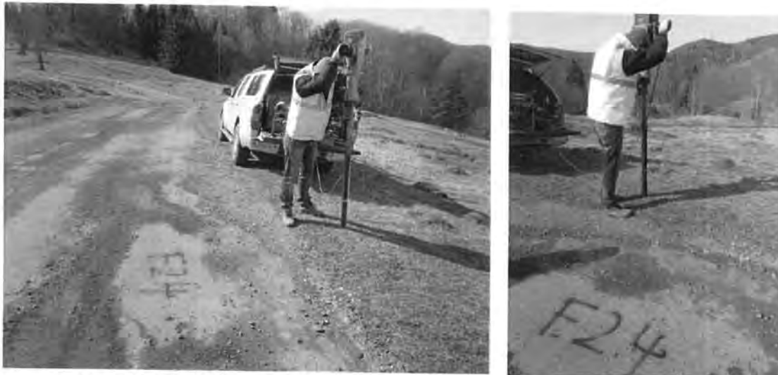
Figura 4.3.24. Realizare foraj geotehnic F24 și prelevarea eșantioanelor de pământ
