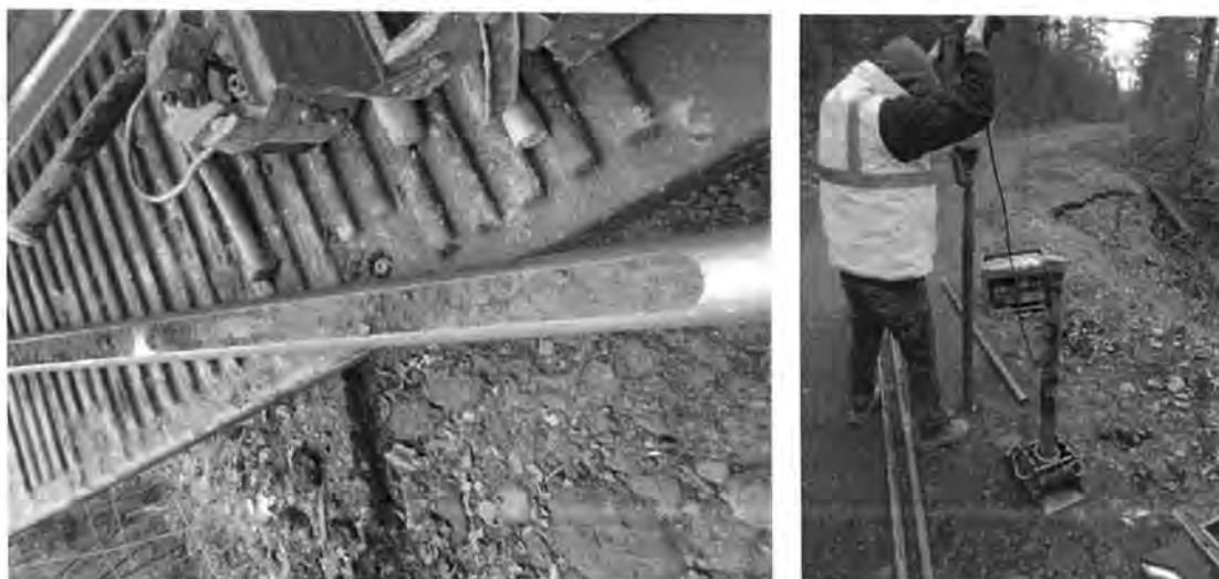
Figura 4.3.36. Realizare foraj geotehnic F36 și prelevarea eșantioanelor de pământ
