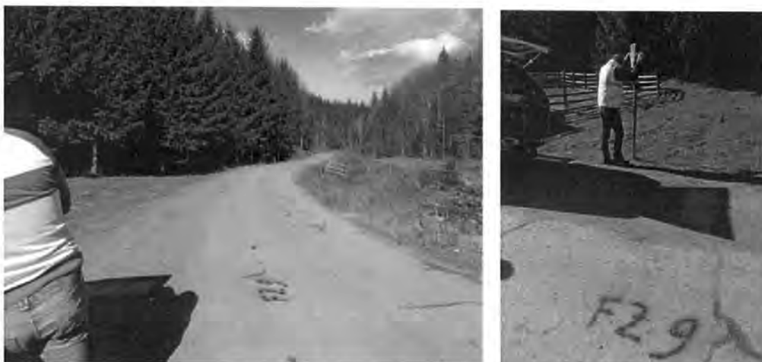
Figura 4.3.29. Realizare foraj geotehnic F29 și prelevarea eșantioanelor de pământ
