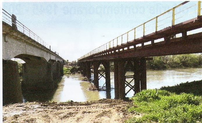
Foto 8 - Pod provizoriu - în așteptarea traficului
