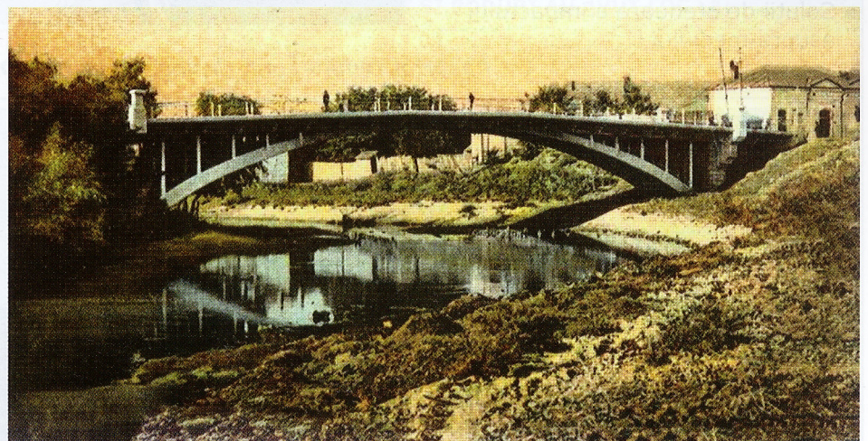
Podul de la Tecuci peste râul Bârlad. Pod din beton armat cu boltă dublă, cu o deschidere de 50 de metri - unicat în România (construit în anul 1912).
