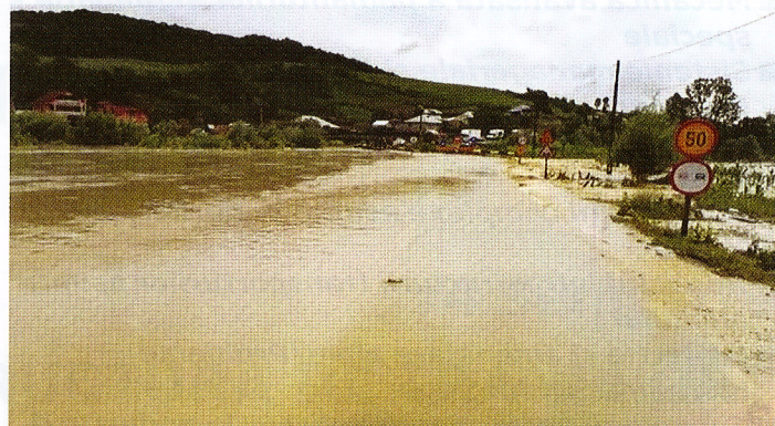
Inundații în zona podului de la Străminoasa, DN 2F
