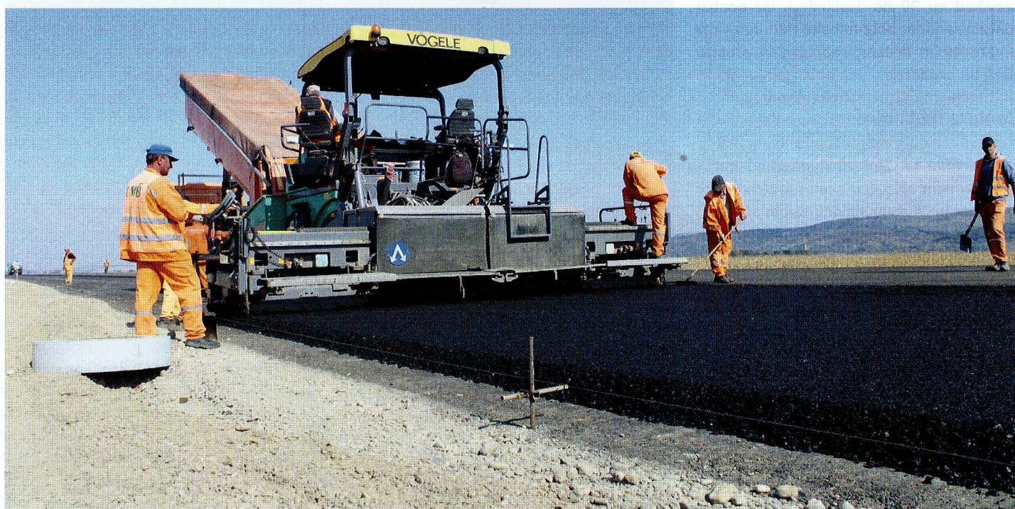
Figura 6 - Lucrări la Centura Rădăuți.
