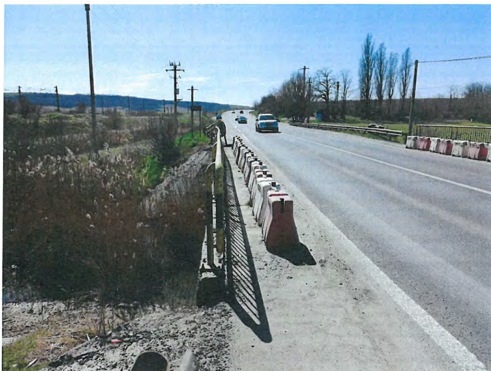
Foto 9 – Vedere cale pe pod
