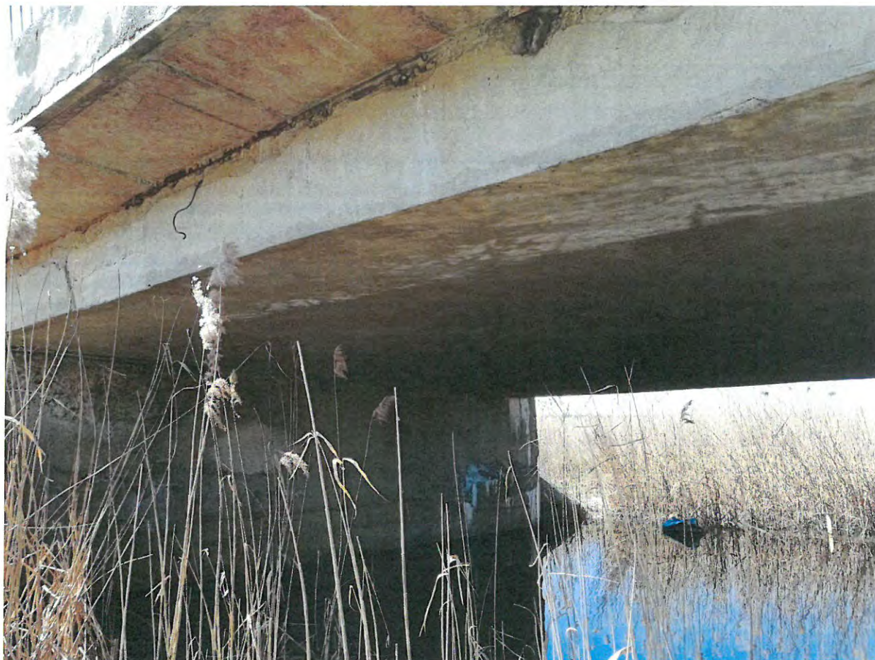
Foto 5 – Vedere intrados suprastructură
