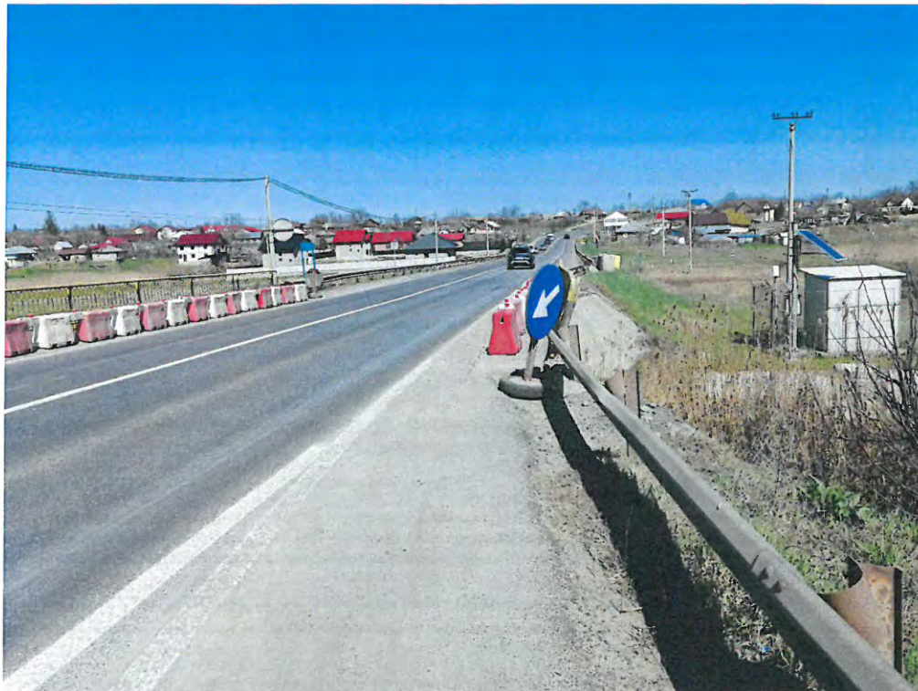
Foto 1 – Vedere generală cale pe pod
