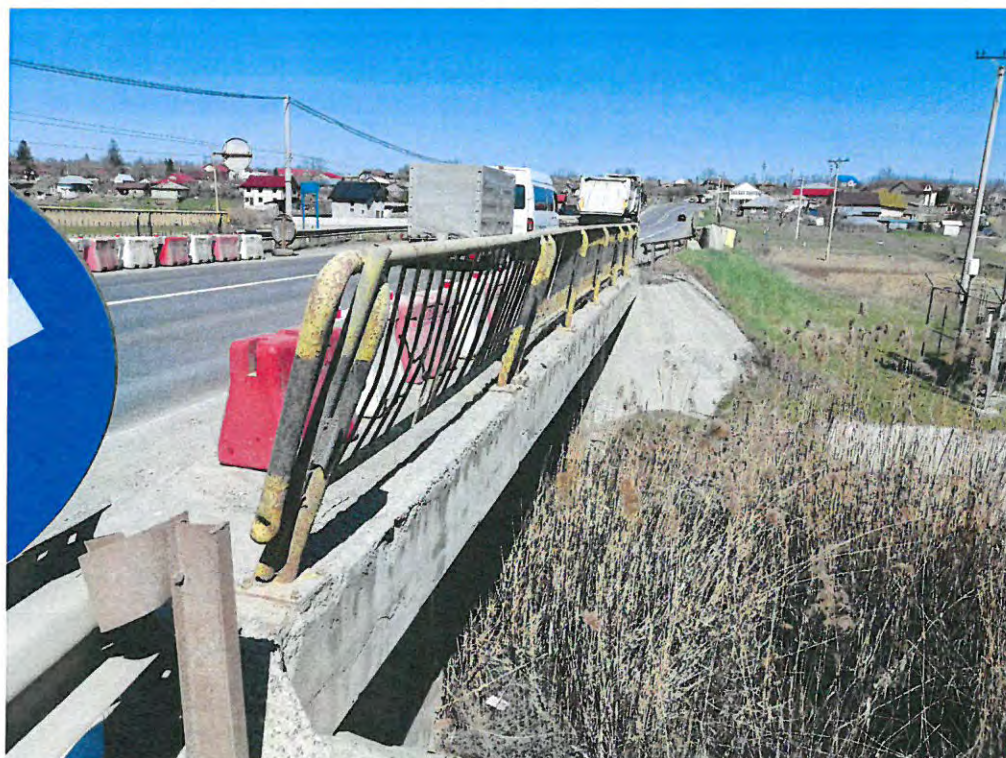
Foto 2 – Degradarea trotuarului
