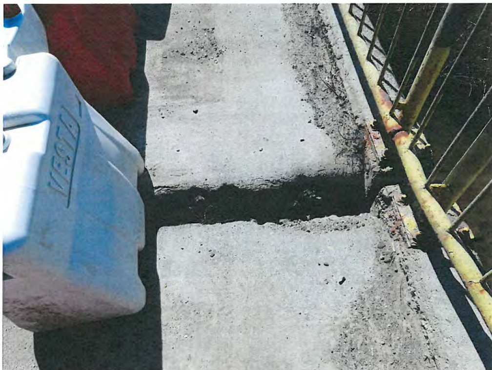
Foto 8 – Vedere cale pe trotuare
