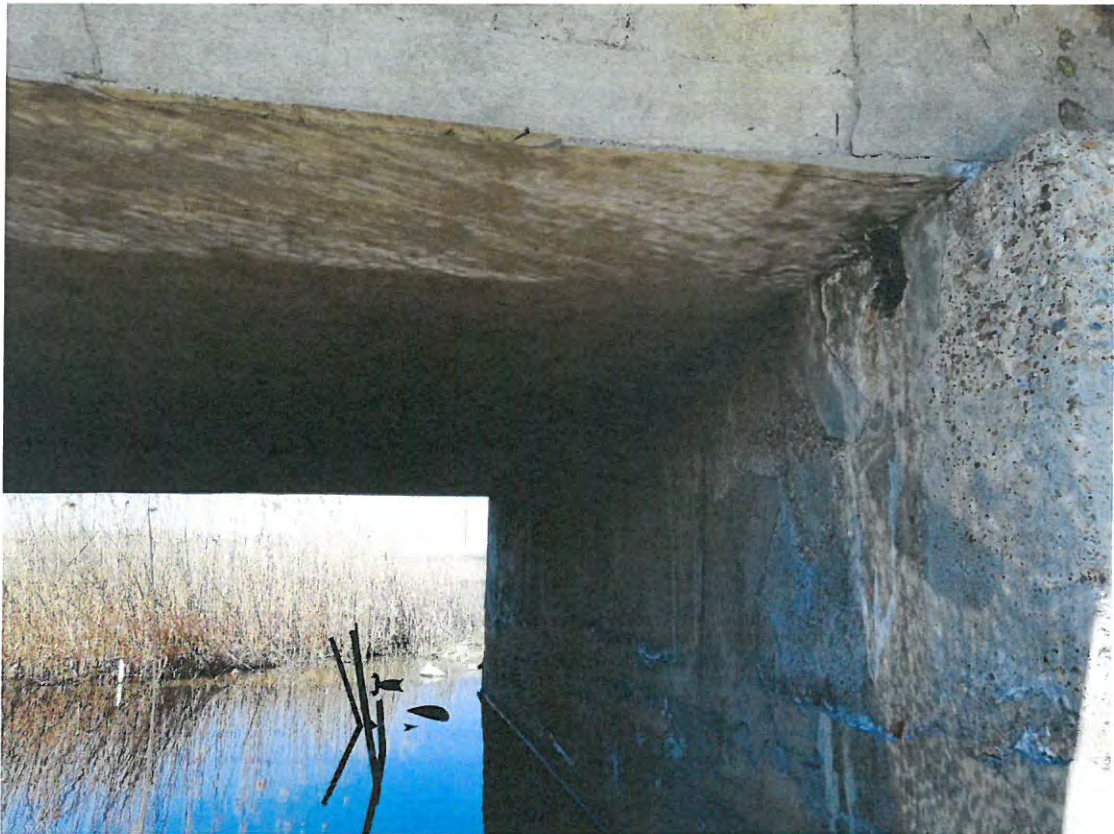
Foto 3 – Vedere elevație culee
