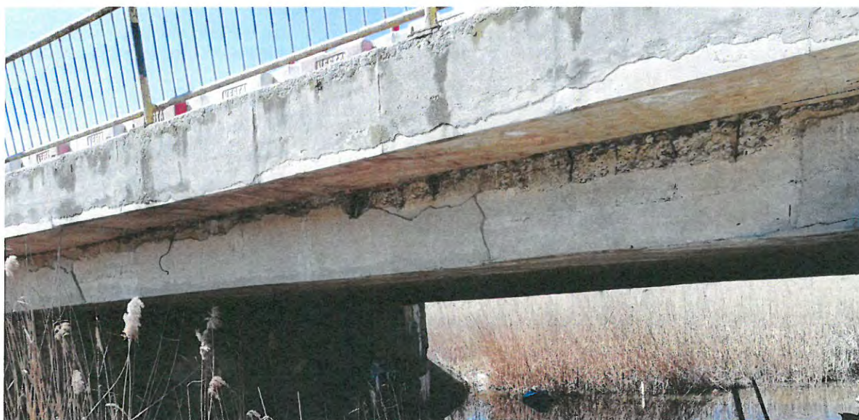
Foto 6 – Vedere longitudinală suprastructură
