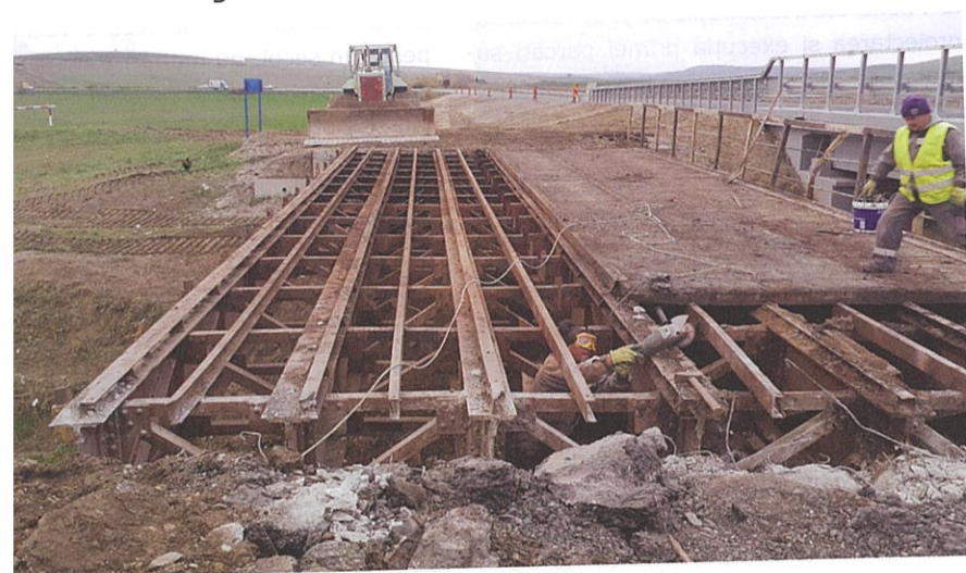
Fig. 3 - Podul vechi a fost dezamblat
