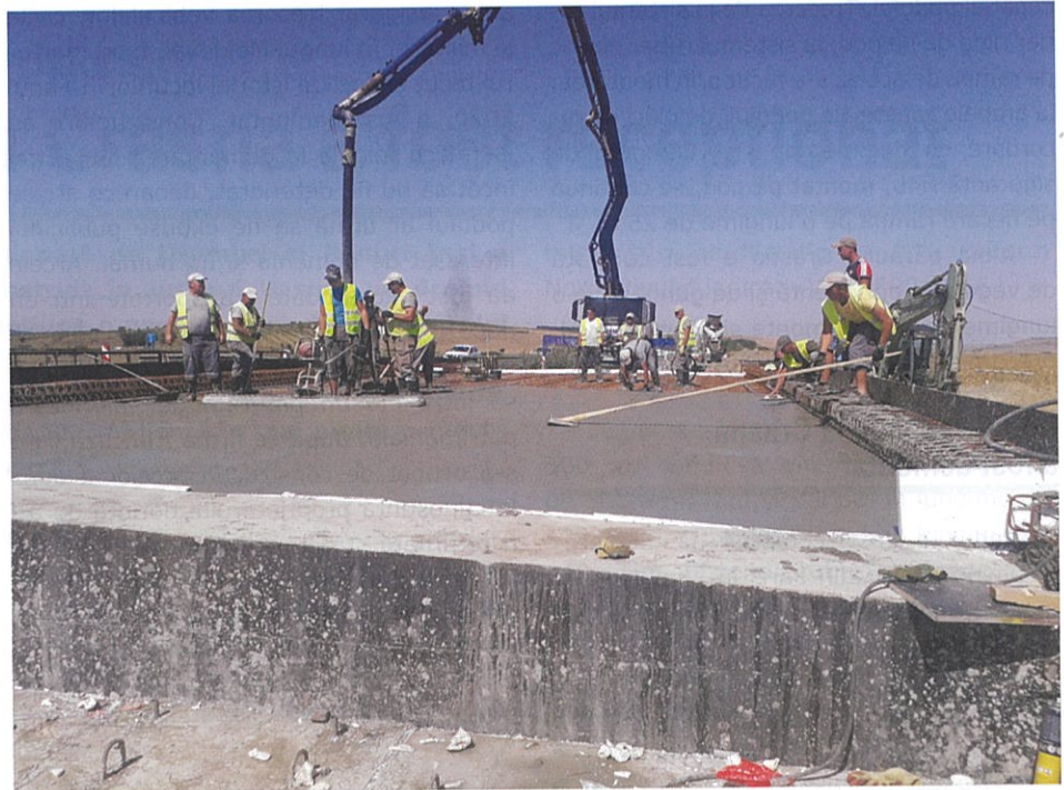
Fig. 5 - Aspecte de la lucrările noului pod
