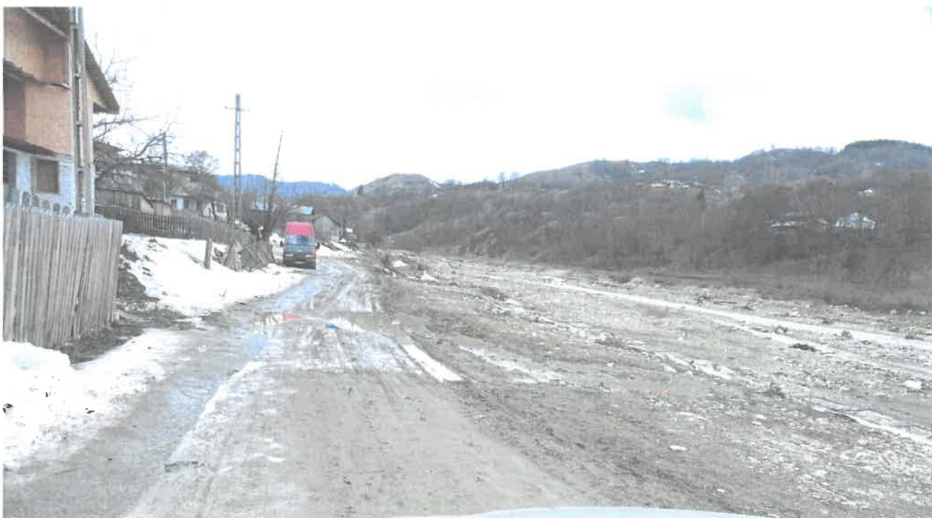
Paralelism cu valea Râmnicului Sărat Se observă șirul de gabioane dintre cursul apei și drum
